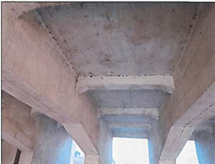
podhled trémové části mezi příčnicí
