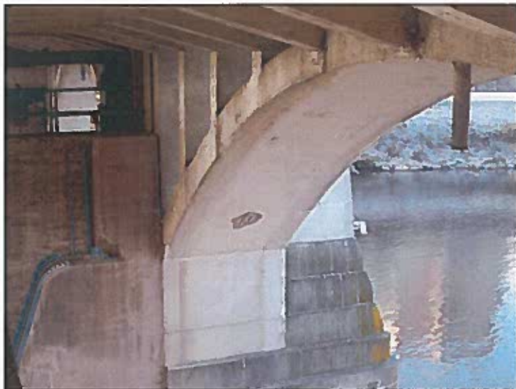
podhled obloukového pasu
