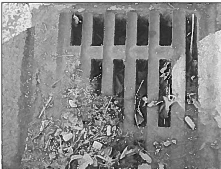
zanesený odvodňovač
