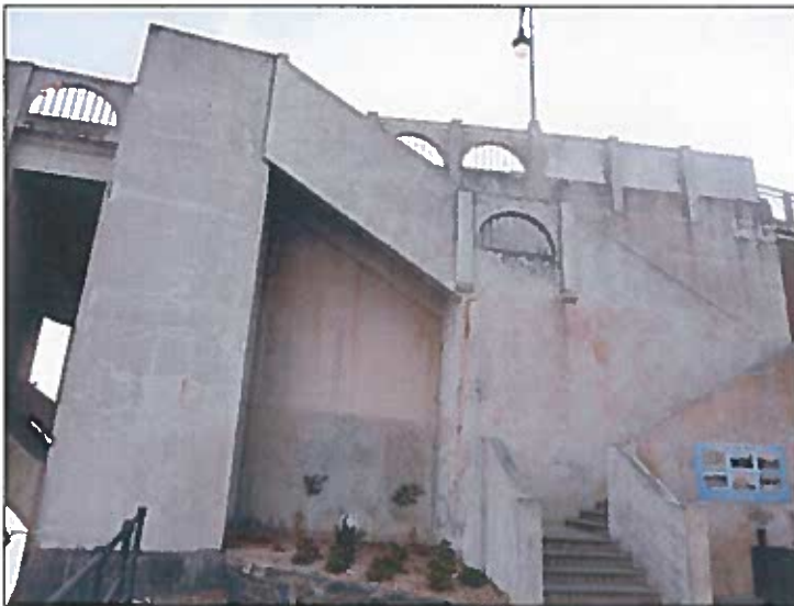
pohled na opěru O1
