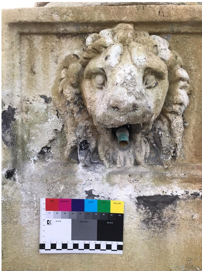
Obr. 2. Poškození nátěru na povrchu kamene a depozice biologického osídlení ve vzniklých kavernách
