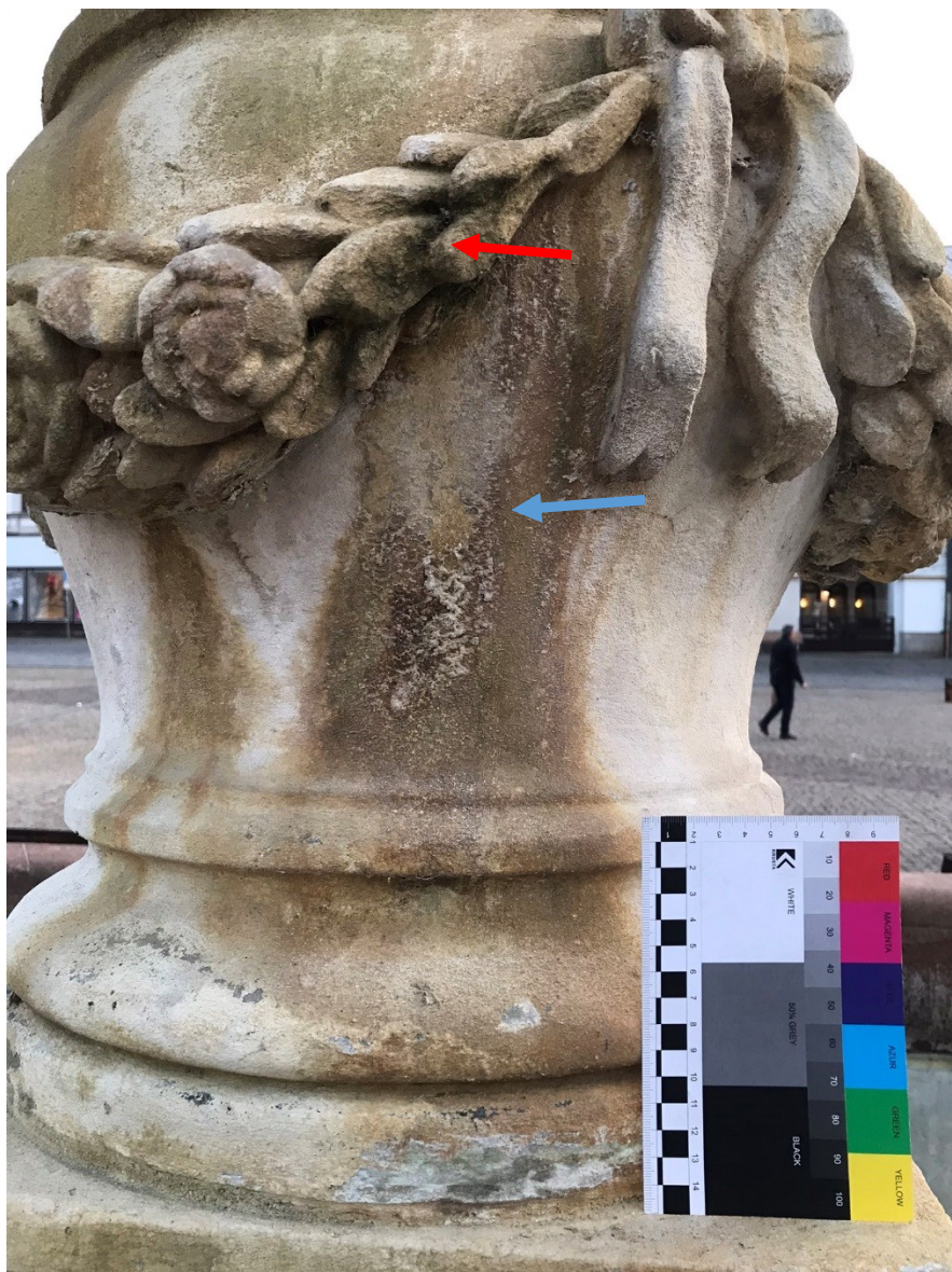
Obr. 3. Biologické osídlení povrchu kamene – řasy ve fázi růstu (červená šipka), řasy ve fázi dehydratace (modrá šipka)
