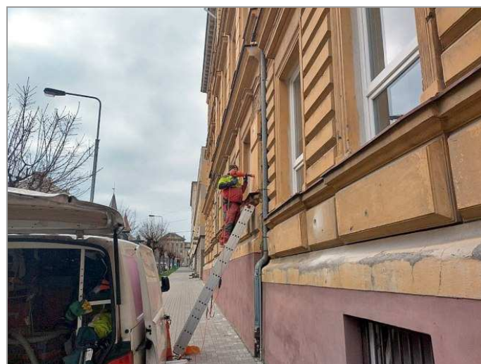
foto 21: Realizace jádrového vývrtu V-5
