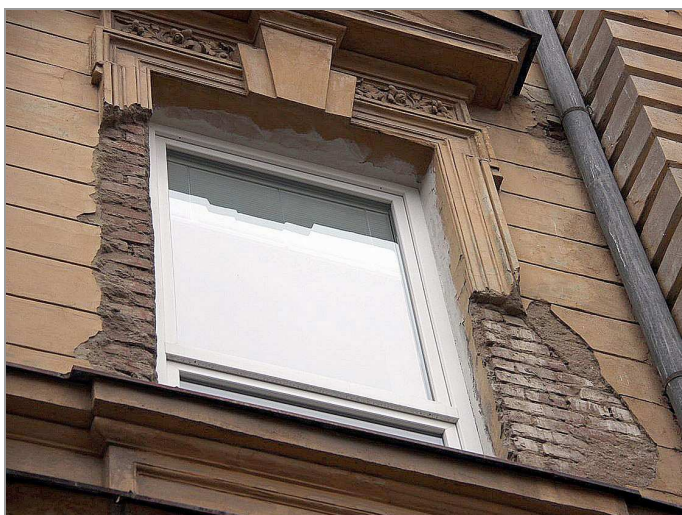
foto 12, 13: Detail lokálních poruch omítky fasády
