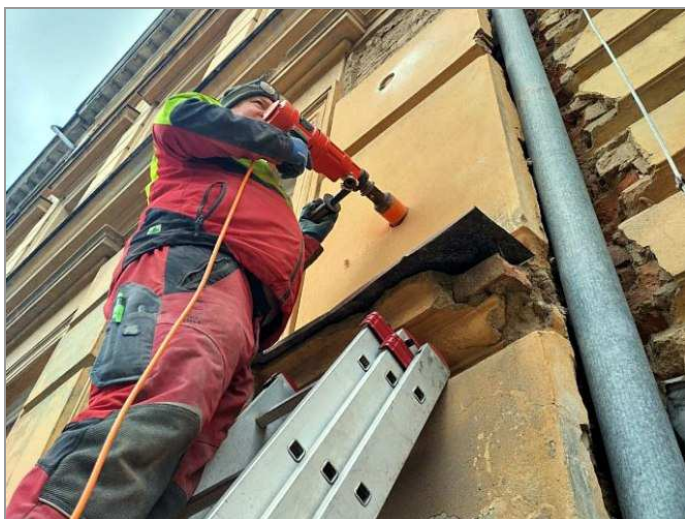
foto 22: Realizace jádrového vývrtu V-5
