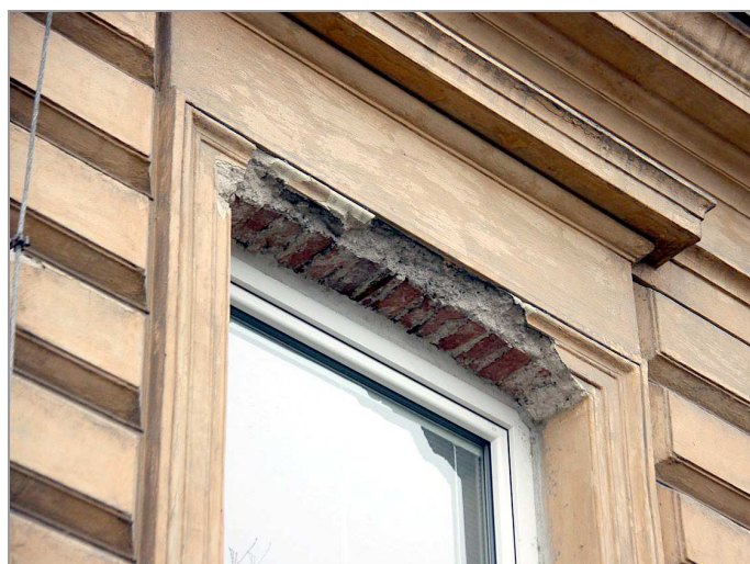
foto 16, 17: Detail lokálních poruch omítky fasády
