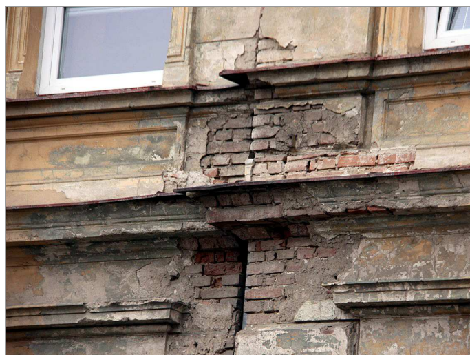
foto 12, 13: Detail lokálních poruch omítky fasády
