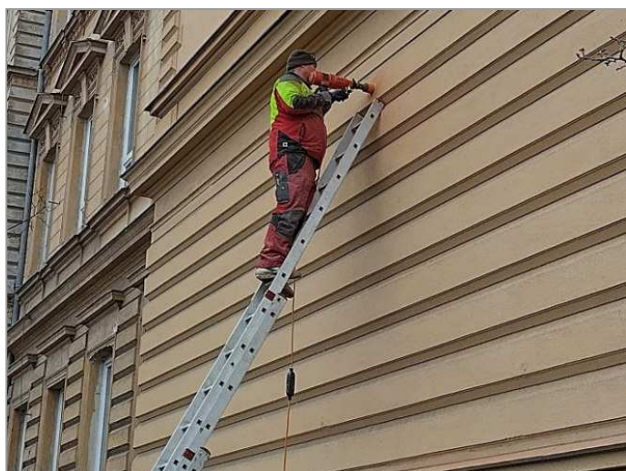
foto 27: Realizace jádrového vývrtnu V-28
