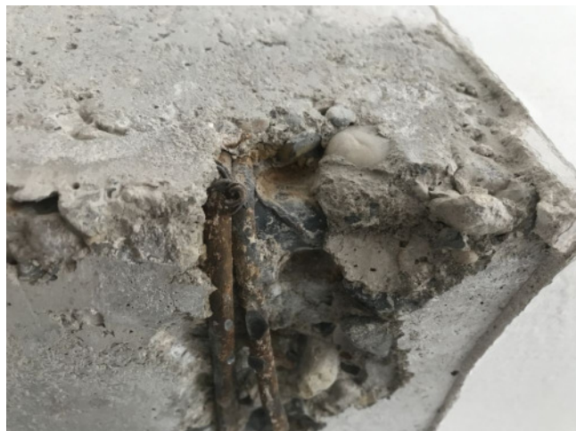
foto/5/ Detail zjištěné výztuže
