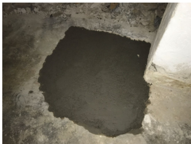
foto/47/ Pohled na zapravenou sondu K2
