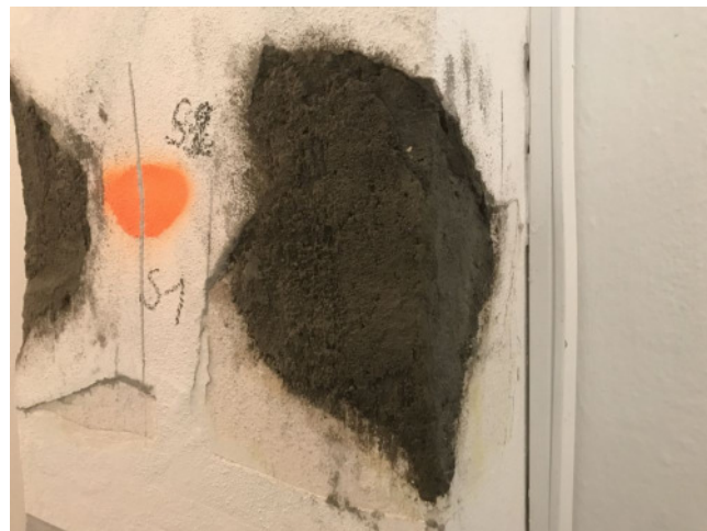
foto/25/ Zapravení provedené sondy
