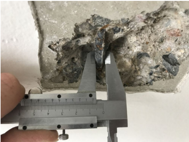
foto/32/ Průměr jednotlivých prutů výztuže (8 mm)
