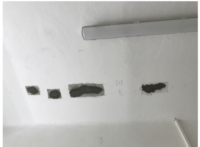
foto/35/ Zapravení provedené sondy D1
