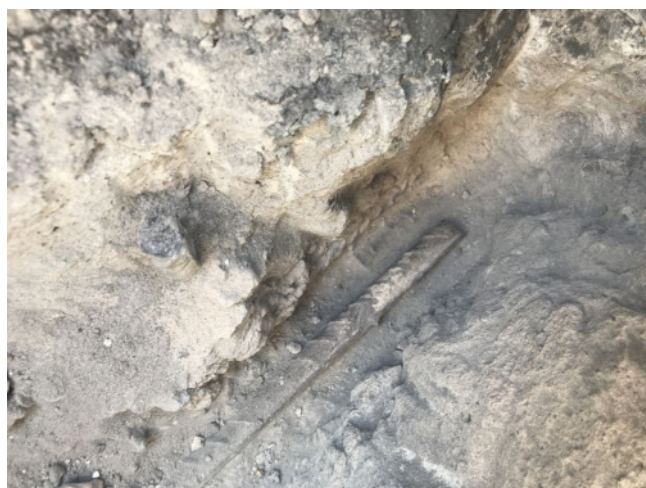
foto/19/ Navaření prutu na ocelovou desku
