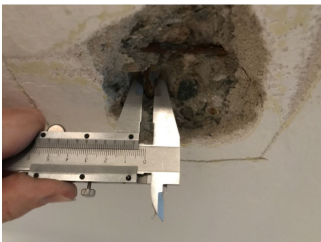
foto/38/ Průměr výztuže svařované sítě (6 mm)
