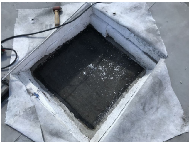
foto/14/ Zapravení původních asfaltových pásů
