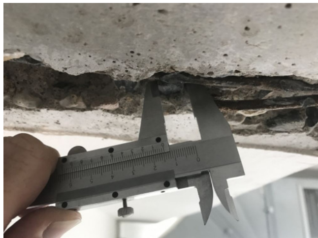
foto/3/ Zjištěný průměr hl. nosné výztuže (14 mm)
