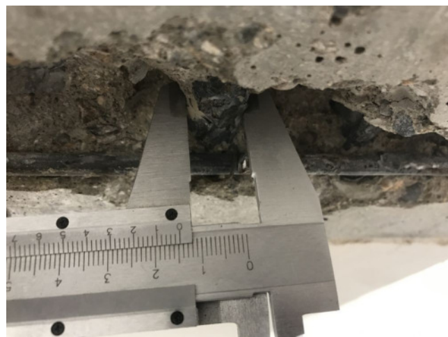
foto/7/ Zjištěný průměr hl. nosné výztuže (14 mm)
