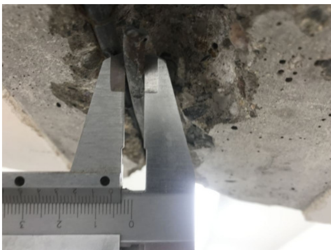
foto/8/ Zjištěný průměr třmíneků (6 mm)
