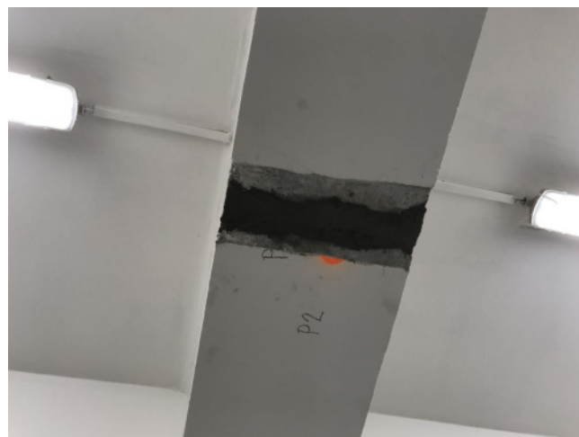
foto/9/ Zapravení provedené sondy
