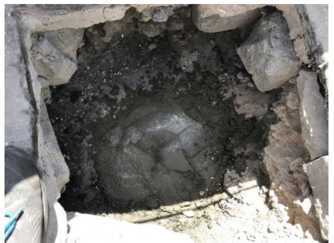
foto/13/ Zapravení ŽB konstrukce
