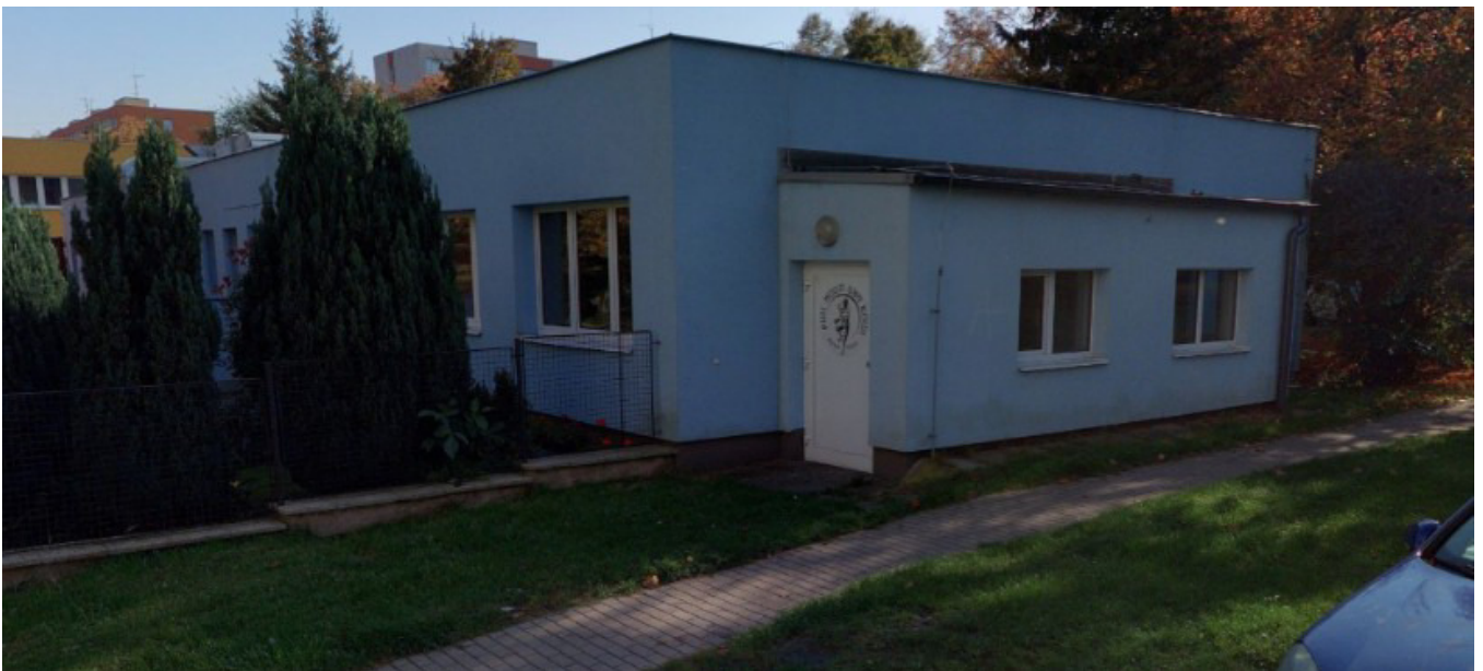
foto/1/ Pohled na objekt
