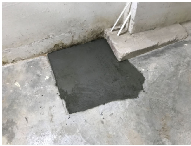
foto/43/ Zapravená sonda K1
