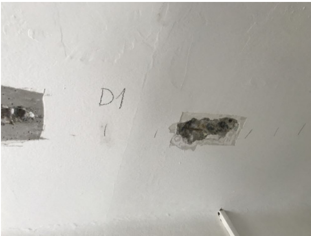
foto/30/ Deska D1 – rozhraní panelů
