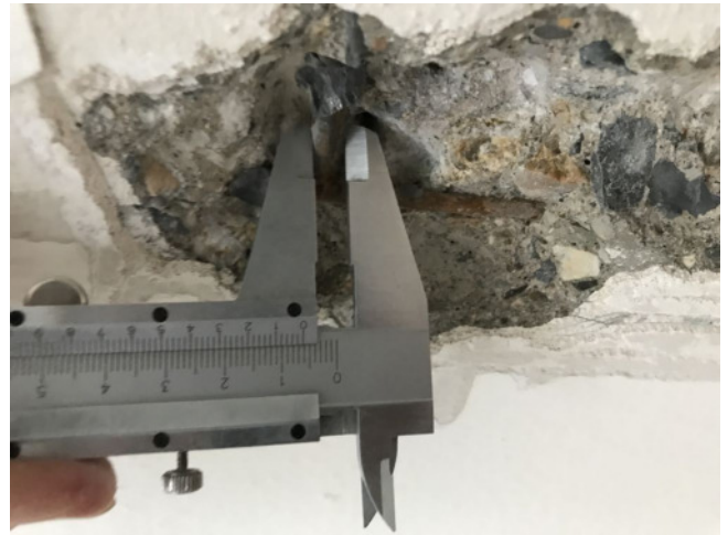
foto/33/ Průměr výztuže svařované sítě (6 mm)
