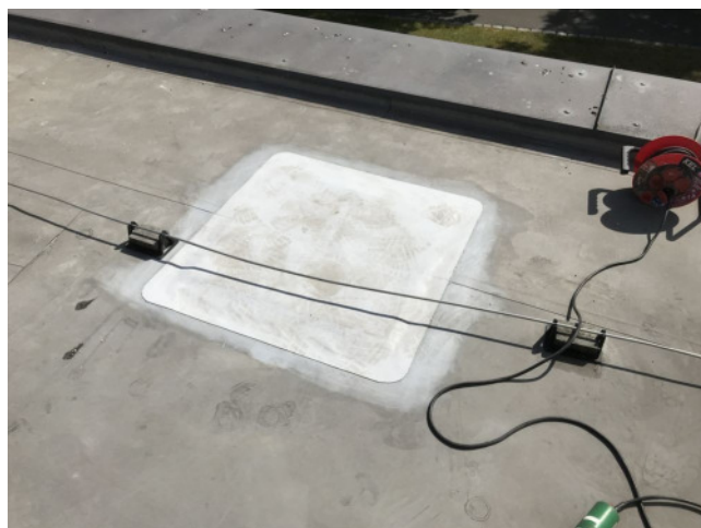
foto/15/ Zapravení provedené sondy
