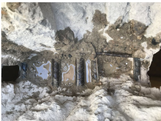
foto/18/ Zjištěná horní výztuž
