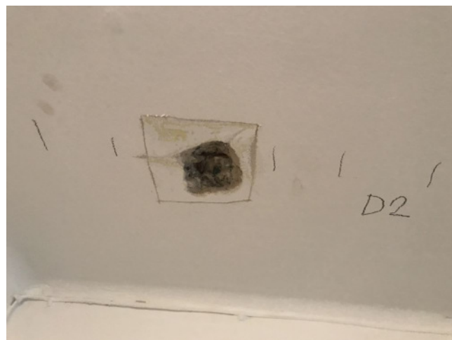
foto/37/ Provedená sonda do panelu D2
