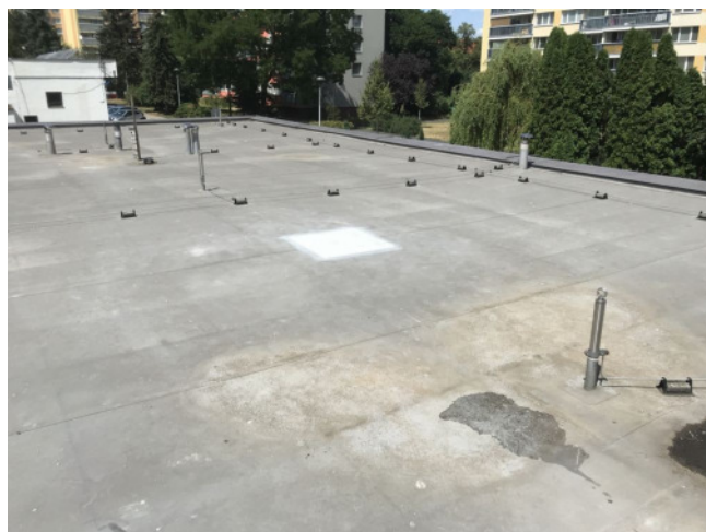
foto/21/ Zapravení provedené sondy
