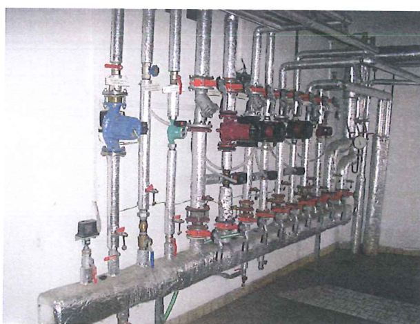
Rozdělovač/sběrač s jednotlivými okruhy otopné soustavy
