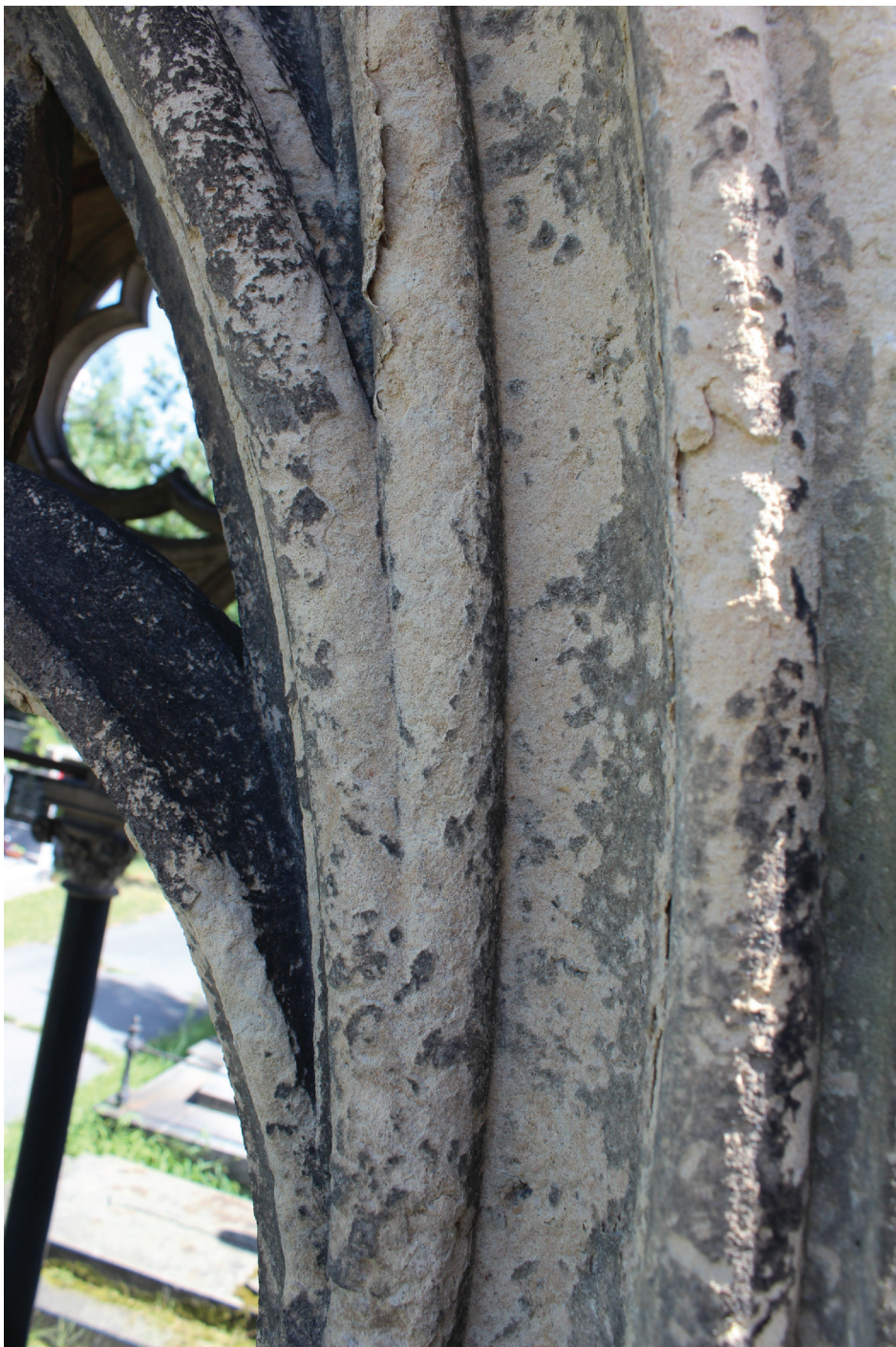
17. Degradace kamene náběhu kružby JV strany hrobky
