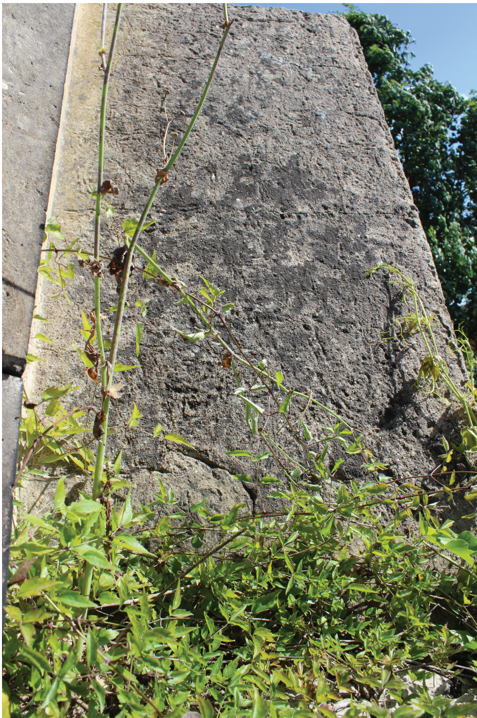
19. Menší štít severní fasády, svrchní plocha zděného prvku narušená trhlí- namí
