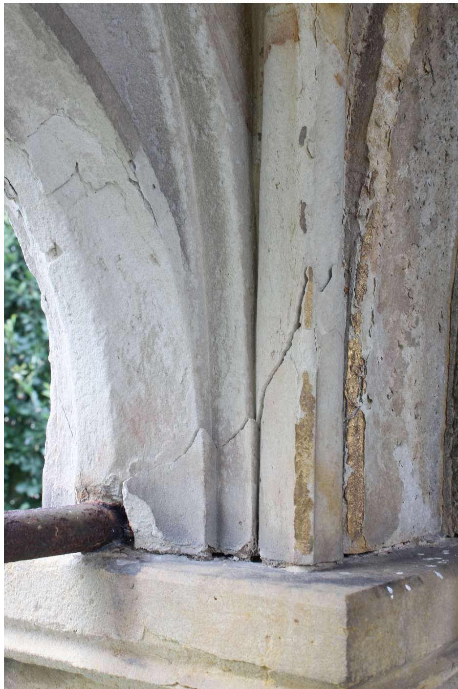
10. Poškození v místě paty klenebního oblouku a kružby v důsledku koroze kovového táhla. Na náběžných hranách profilace patrné zbytky zlacení
