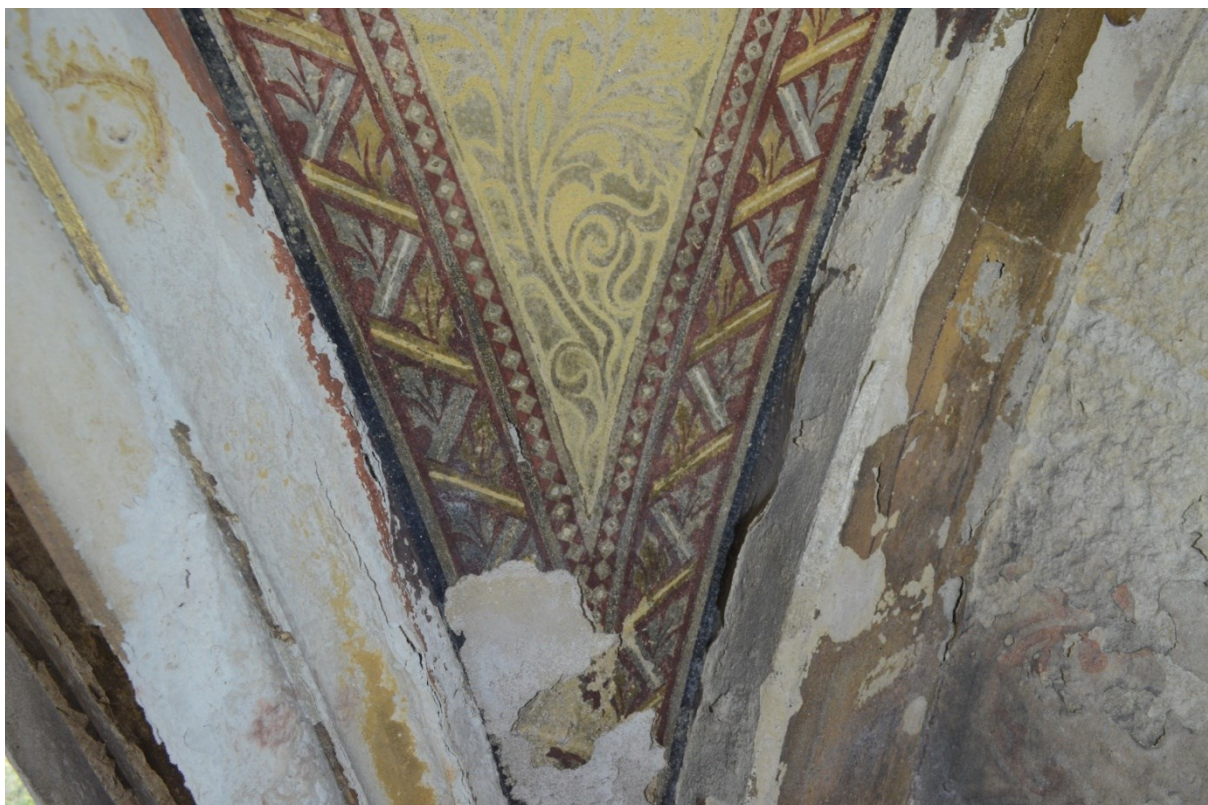
Obr. 8 Detail poškození v nejnižší části klenební výseče.
