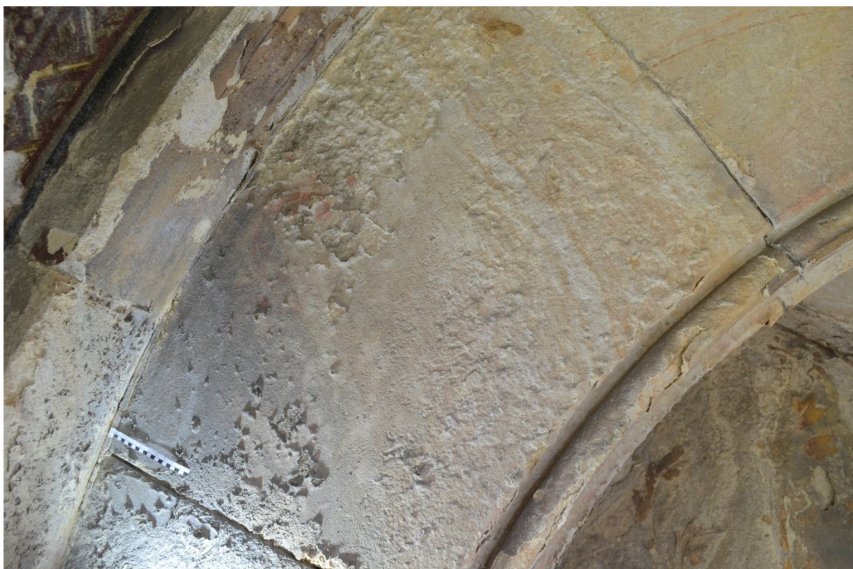
Obr. 19 Stěna v bočním světle, povrch kamene musí být restaurován až poté může být rekonstruován šablonový dekor, patrný na následujícím snímku.
