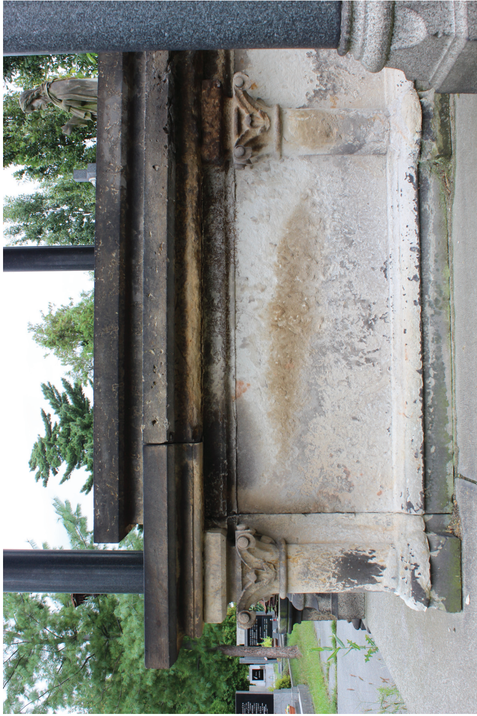
11. Hlubková degradace kamene způsobující ztráty povrchové modelace u hlavice JV strany gloriety
