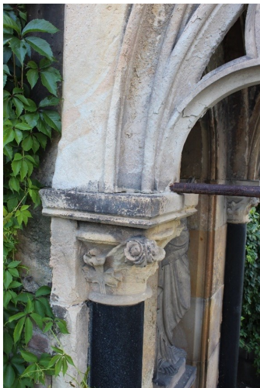
Obr. 1 Degradace pískovcového materiálu v oblasti lomených oblouků s kružbou, SZ a JV strana
