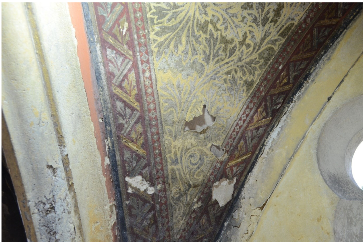
Obr. 10 Detail poškození v nejnižší části klenební výseče.
