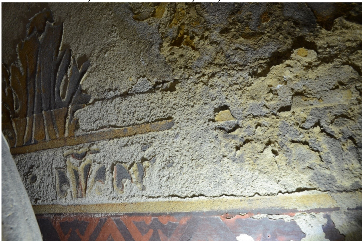
Obr. 13 Detail dekorativní výzdoby v nice v bočním světle, omítková i barevné vrstvy v pokročilé fázi rozpadu.
