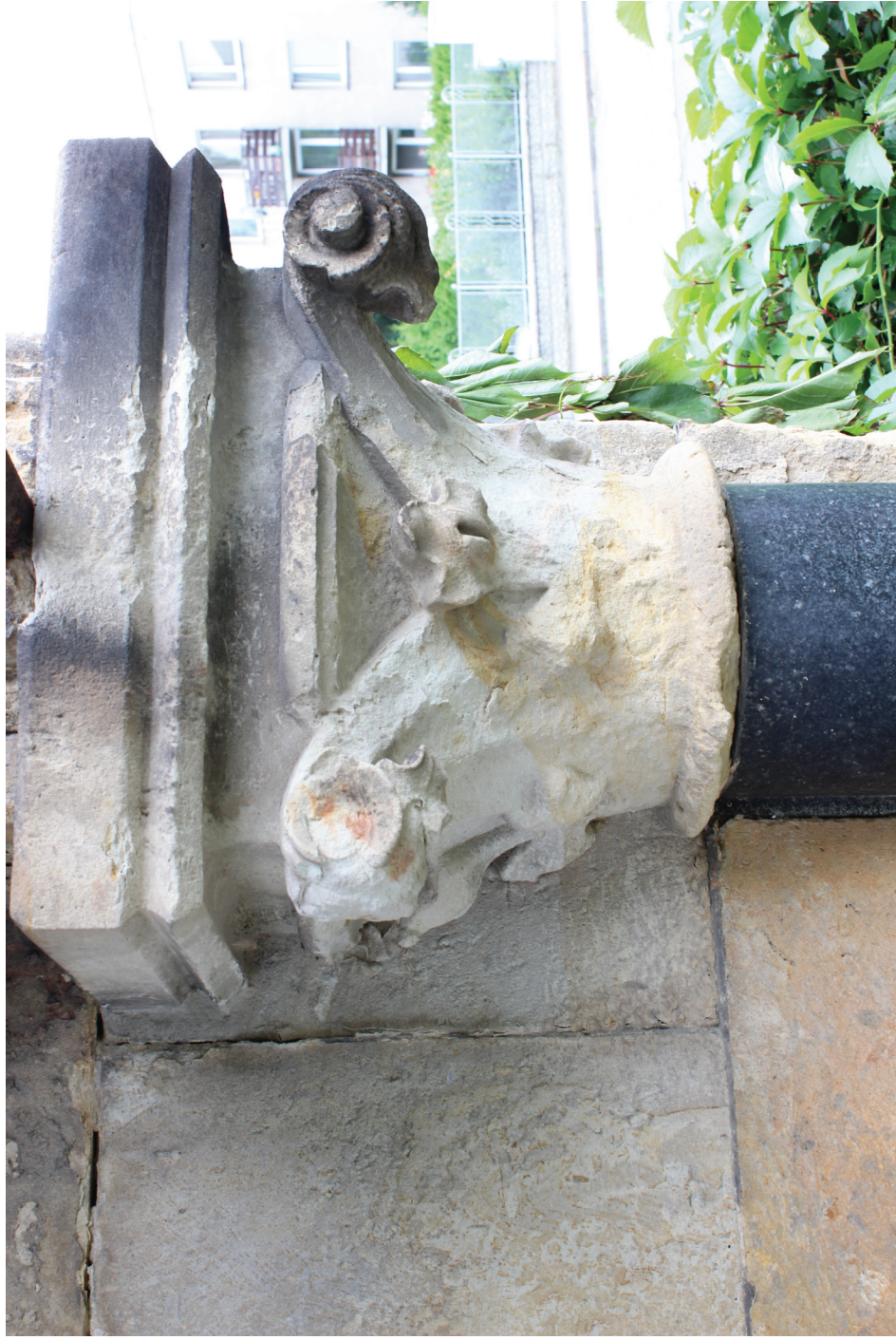
11. Hlubková degradace kamene způsobující ztráty povrchové modelace u hlavice JV strany gloriety
