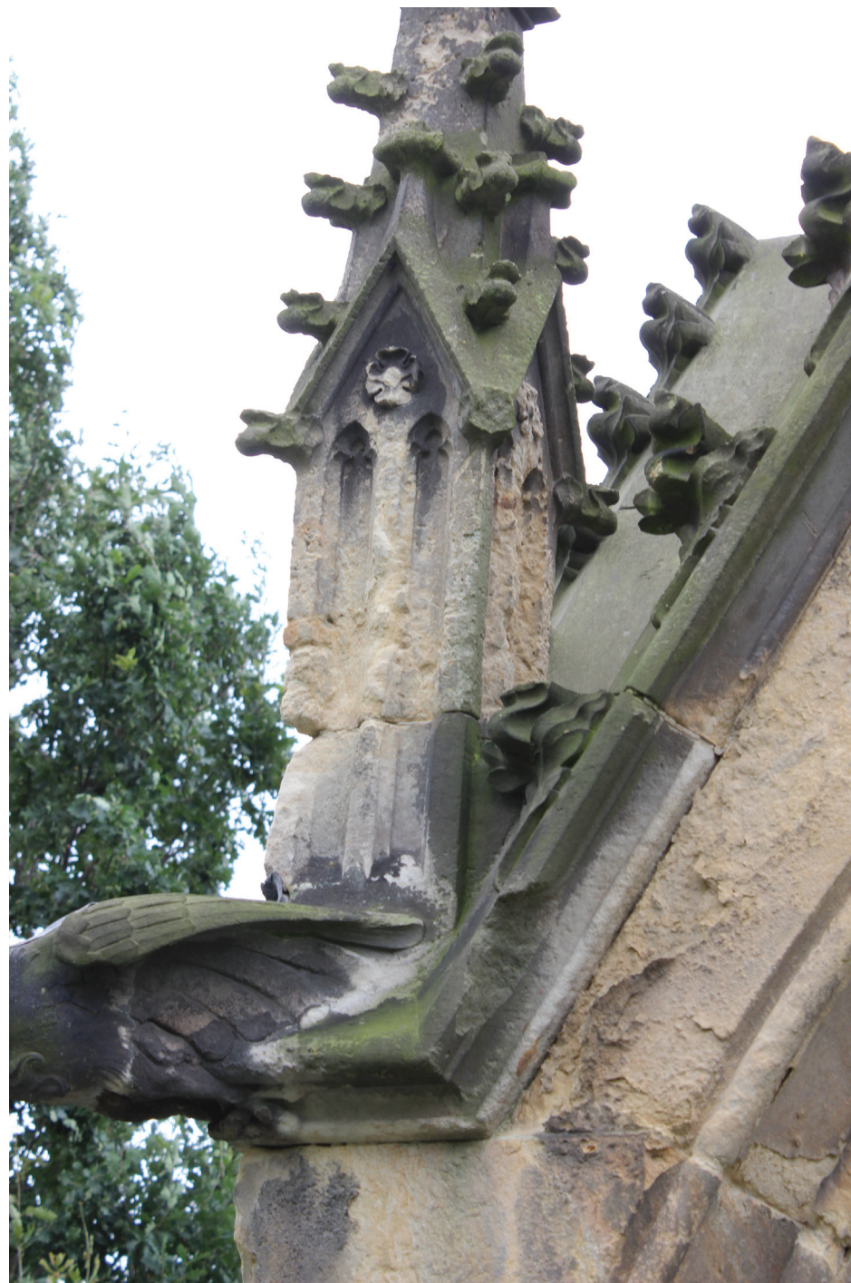
14. Silně narušený kámen v místě kontaktu dvou dílů fiály. u horního dílu je úbytkem materiálu narušena jeho stabilita
