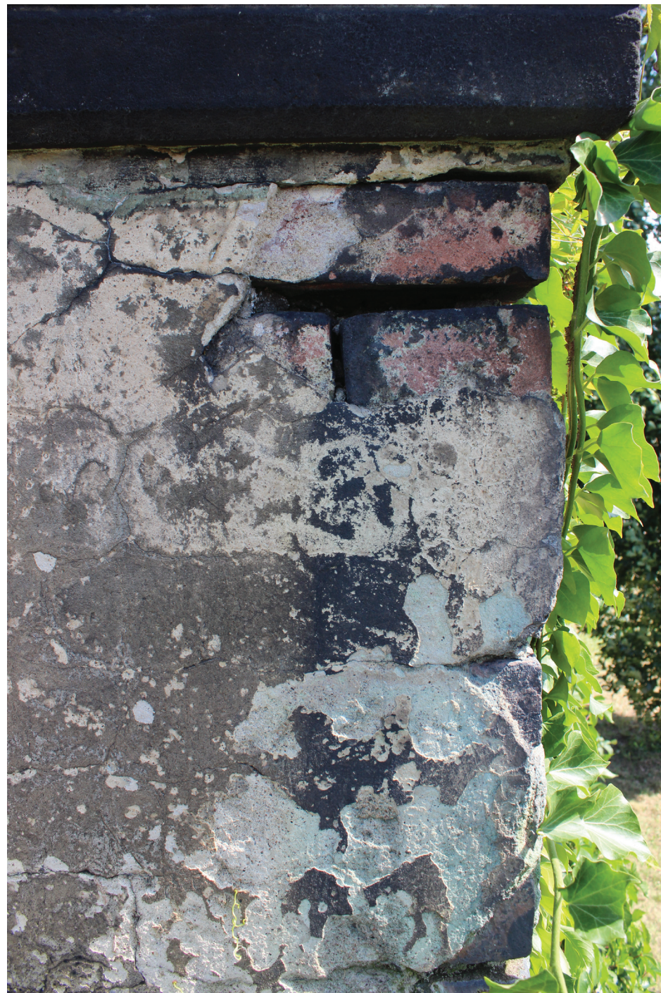
20. Degradace omítek u zděné části hrobky
