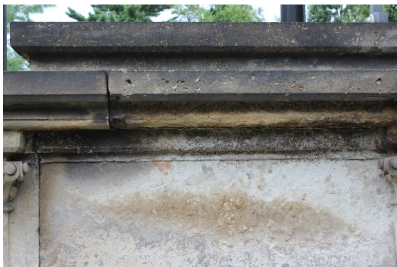
Obr. 2 Formace sádrovcových krust a destrukce materiálu pod nimi, profilace katafalku, JV strana
