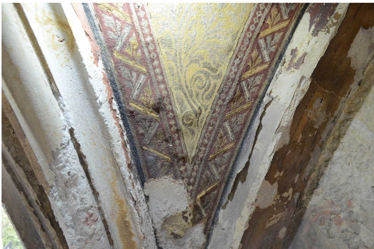
Obr. 9 Detail poškození v nejnižší části klenební výseče v bočním světle, patrné dutiny v omítkce.
