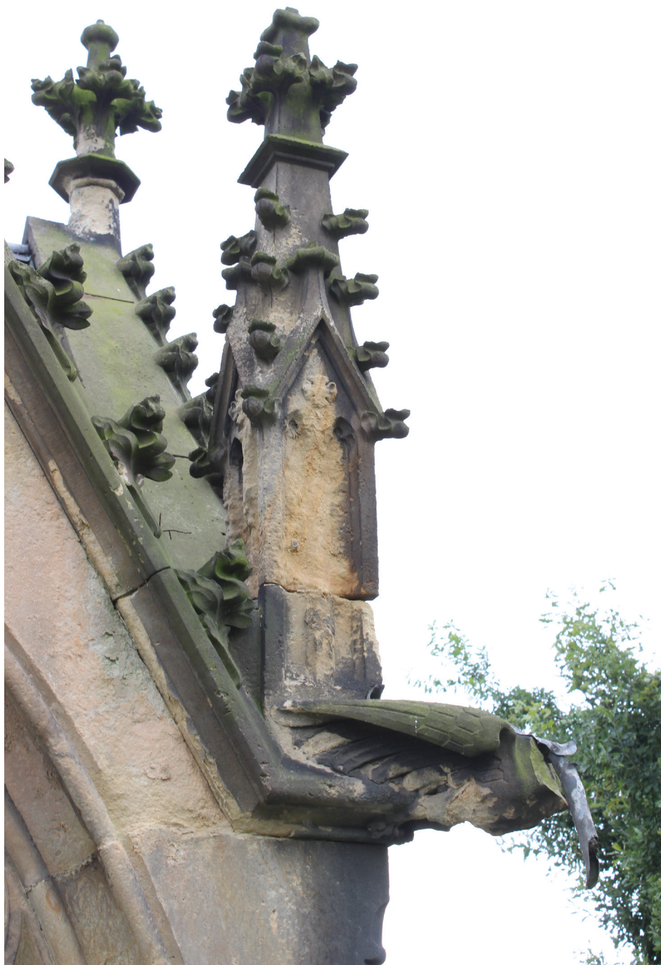
13. JV nároží hrobky, odtržená a ztracená část figury pískovcového chrliče
