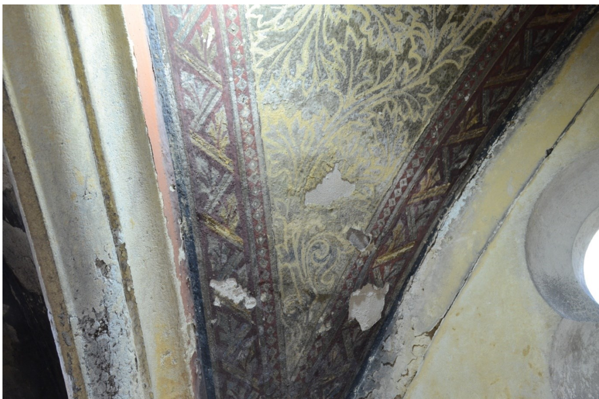
Obr. 11 Detail poškození v nejnižší části klenební výseče po zkušebním zajištění zvedlých okrajů.
