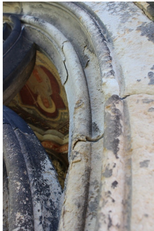
Obr. 1 Degradace pískovcového materiálu v oblasti lomených oblouků s kružbou, SZ a JV strana
