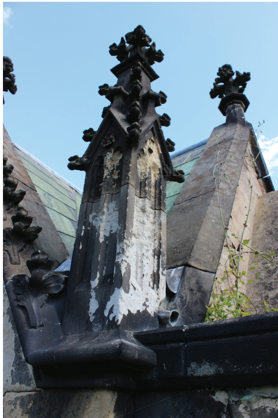
18. Pohled na nefukční olověný chrlič v zadní části hrobky a zanešený svodový žlab. Usazeniny tvoří substrát pro růst vegetace
