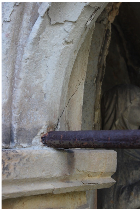
Obr. 3 Oddělená část náběhu klenby v důsledku koroze kovového táhla
