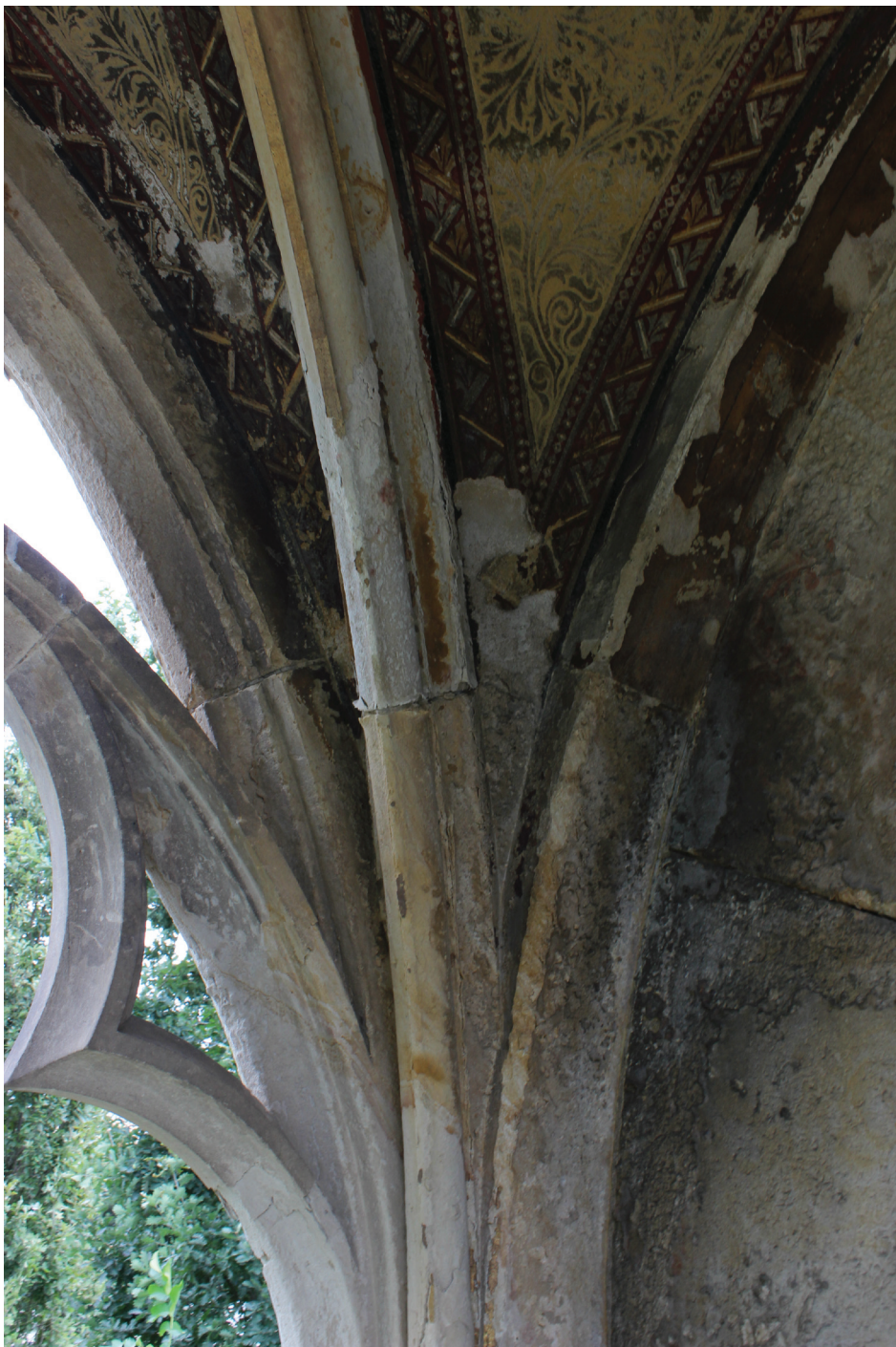
9. Detail předešlého pohledu, hloubková degradace kamene a odpadávání barevné vrstvy spolu s tvorbou sádrovcových krust
