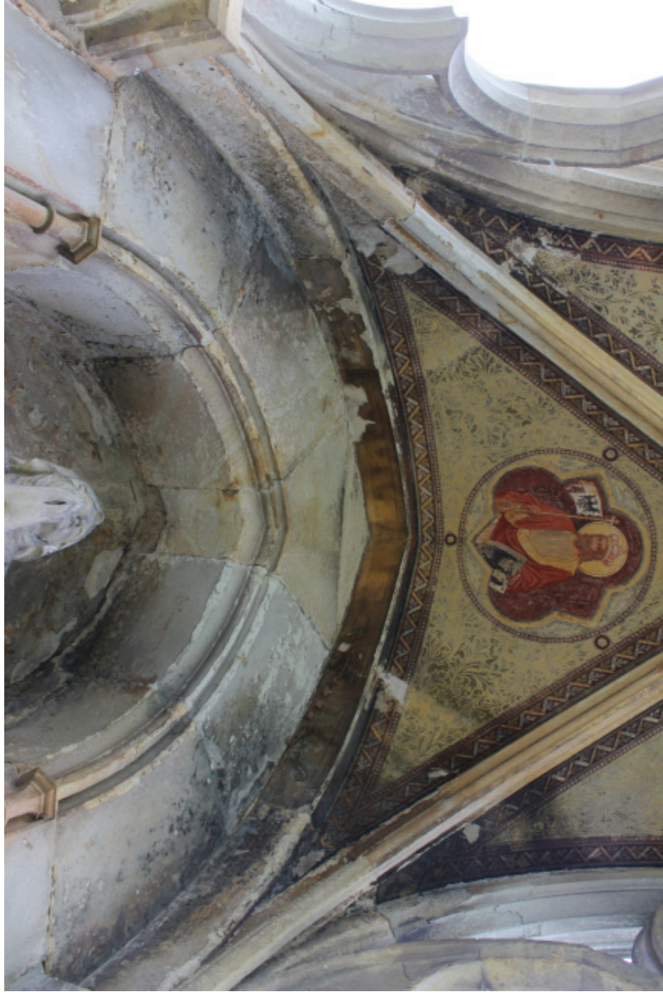
8. Detail náběhů klenby při severní stěně, degradace barevné vrstvy a kamenné hmoty v důsledku zatékání
