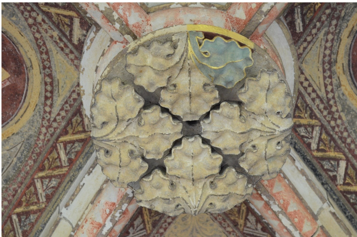
Obr. 18 Detail svorníku se zkouškou barevné rekonstrukce a rekonstrukce zlacení.
