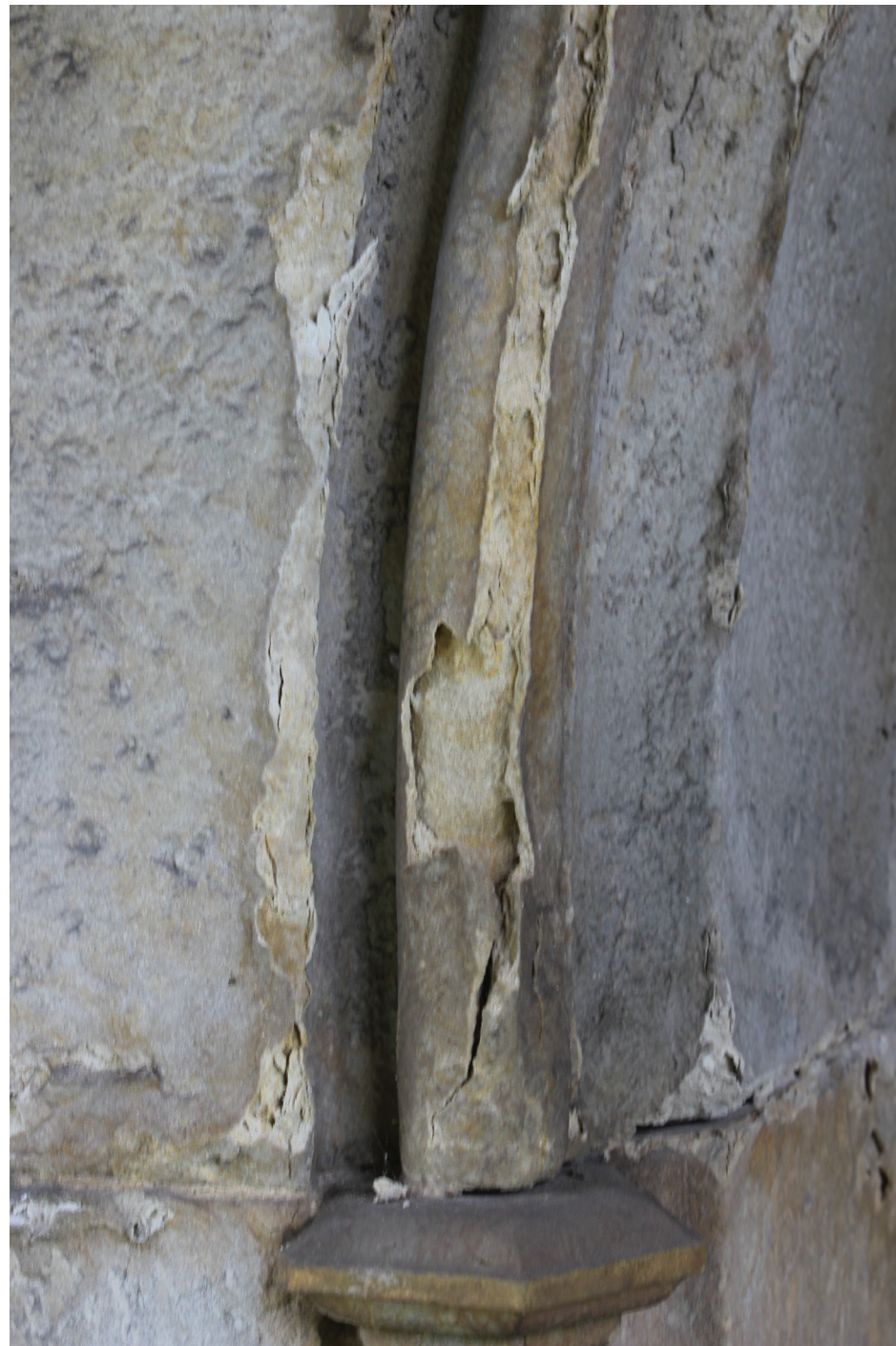
16. Hloubková destrukce kamene vlivem uzavření jeho povrchu.
