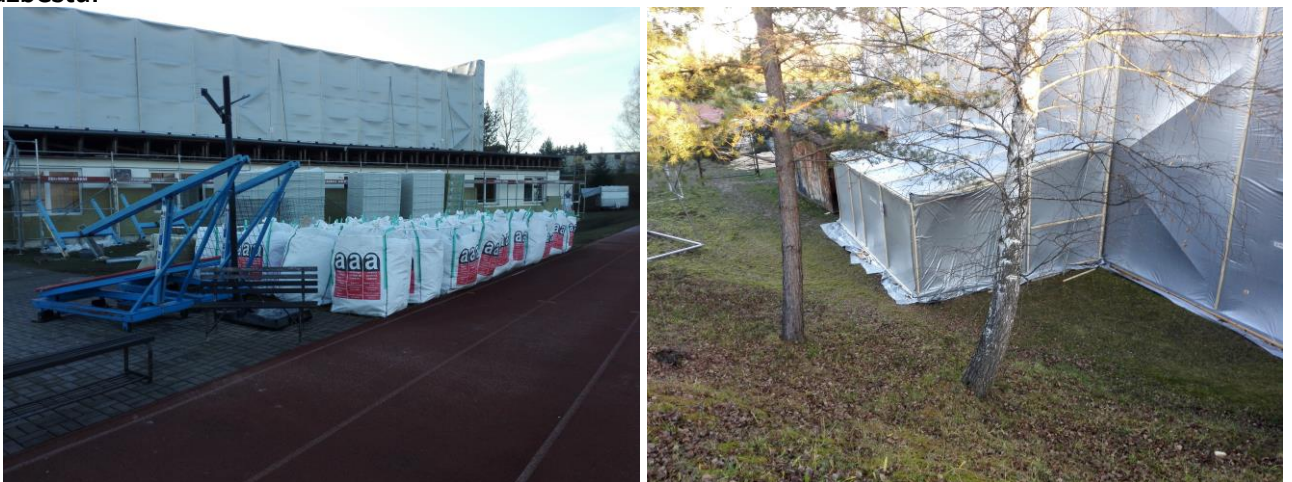
Ukázka deponie odpadu a materiálové dekontaminační komory
