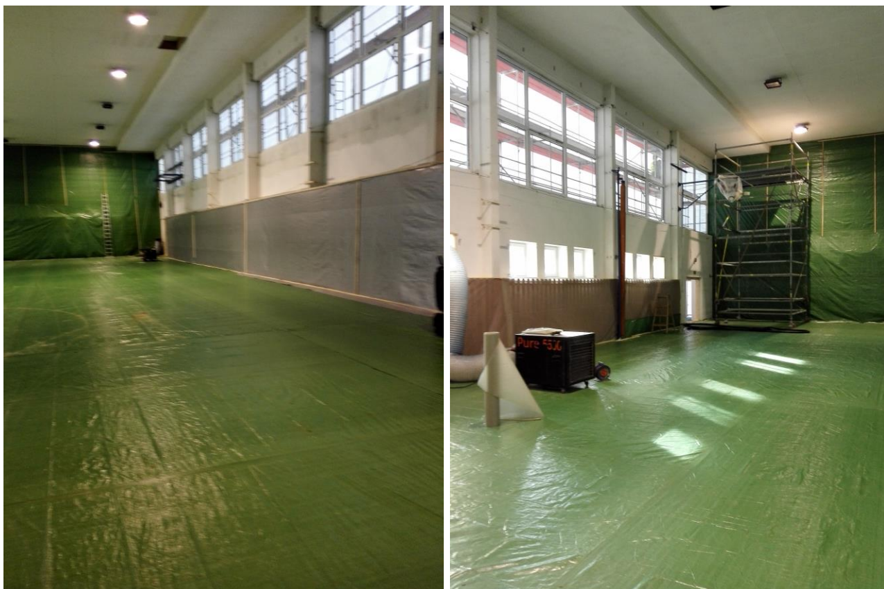
Ukázka způsobu zakrytí konstrukcí
