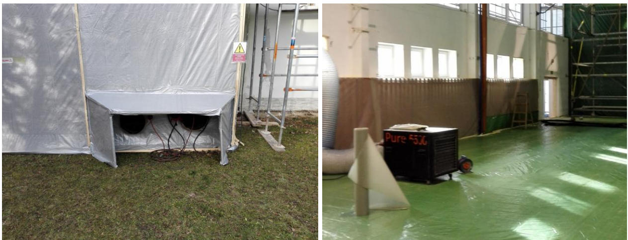
Ukázka napojení odsávacích zařízení s HEPA filtry
