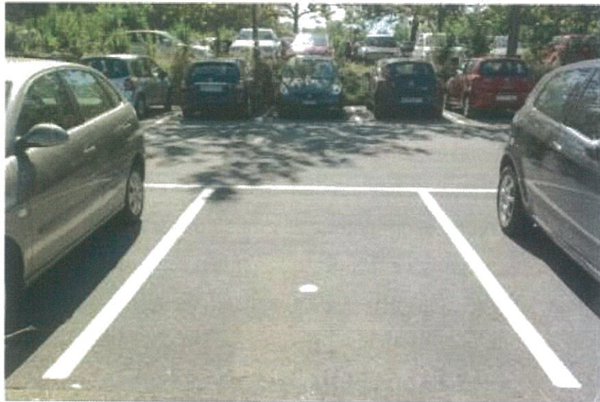
Obrázek 7 Příklad instalace senzoru do asfaltového povrchu
