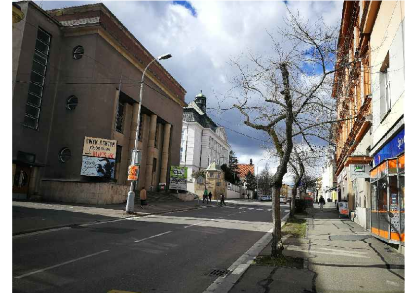
obr. 12: ulice Kutnohorská, severní chodník stávající stromy jsou ve špatném stavu
