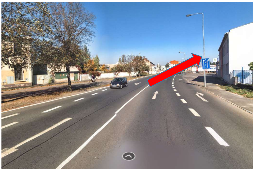
Obrázek 3- umístění zařízení bez stálého napájení - na sloupu VO , na kterém je umístěno DZ IP19 ( Ul. Ovčárecká před křižovatkou s ul. Rorejcovou). Sloup označen šípkou.
