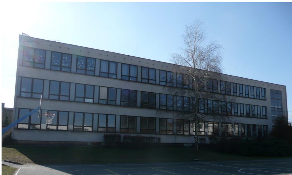
Obr. 3 – fasáda posuzovaného objektu učebnového pavilonu U2.2
