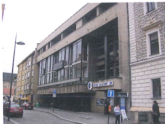
Jižní (uliční) fasáda
