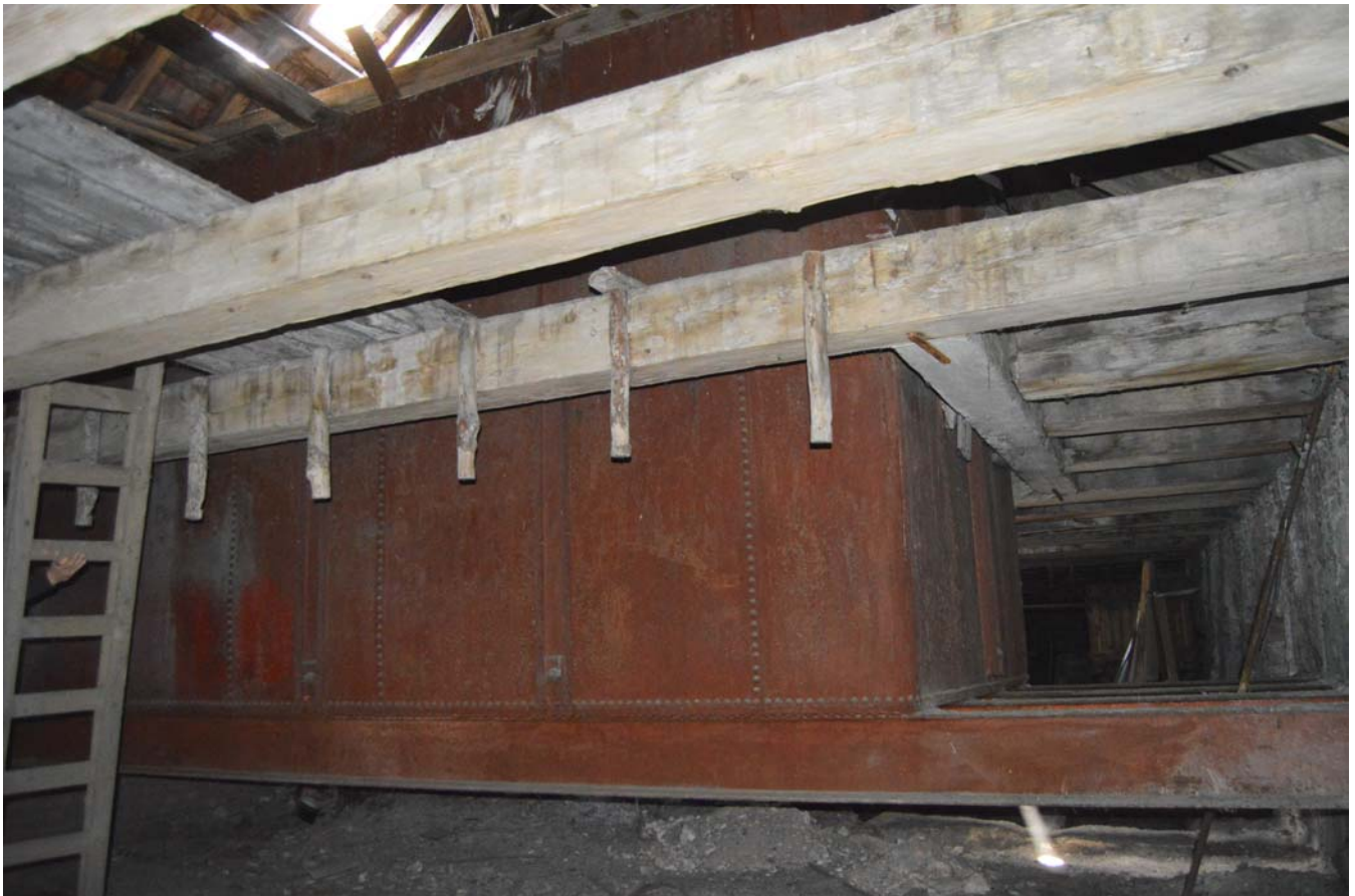
9. Ocelová nádrž na vodu
