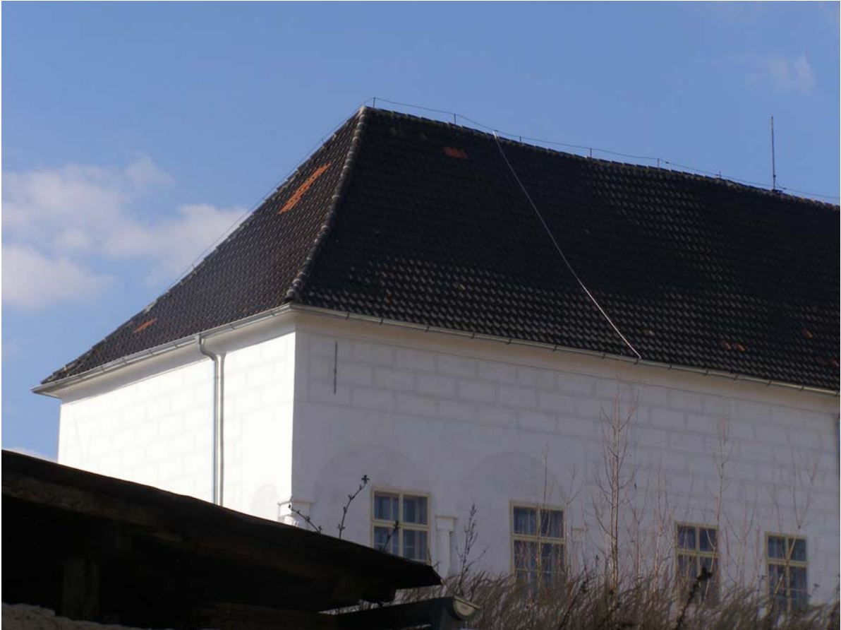
3. Východní strana střechy
