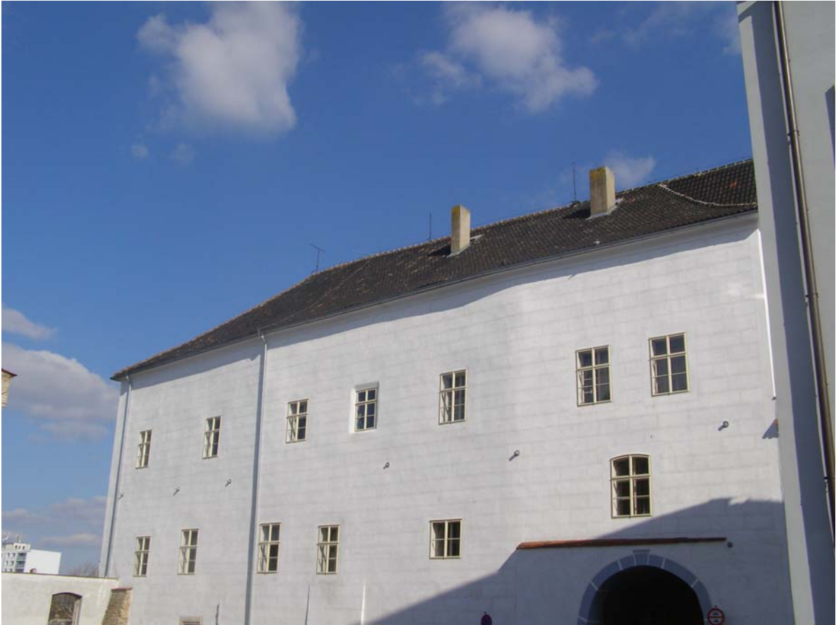
5. Západní strana střechy
