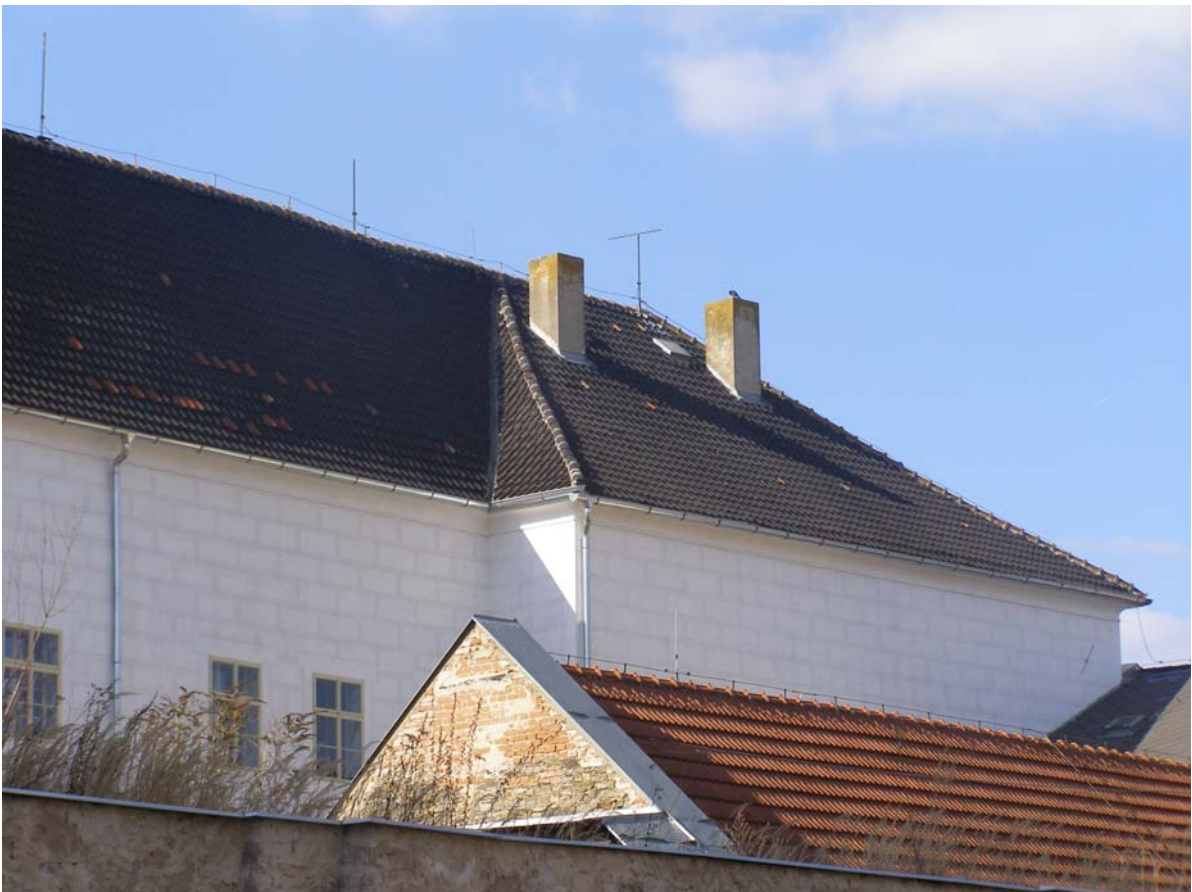
4. Východní strana střechy
