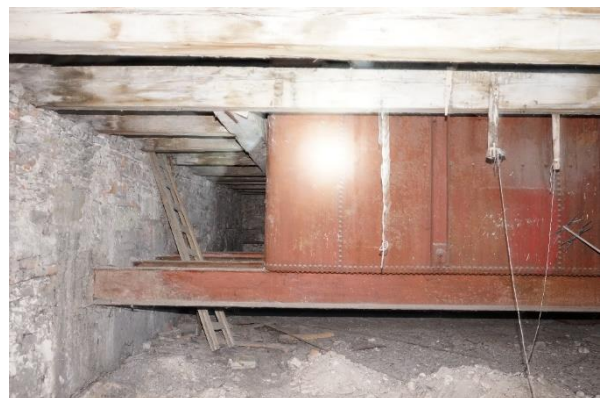
Obrázek 5, 6 – Pohled na stávající ocelovou nádrž na vodu – navrženou k odstranění
