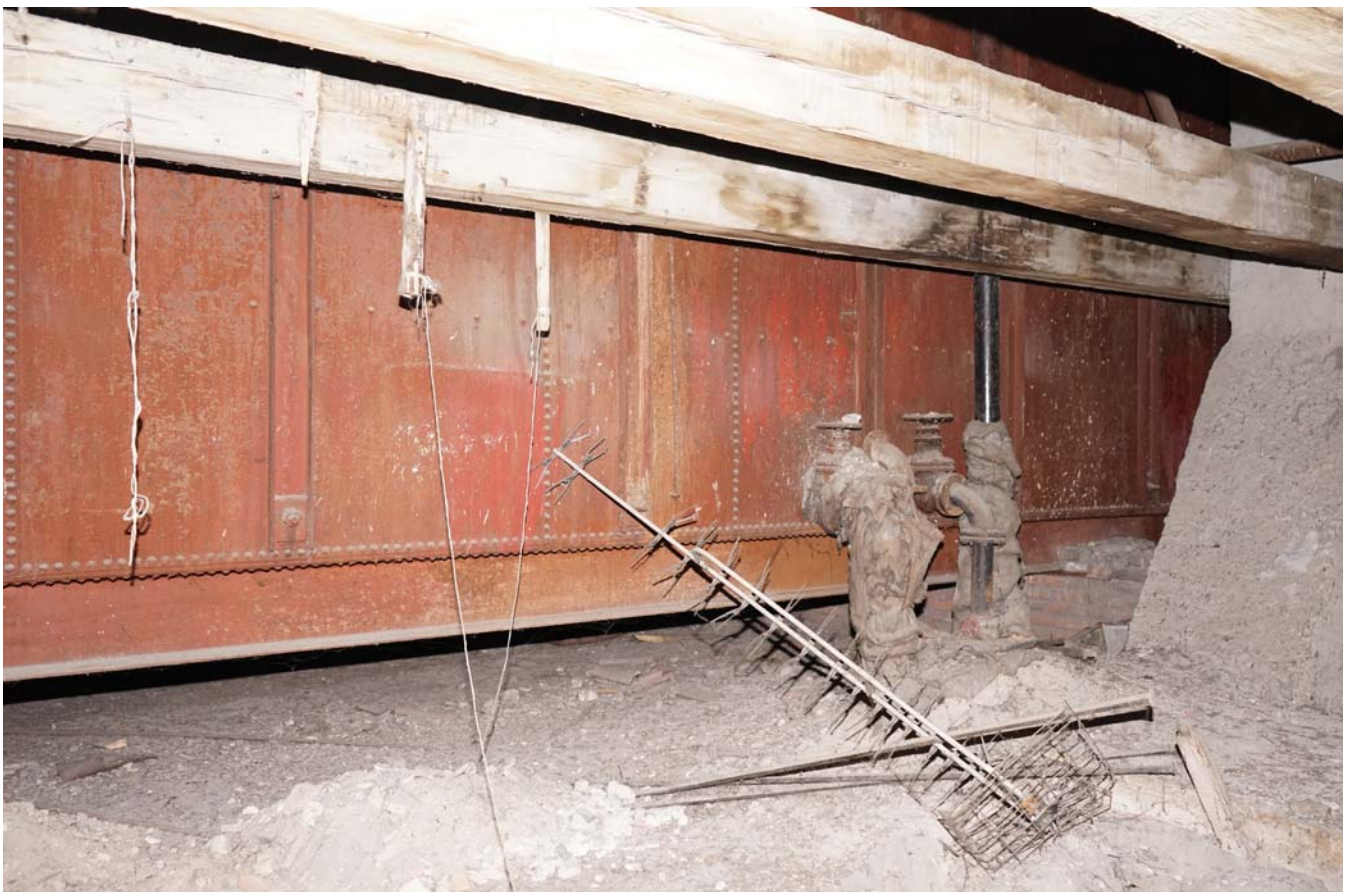
10. Ocelová nádrž na vodu
