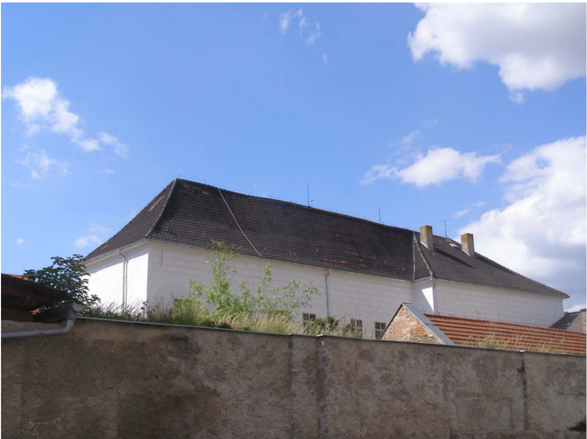
2. Východní strana střechy
