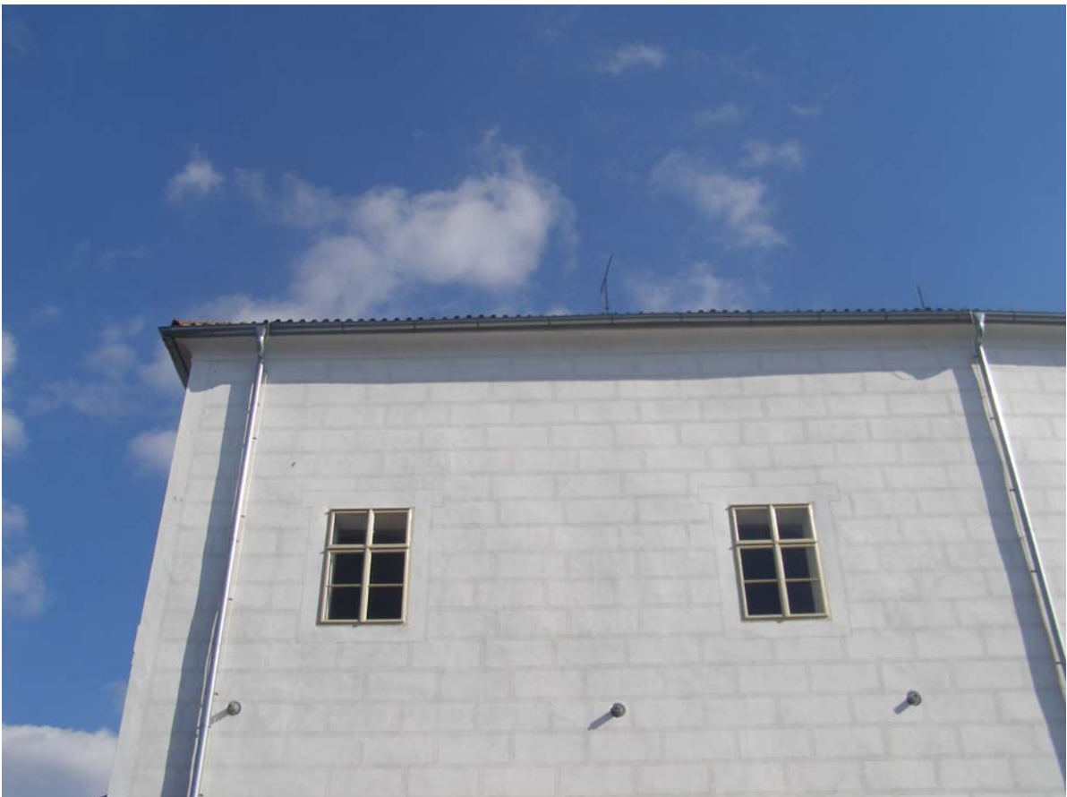
6. Západní strana střechy
