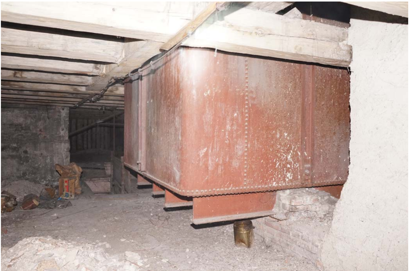
8. Ocelová nádrž na vodu
