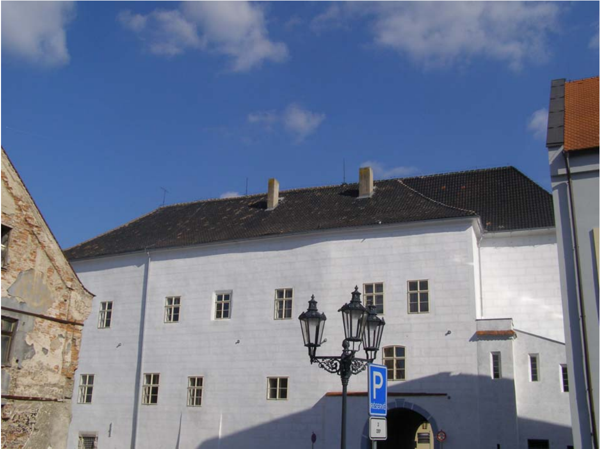
1. Západní strana střechy
