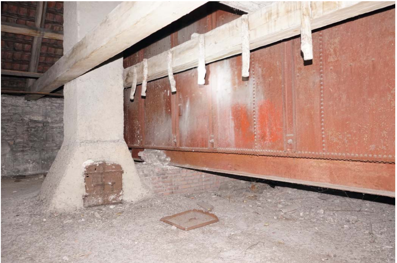
7. Ocelová nádrž na vodu
