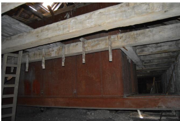
Obrázek 5, 6 – Pohled na stávající ocelovou nádrž na vodu – navrženou k odstranění
