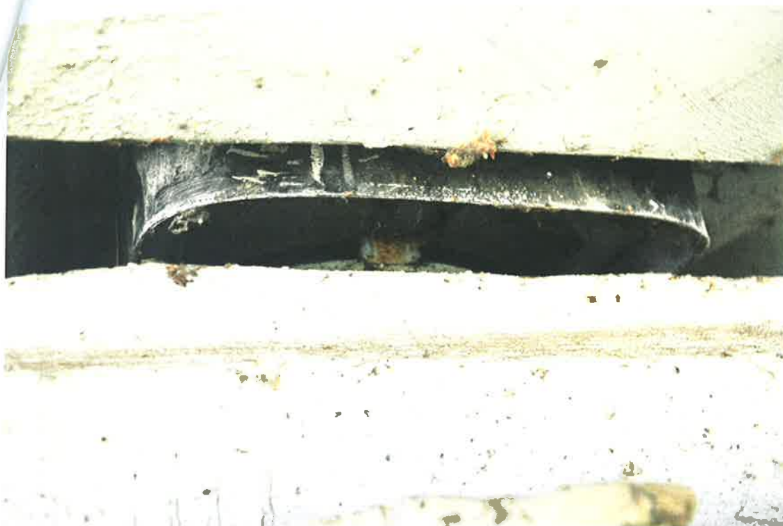
Jednosměrné hrncové ložisko – pohled na lící stranu opěry 1 (ložisko je na návodní straně).
