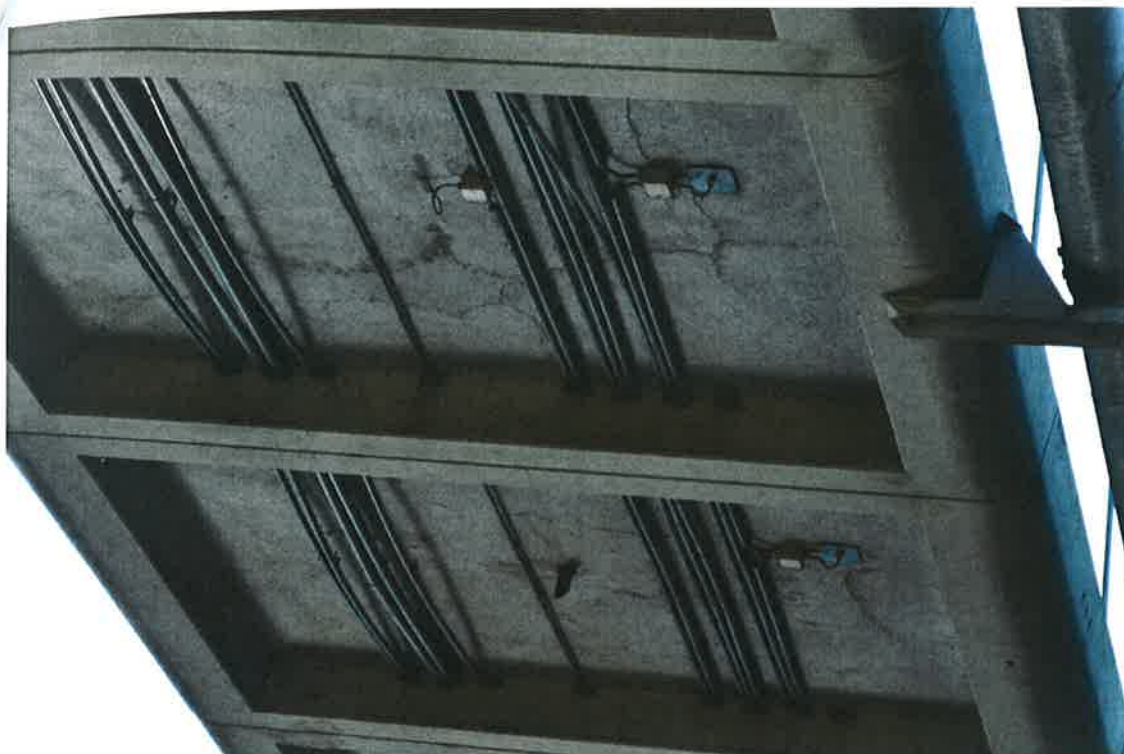
Detail prefabrikátů mostovky s kabely elektroohřevu, uprostřed jsou vedeny kabely bezpečnostních kamer, vpravo konzola s plynovodem STL 300.
