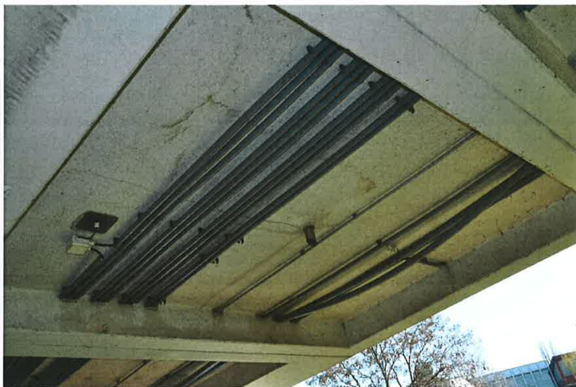
Další pohled na mostovku zespodu, zatékání nezjištěno.
