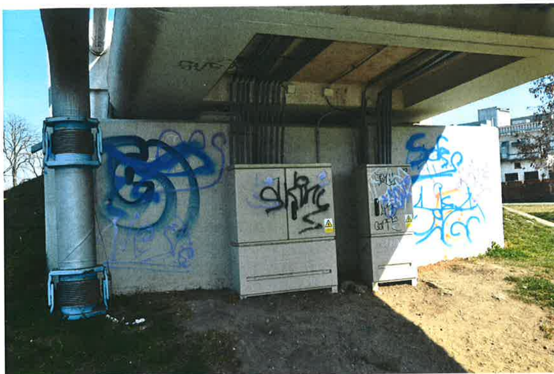
Opěra 4 v Zálabí s rozvodnými skříněmi elektroohřevu a venkovního osvětlení včetně kamer. Vlevo svod plynovodu s kompenzátory.
