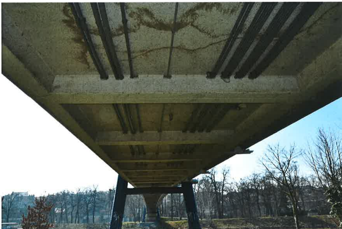
Podhled prefabrikované betonové mostovky je suchý, zatékání nebylo zjištěno ani ve spárách mezi prefabrikáty ani kolem odvodňovacích trubiček.
