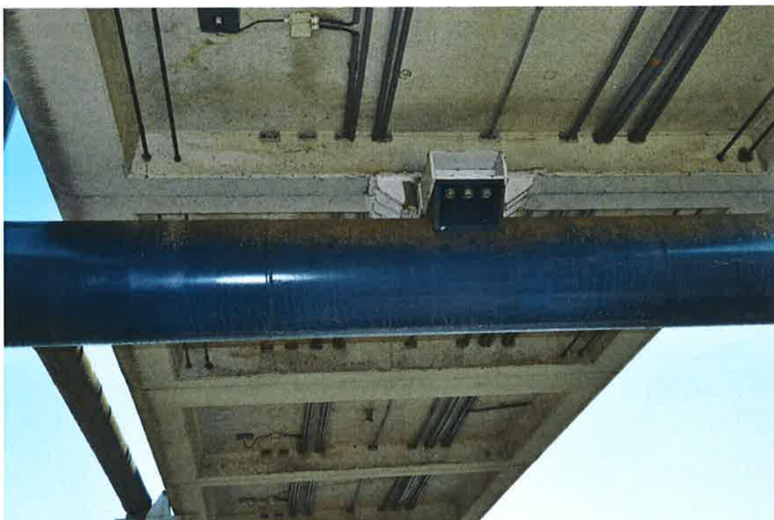
Vodící zařízení, které zajišťuje mostovku proti příčným posunům – pylon na Kmochově ostrově.
