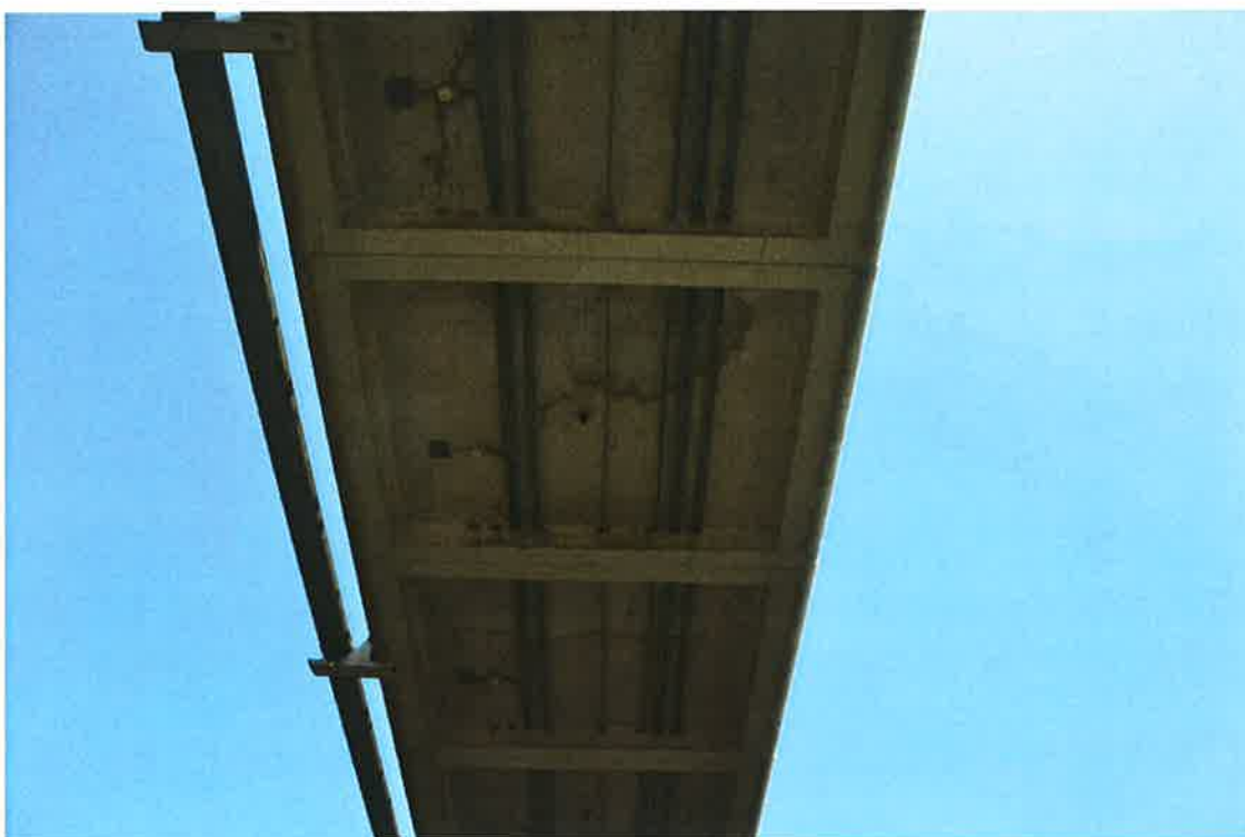
Podhled mostovky při pohledu z Kmochova ostrova, zatékání nezjištěno.
