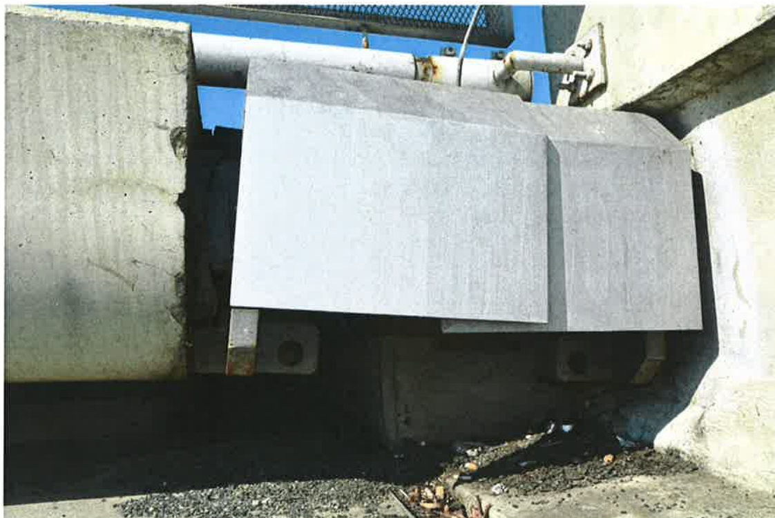
Kryt tlumiče na opěře 4 – návodní strana.
