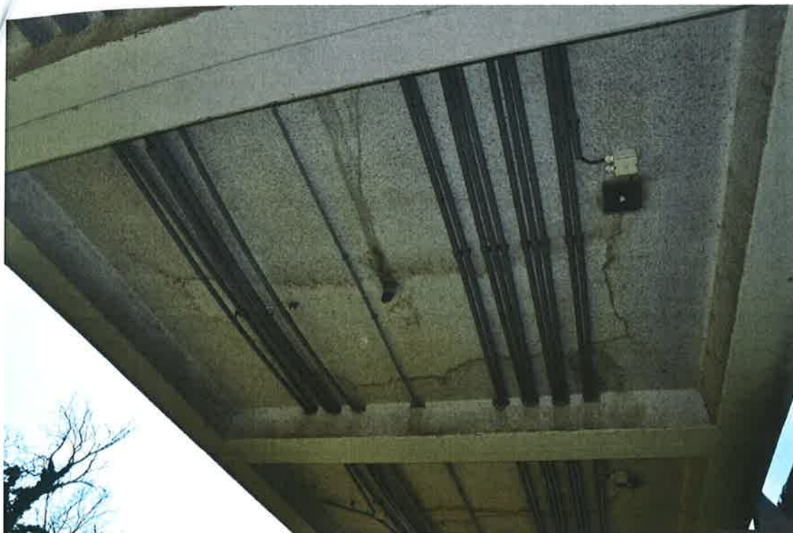
Detail mostovky, mapy jsou z doby montáže v roce 2006.
