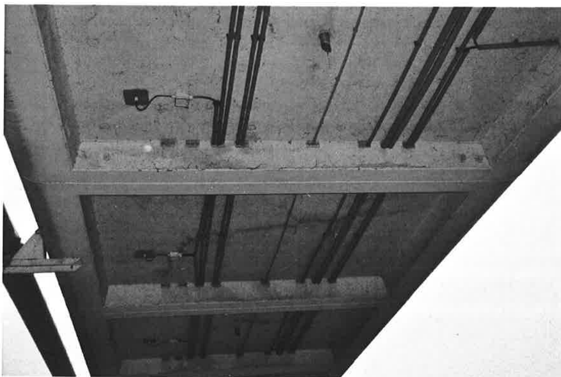
Lávka i při vydatném dešti je na podhledu suchá, z odvodňovací trubičky vytéká voda.
