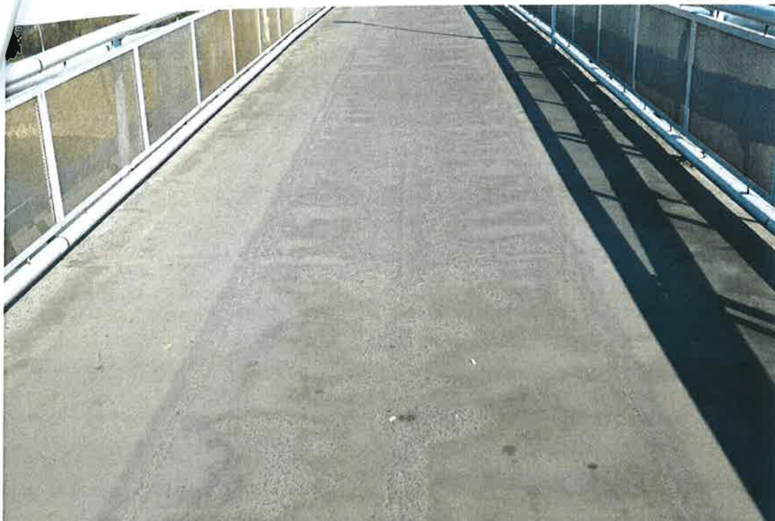
Povrch betonu mostovky chrání epoxidehtová pryskyřice, povrch je vyspádován do osy lávky, v níž jsou osazeny odvodňovací trubičky.
