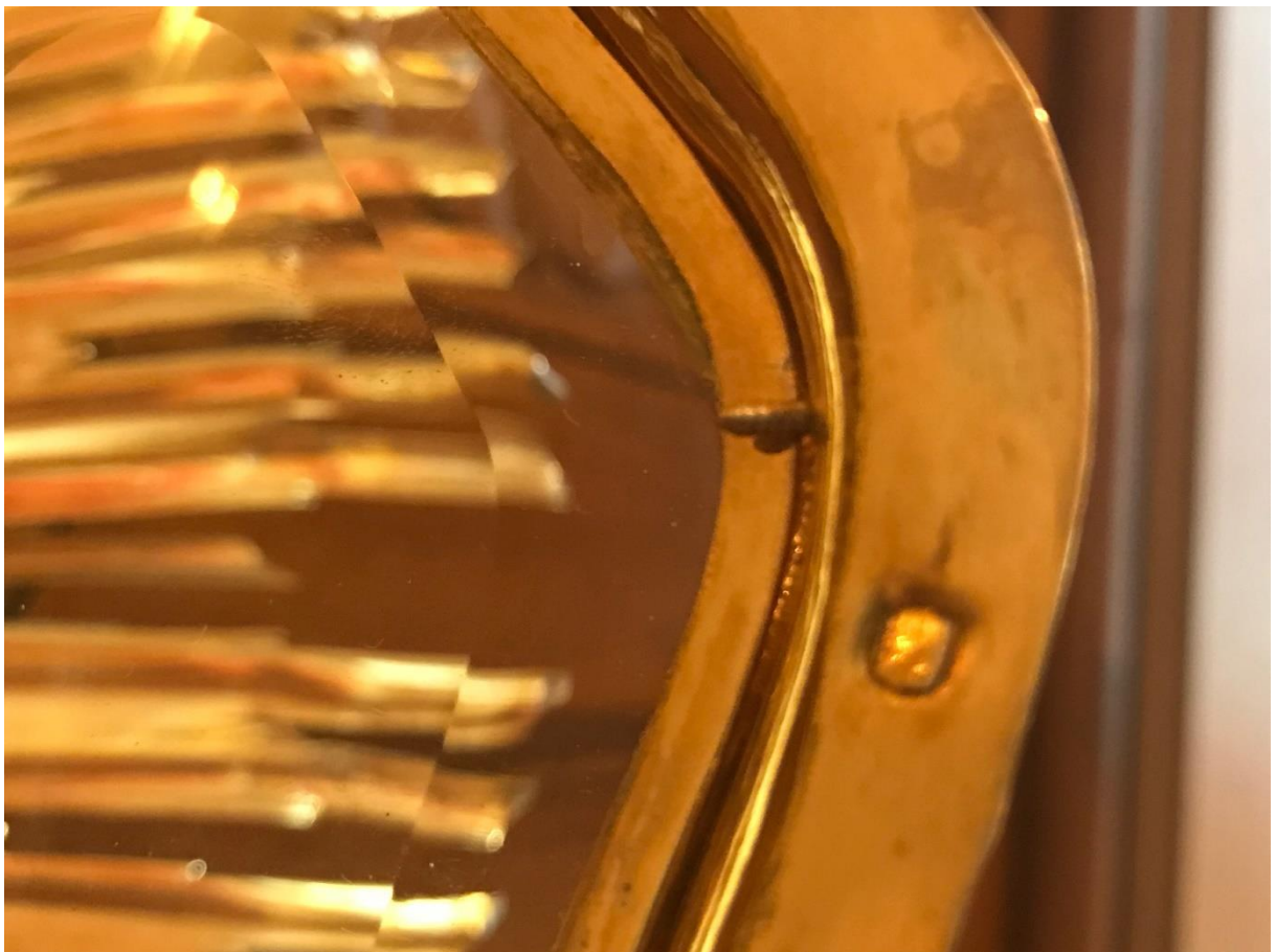
Nýtovaný spoj profilu dvířek.
