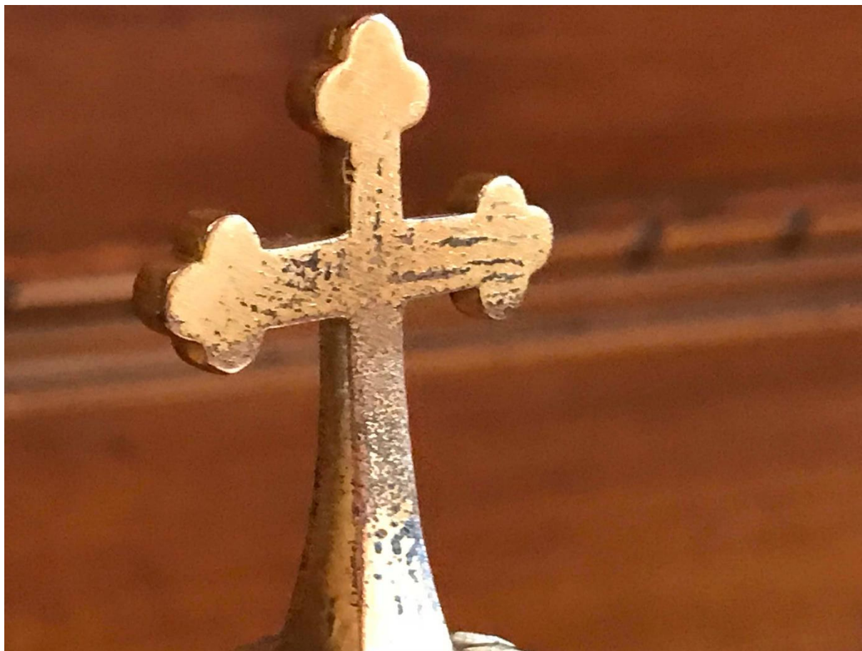
Poškození zlacení na vrcholovém křížku.
