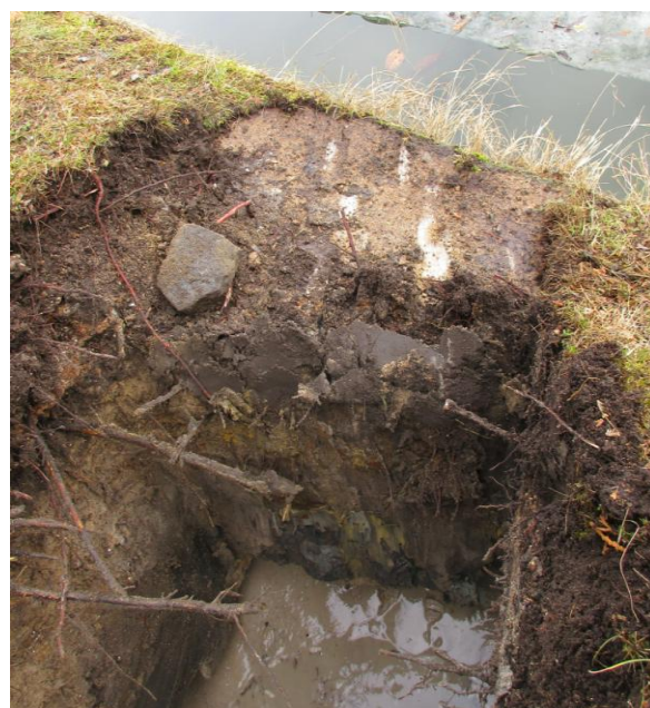
svrchní betonový krycí panel, patrné jílovité těsnění, silně zvodnělé, zvířené písky
