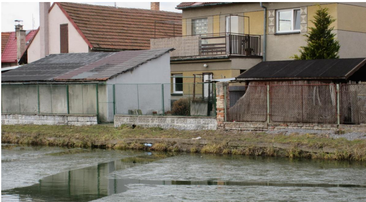
Drobné stavby a podezdívky plotů u kterých lze očekávat rekonsolidaci základových půd vlivem snížení hladiny vody v rybníku
