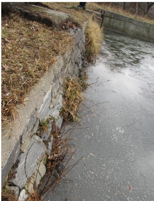
charakter kamenného zdiva, svrchu s betonovou římsou
