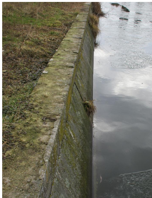
opevnění z betonových panelů, svrchu s krycí betonovou římsou/panelem
