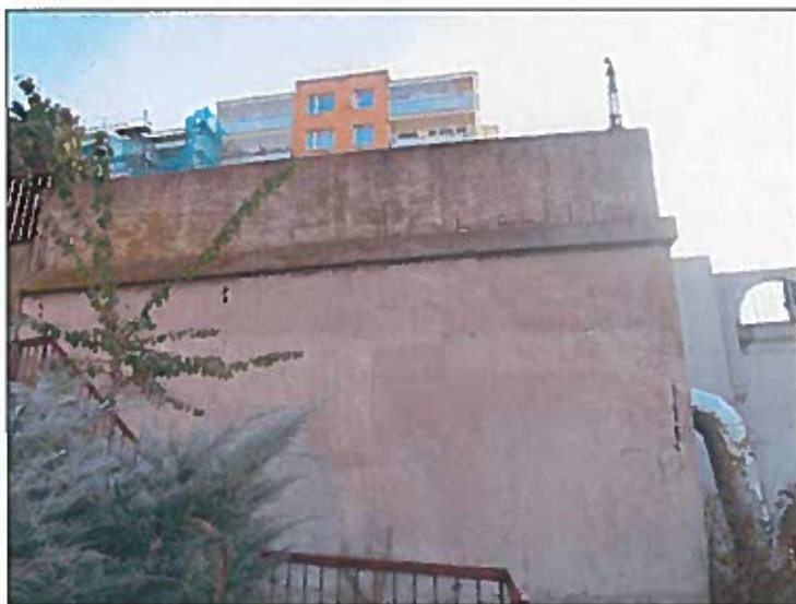
obnažená korodující výstuž zábradelní zídky na plošině za O2
