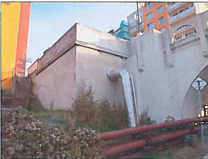
levý bok opěry 2
