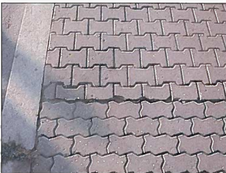
v okolí dilatační spáry dochází k deformaci krytu vozovky
