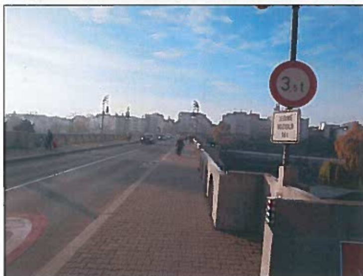
dopravní značení omezující zatížitelnost
