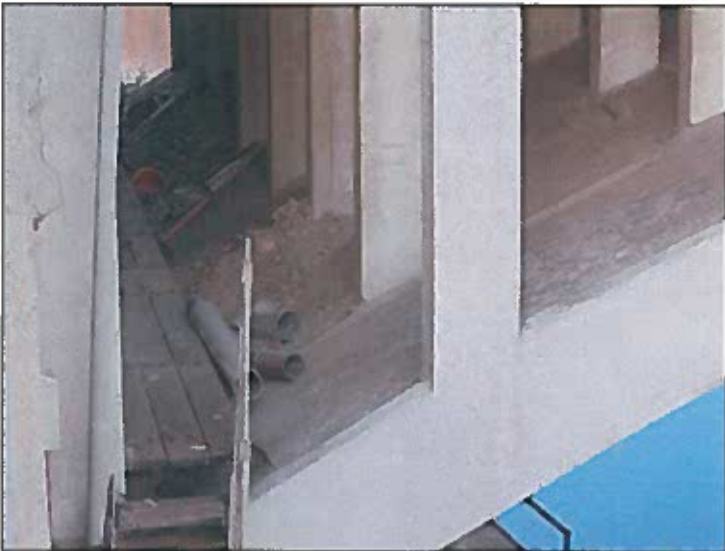
obslužná lávka podél opěry 1
