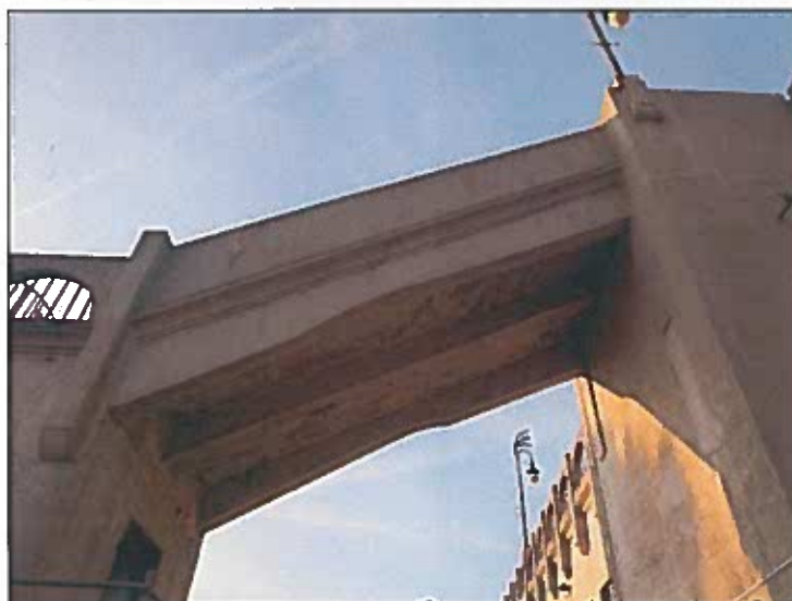
podhled konstrukce přístupového schodiště
