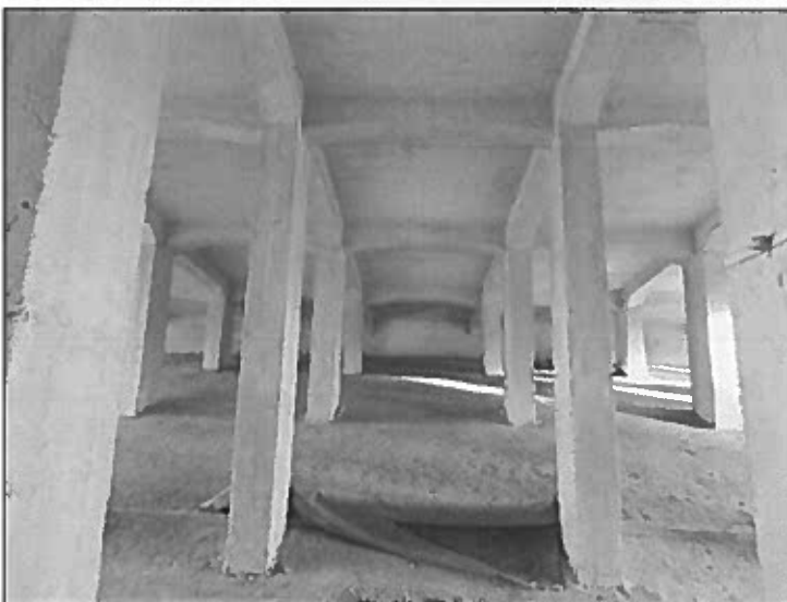
průhled nosnou konstrukcí od O1
