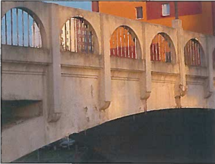
DDTO - detail v místě kotvení sloupků zábradlí
