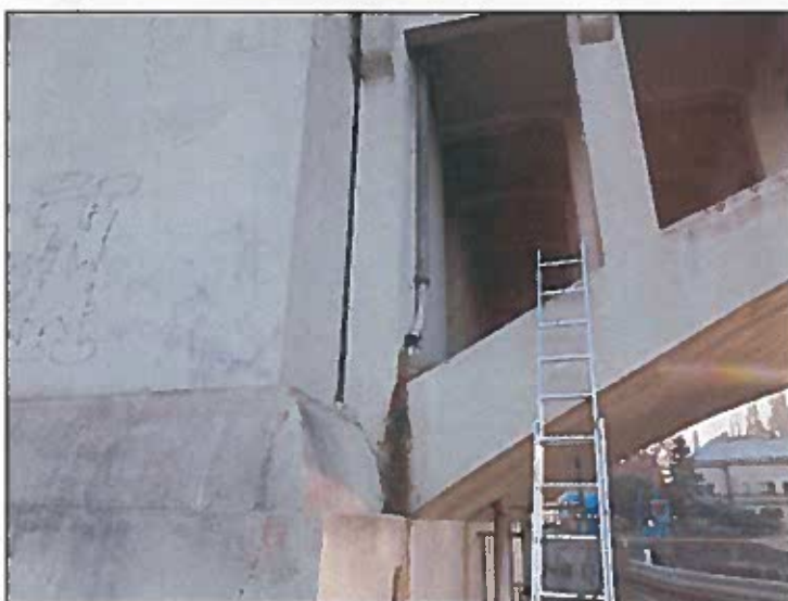
voda z odvodňovače u O2 volně stéká po boku obloukového pasu
