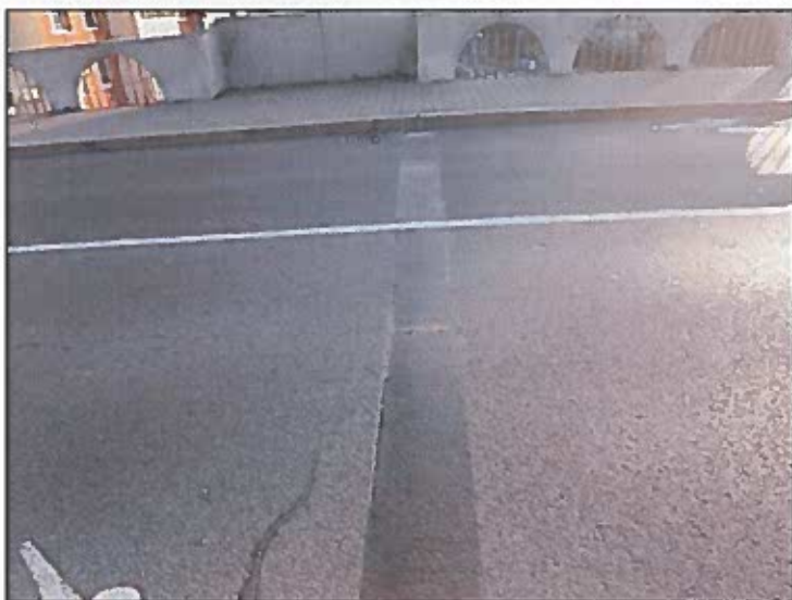
otevřená pracovní spára podél EMZ
