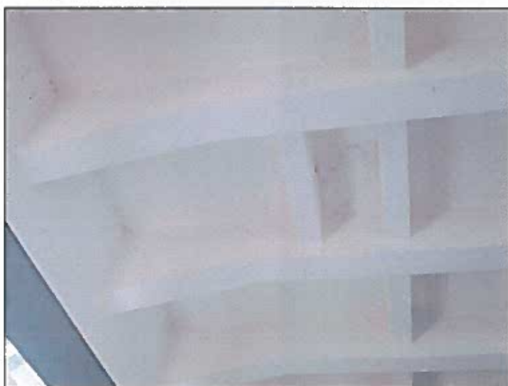
drobné stopy po průsaku deskou mostovky
