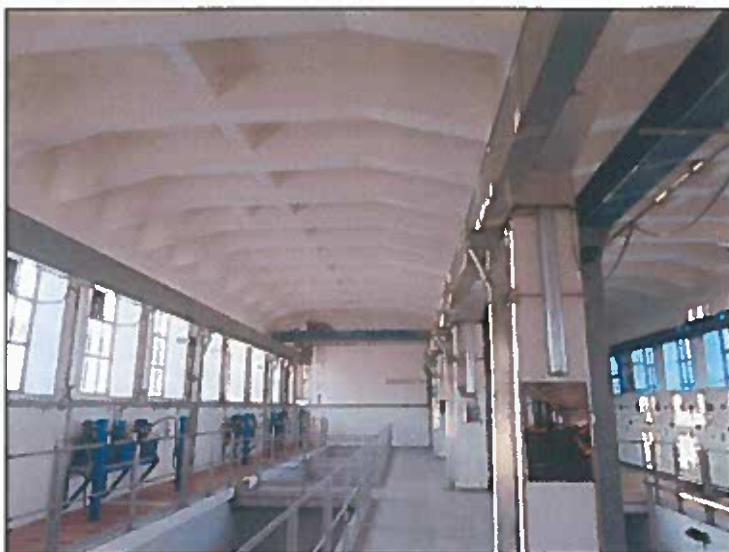
podhled nosnou konstrukcí nad elektrárnou
