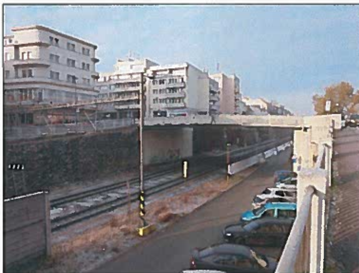
celkový pohled na most
