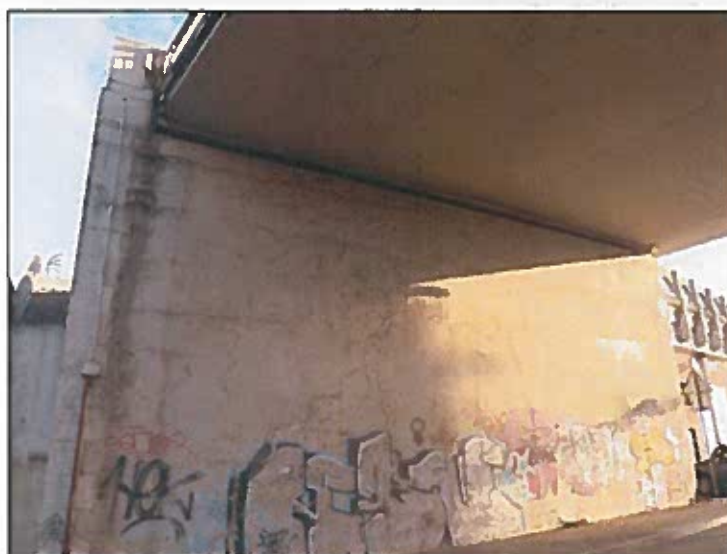
pohled na opěru 2
