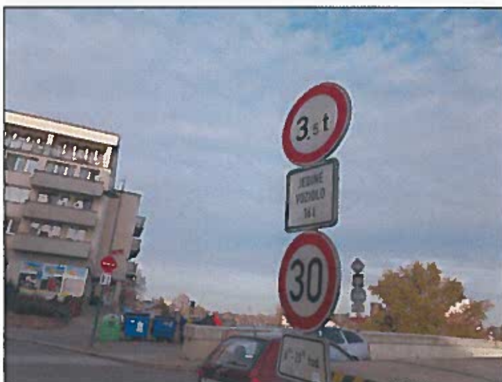
dopravní značení osazené na mostě
