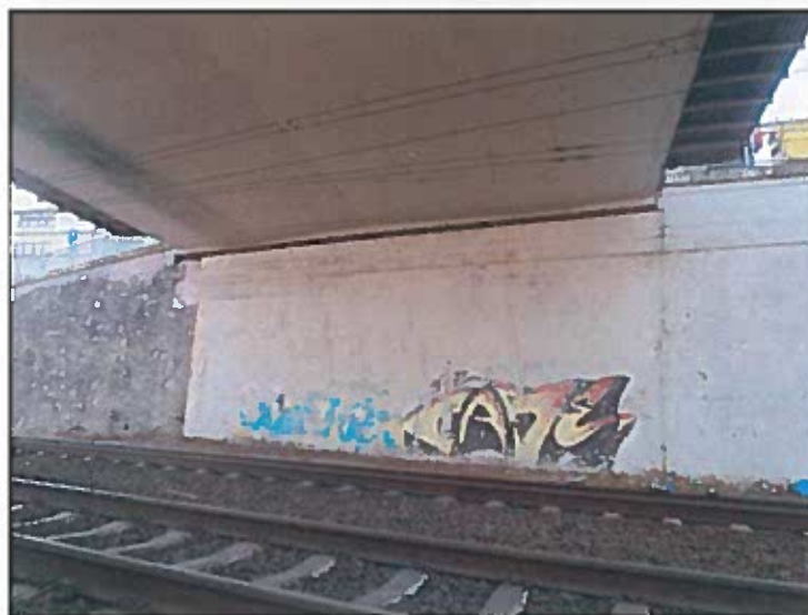
pohled na opěru 1
