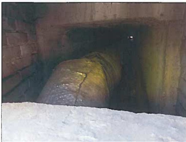
pohled do kolektoru
