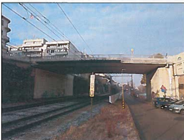
pohled na pravou stranu mostu
