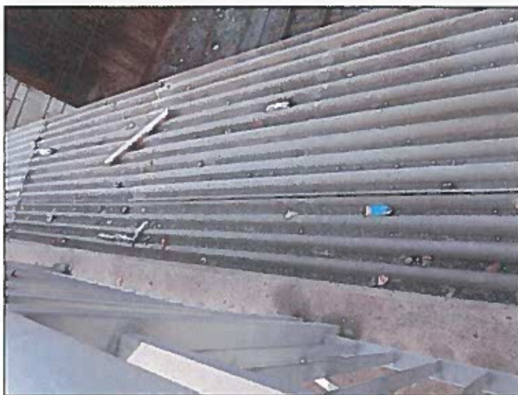
nečistoty na protidotykovém štítu
