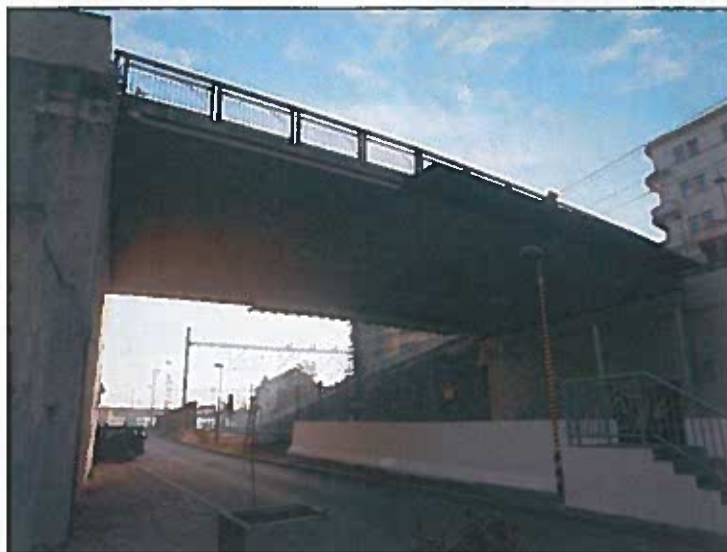
pohled na levou stranu mostu
