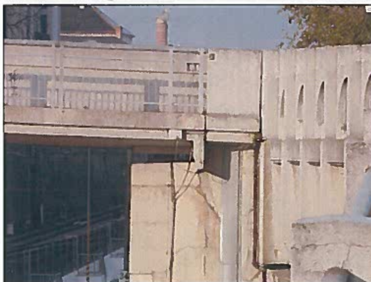
uložení mostu na O2
