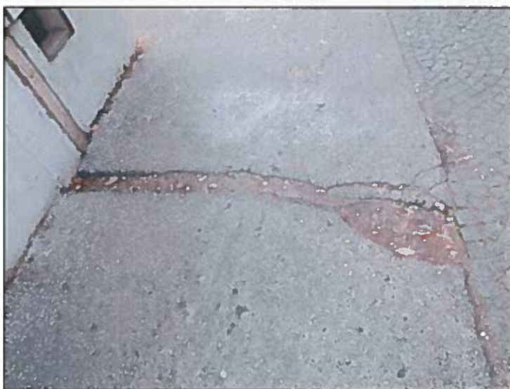
otevřená dilatační spára v krytu chodníku
