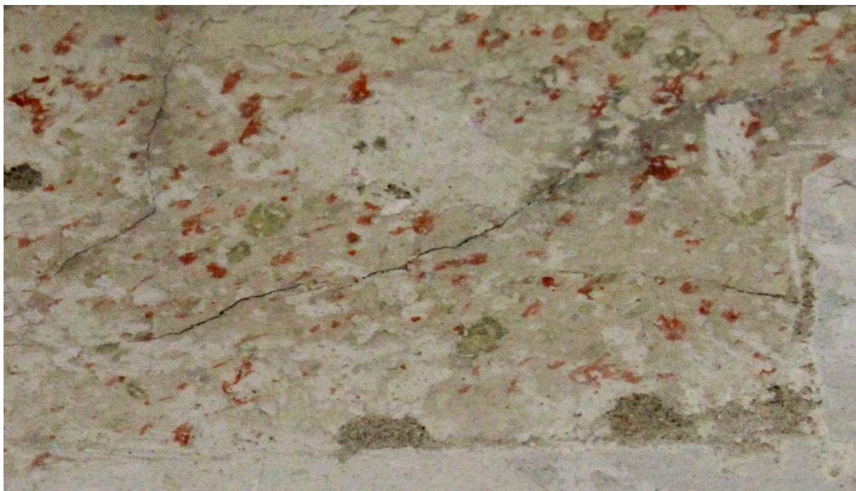
11.S.K.b./Stratigrafie: 0-štuk, 1-slonová kost -vápenný nátěr. 2- červené tečky, zelené skvrnky, modré tahy.
