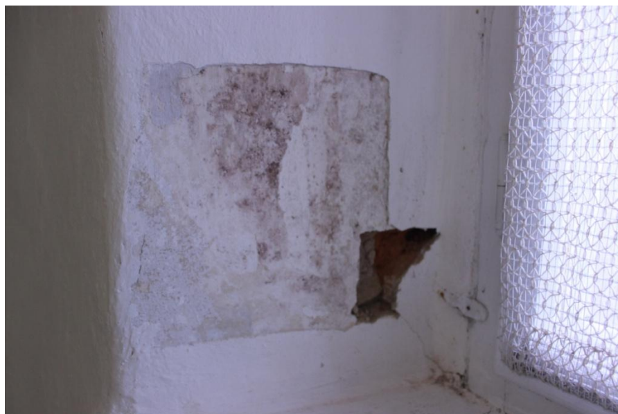
1.S.K.s./1. Sonda Kolín světnice /0-cihla, 1-štuk, 2-bílá-vápenné nátěry, 3-červenohnědé až do fialova laděné motivy těžko čitelných šablonových dekorů? 4- bílý vápenný nátěr, 5-světle modrá, vápenný nátěr, 5- bílý vápenný štuk – současný nátěr.
