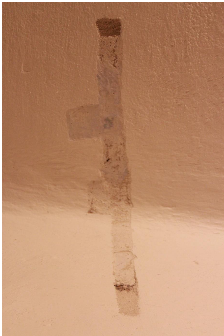
15.S.K.a./ . 0-štuk. 1- krémově bílá -vápenný nátěr. 2-světlešedá- vápenný nátěr. 3- světlemodrá - vápenný nátěr. 4- bílá – více nátěrů, současný stav.
