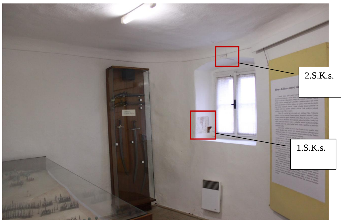
V 1. patře bývalé školy, v prostoru komory byly provedeny u okna dvě sondy stratigrafií.
