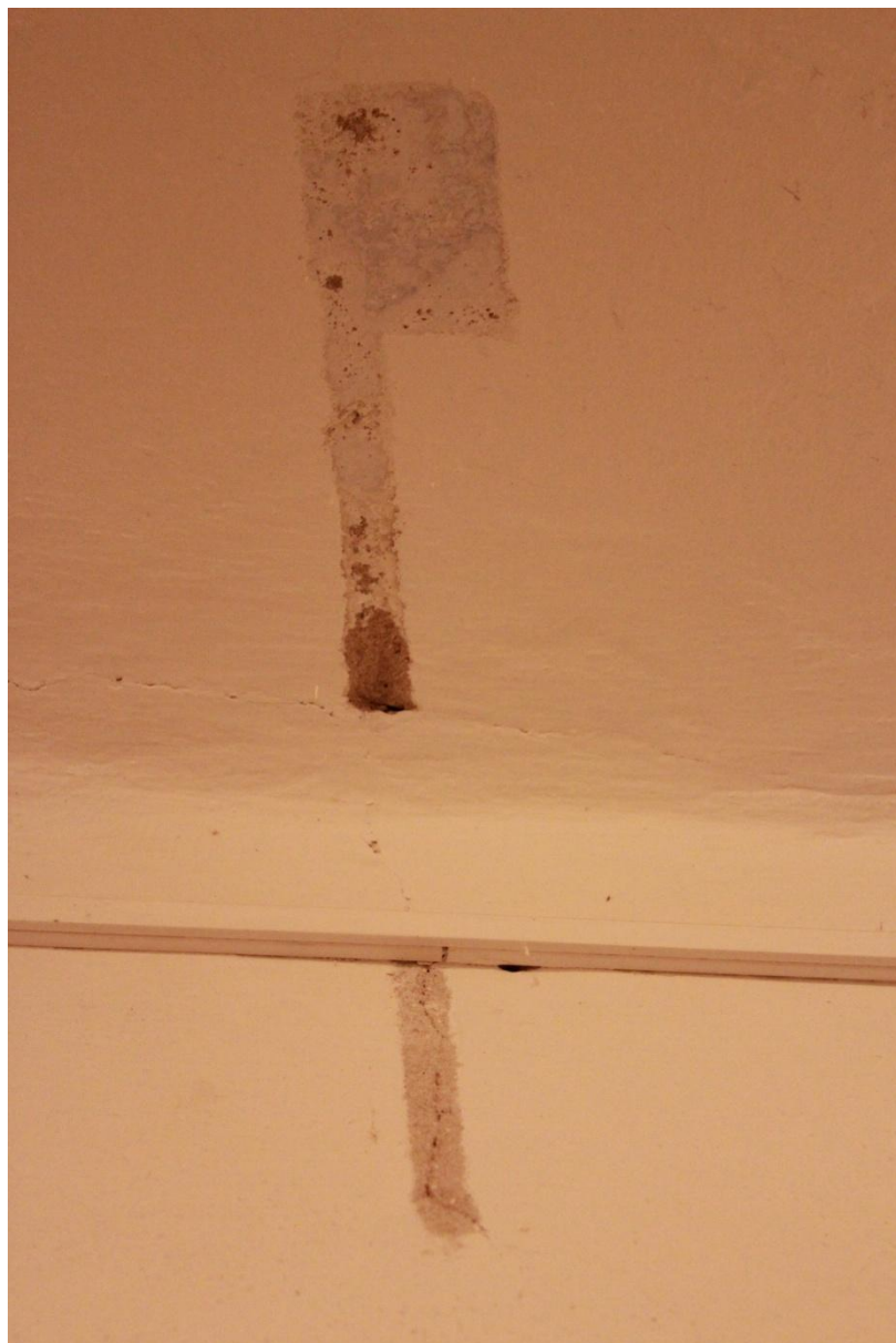
16.S.K.b./– Sonda nad vstupními dveřmi. 0-štuk. 1- krémově bílá -vápenný nátěr. 2- světlešedá- vápenný nátěr. 3- světlemodrá - vápenný nátěr. 4- bílá – více nátěrů, současný stav.
