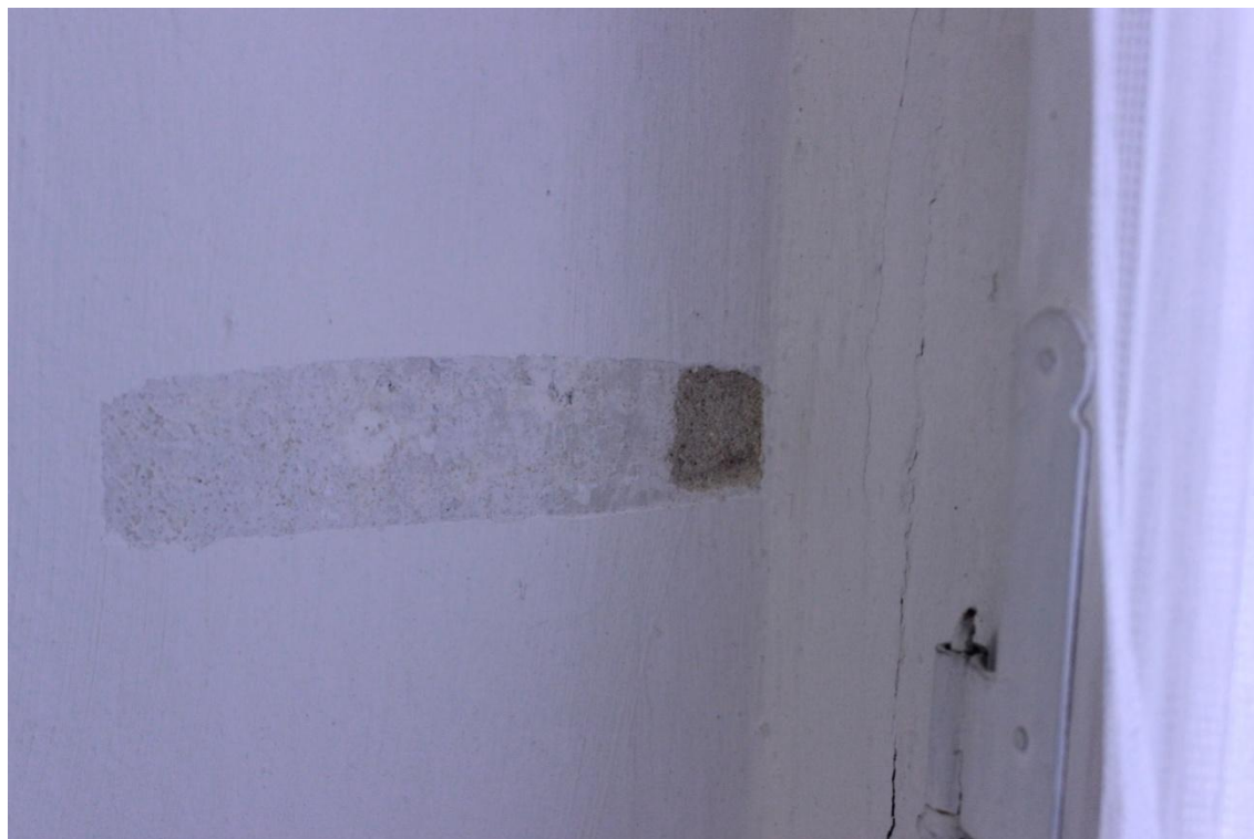
7.S.K.a/ Stratigrafie: 0-štuk, 1-bílá -vápenný nátěr. 2- šedá, 3- tmavě modré fragmenty malovaných šablon? 4- bílá - vápenný nátěr, 5.Současný stav.
