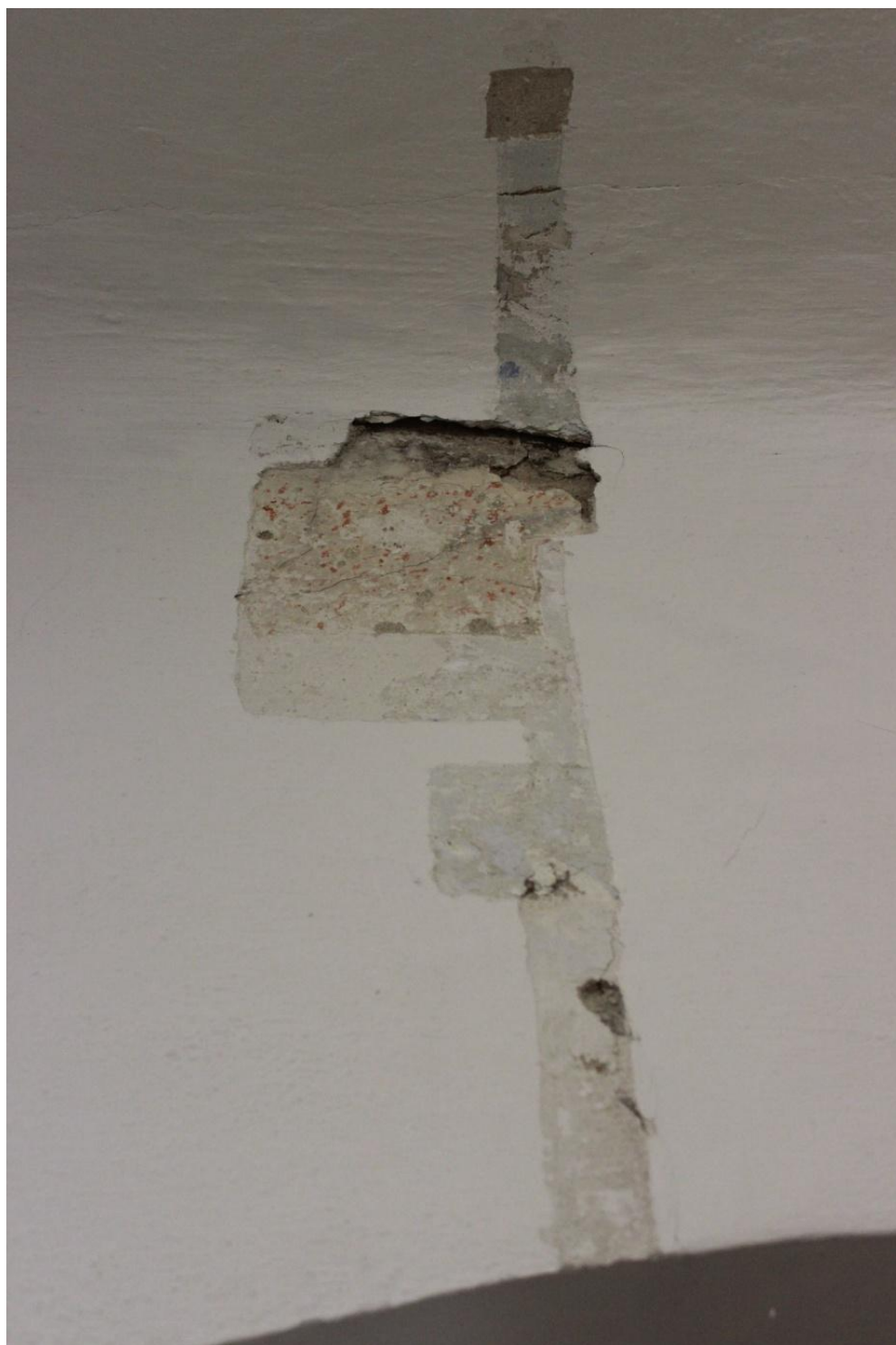
11.S.K.b./Stratigrafie: 0-štuk, 1-slonová kost -vápenný nátěr. 2- červené tečky, zelené skvrnky, modré tahy. 3- /na stropě následujě opravná vrstva šuku. Vápenné vrstvy (cca 6)./ Místnost byla v minulosti opravována. Praskliny byly přestukovány. 4-světle modrá – vápenné nátěry. 5- světle zelená- vápenné nátěry. 6- bílá – současný stav.
