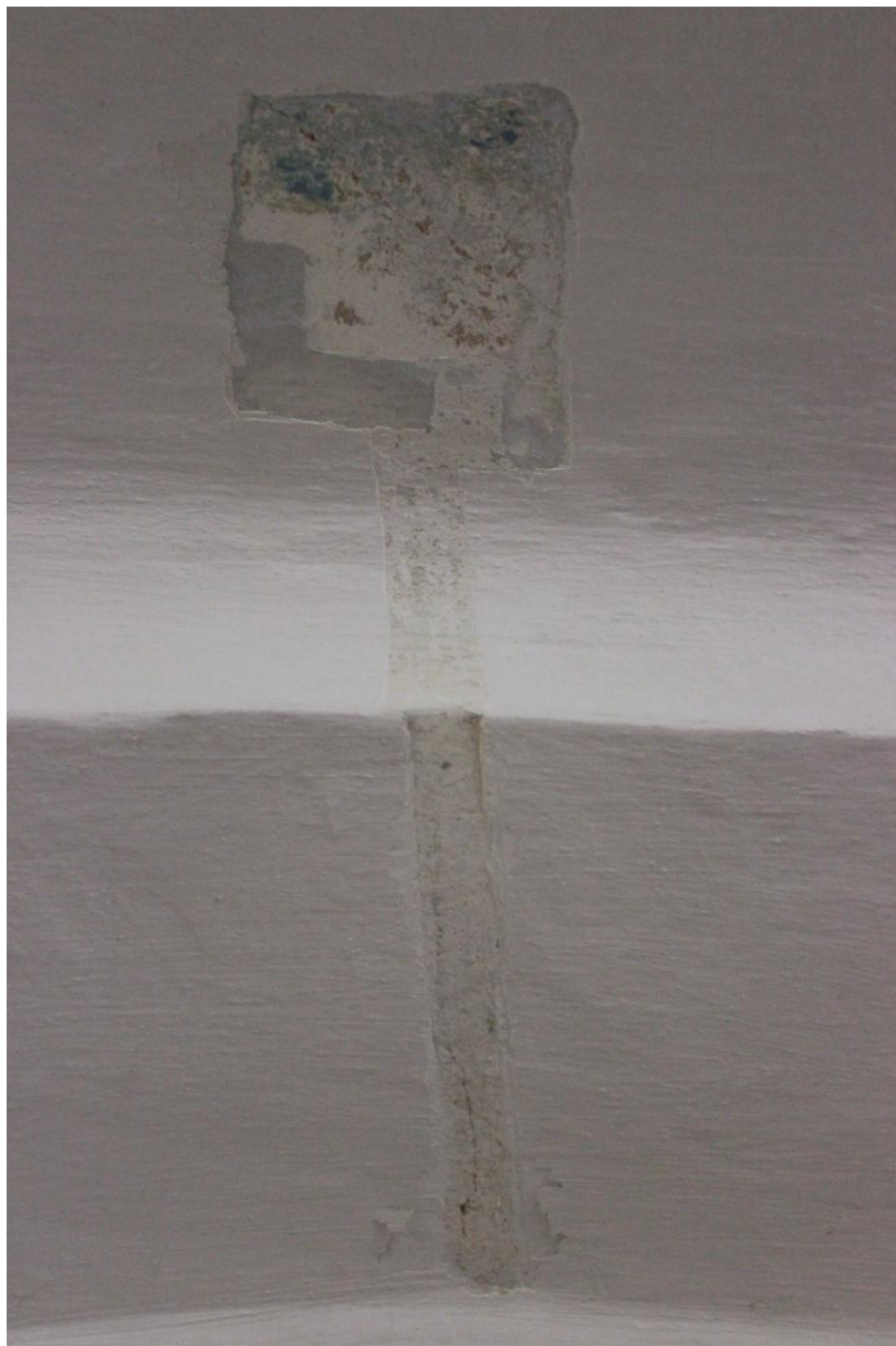
12.S.K.a./ Stratigrafie: 0-štuk, 1-slonová kost -vápenný nátěr. 2- zelená - vápenný nátěr. 3- tyrkysové květinové lístečky? 4-světle modrá – vápenný nátěr. 5- šedá- vápenný nátěr. 6- bílá – více nátěrů, současný stav.
