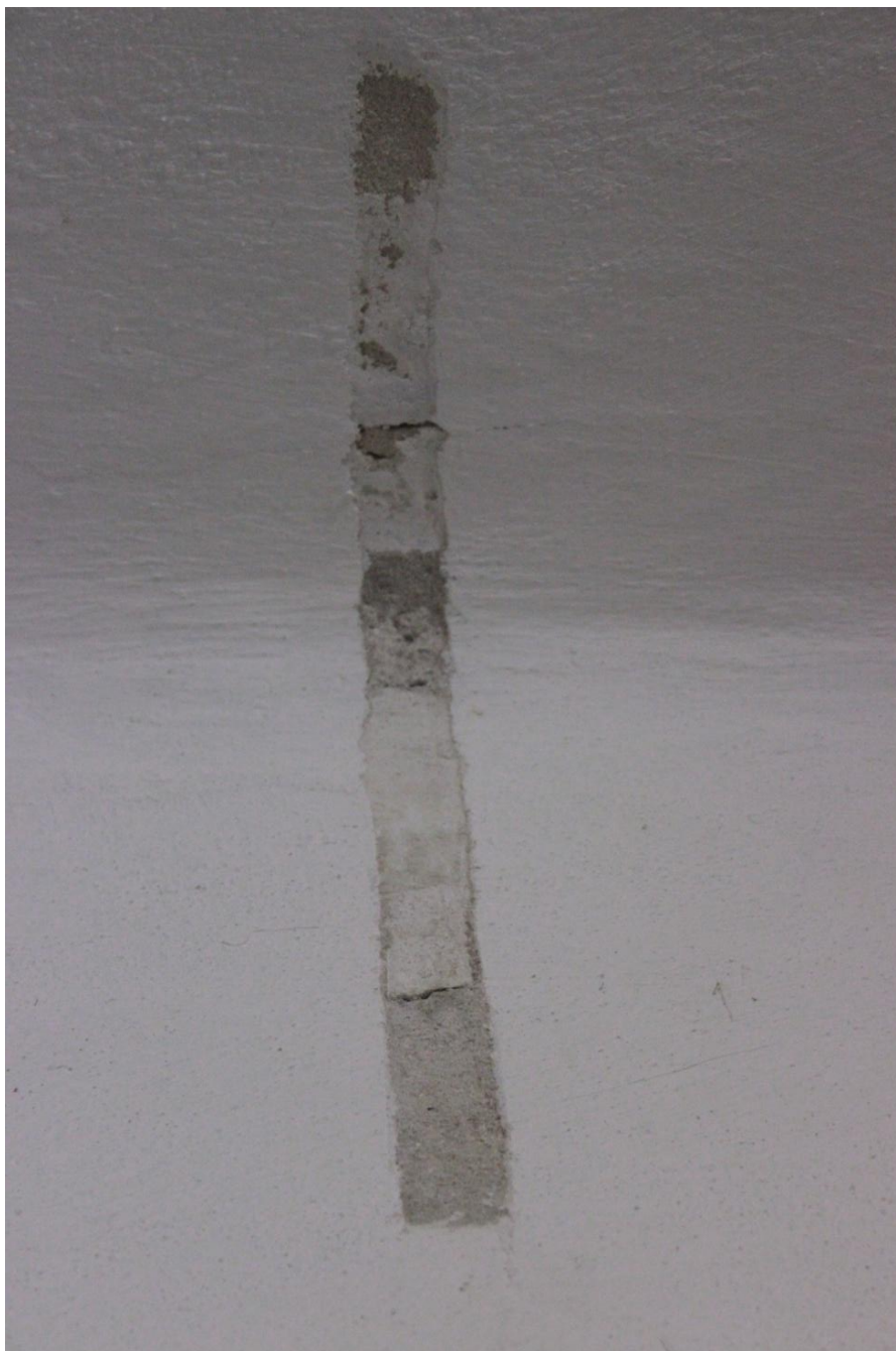
9.S.K.c/ . 0-štuk. 1- krémově bílá -vápenný nátěr. 2-světlešedá- vápenný nátěr. 3- světlemodrá - vápenný nátěr na stropě. 4- bílá – více nátěrů, současný stav. Novodobé cementové omítky.
