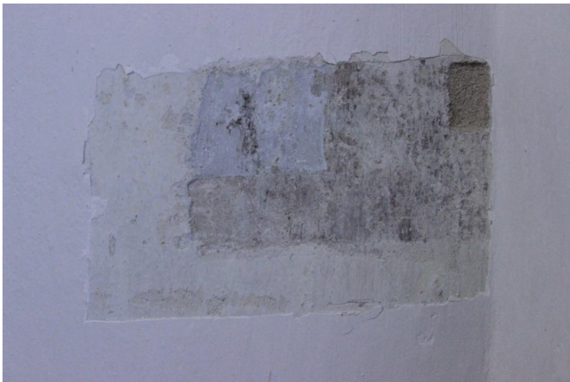
14.S.K.c/ Stratigrafie: 0-štuk, 1-šedá -vápenný nátěr. 2- zelená - vápenný nátěr. 3- fialová – hnědočervená. 4-světle modrá – vápenný nátěr. 5- světlezelená- vápenný nátěr. 6- bílá – více nátěrů, současný stav.
