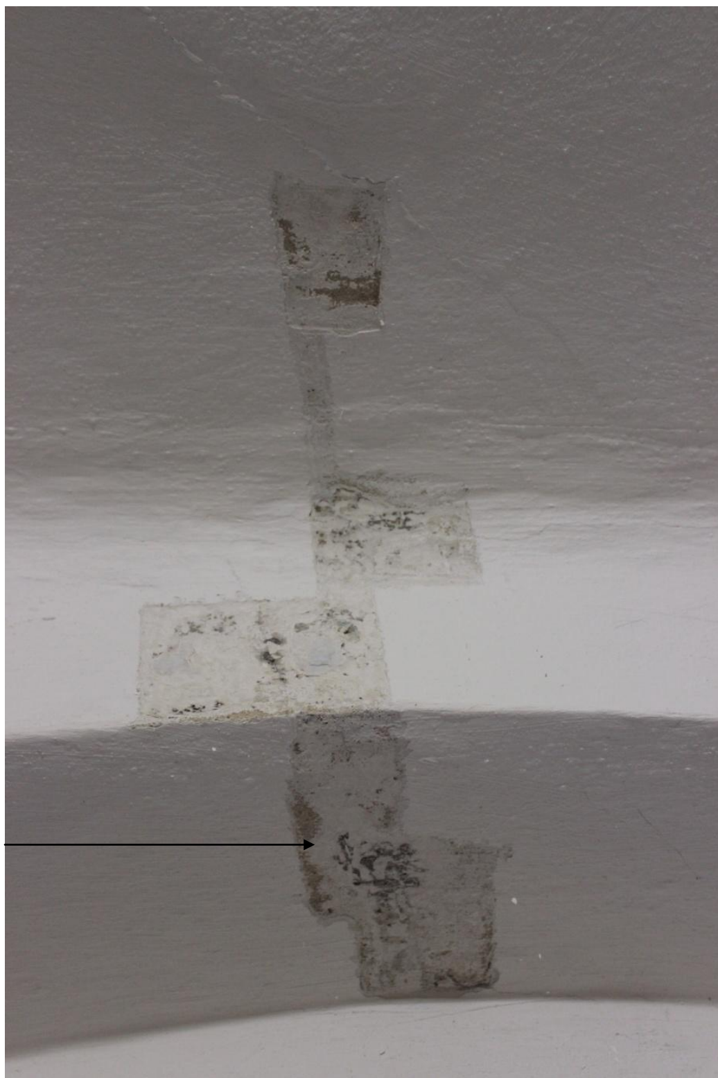
10.S.K.a/ Stratigrafie: 0-štuk, 1-bílá -vápenný nátěr. 2- tmavozelená- šablonový vlis, 3-světle modrá. 4- bílá - vápenný nátěr, 5.Současný stav.
