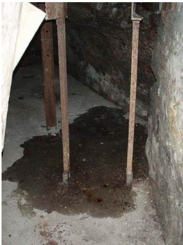
Foto 9: Následné cesty proniklé vody (podlaha v přízemí (sklepě) v místě napojení na navazující podzemní prostory na východní straně)
