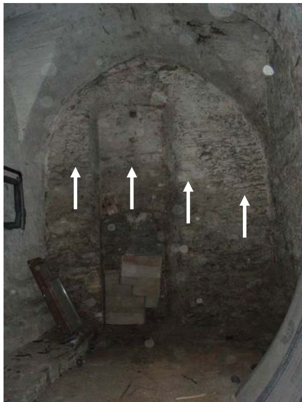
Foto 3: Přízemí, západní obvodové stěna pod úrovní terénu, kontinuální projevy vlhkosti na zdivu (šipkami naznačen okraj vlhkostní mapy)
