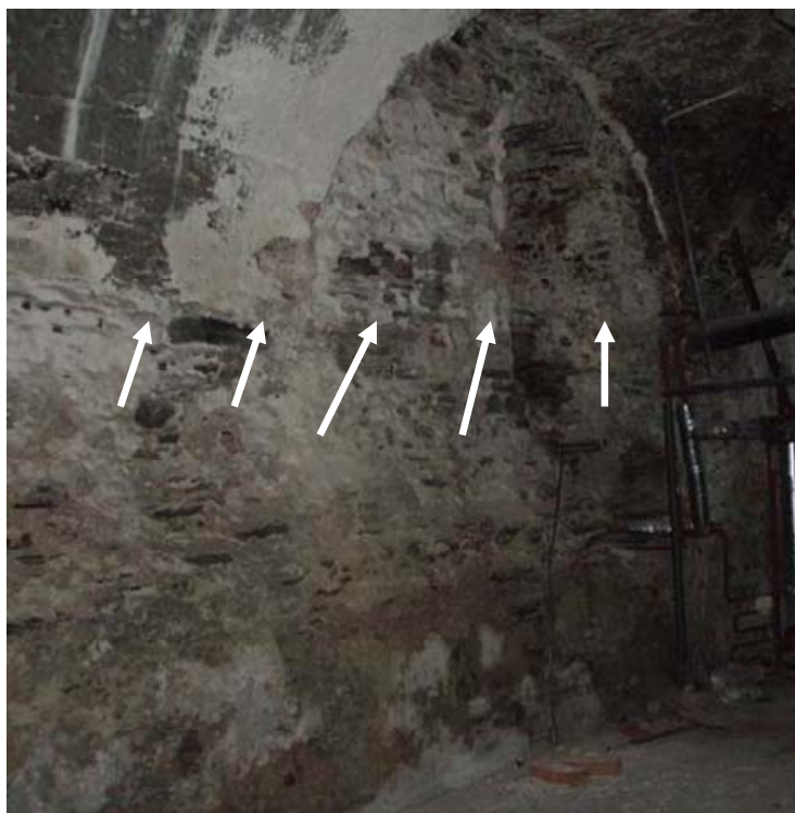
Foto 2: Přízemí, západní obvodové stěna pod úrovní terénu, kontinuální projevy vlhkosti na zdivu (šipkami naznačen okraj vlhkostní mapy)
