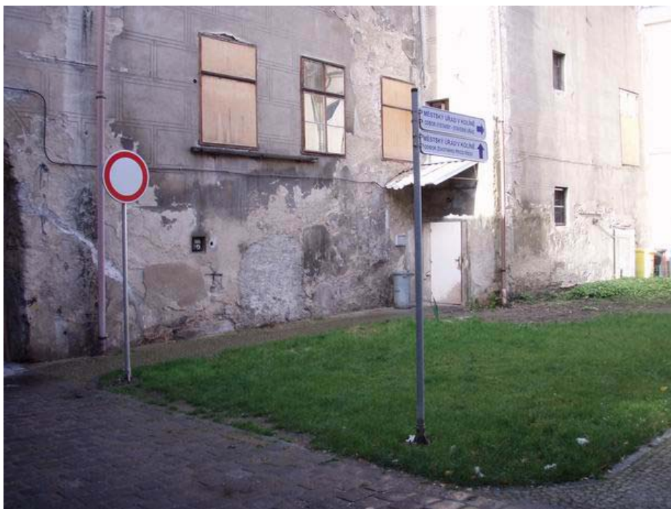
Foto 1: Východní obvodová stěna, kontinuální projevy vlhkosti na omítkách
