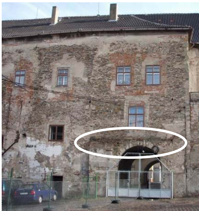
Foto 4: Západní obvodová stěna, akumulace vlhkosti a souvisejících projevů vlhkosti v místě konstrukčních výčnělků
