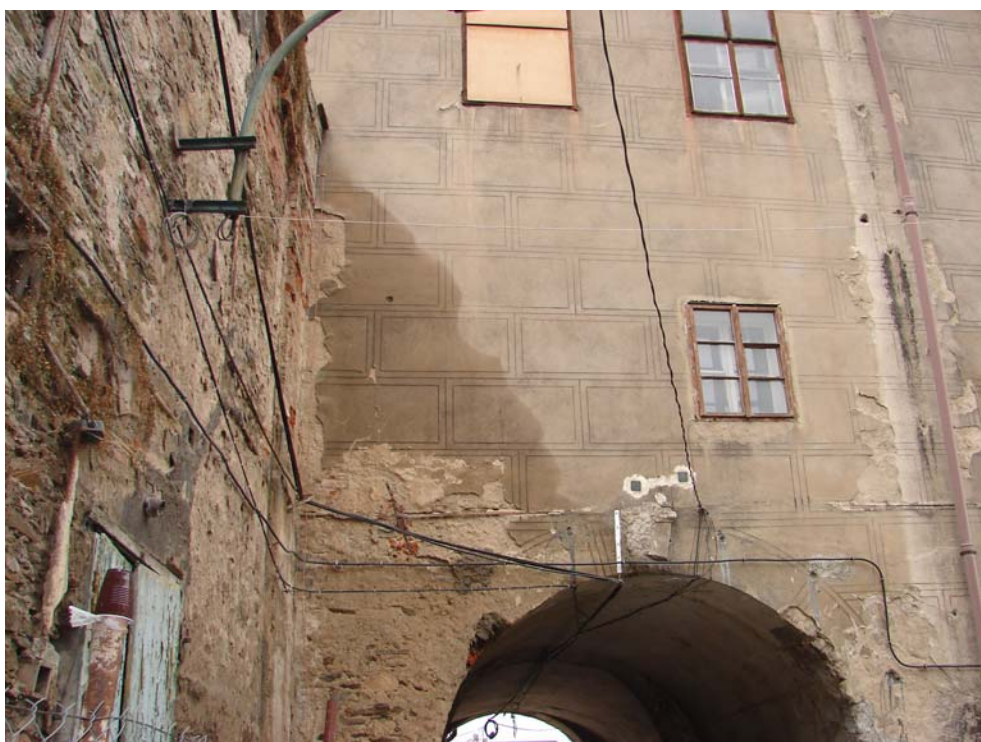
Foto 6: Východní (dvorní) obvodová stěna, zasažení vlhkostí z navazujícího objektu
