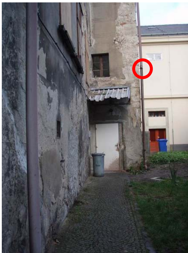
Foto 7: Místo porušení dešťového svodu
