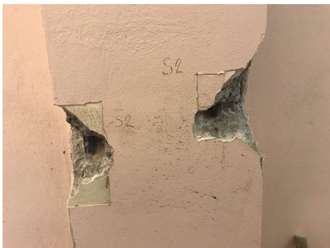
foto/24/ Zjištěná výztuž sloupu
