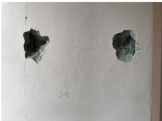
foto/22/ Zjištěná výztuž sloupu
