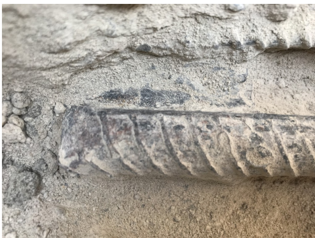
foto/20/ Detail navaření výztuže na ocelovou desku
