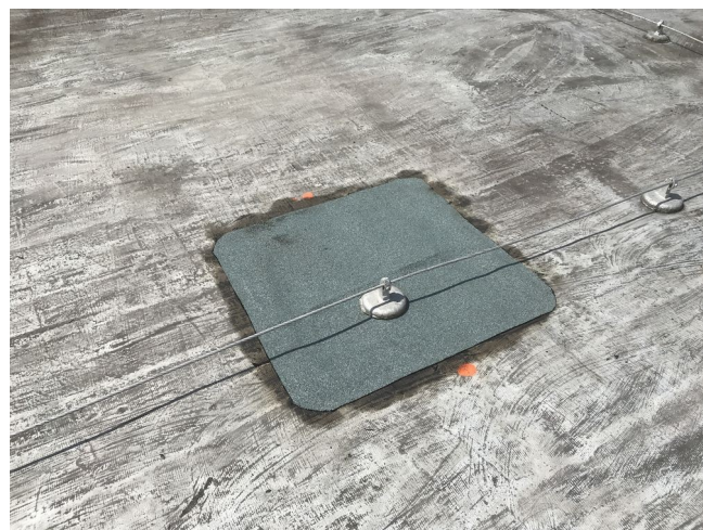
foto/21/ Zapravení provedené sondy
