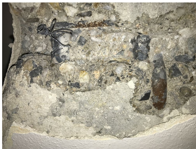
foto/7/ Detail zjištěné výztuže v průvlaku P2
