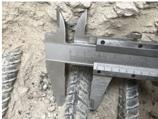
foto/19/ Zjištěný průměr hl. nosné výztuže (20 mm)
