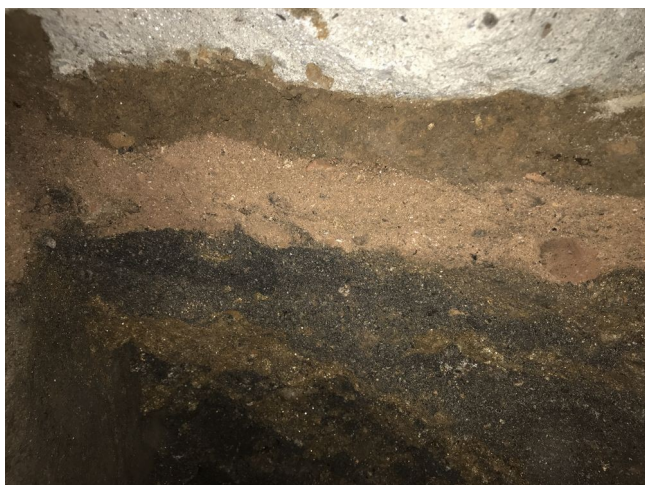
foto/33/ Skladba násypů pod betonovou mazaninou (mazanina, zemina, písek, škvára)
