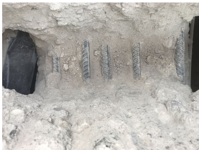
foto/11/ Zjištěná horní výztuž průvlaku
