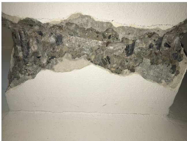
foto/4/ Zjištěná výztuž v průvlaku P1
