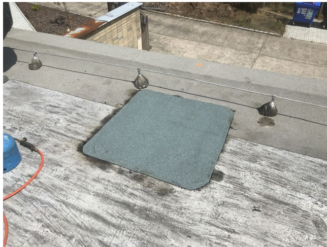
foto/15/ Zapravení provedené sondy
