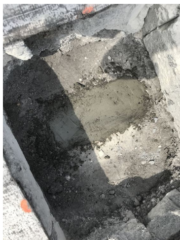
foto/14/ Zapravení ŽB konstrukce
