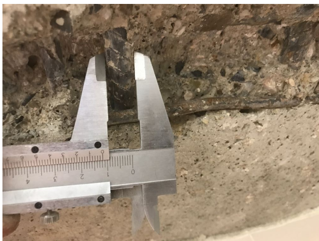
foto/26/ Hlavní výztuž panelu D1 (12 mm)
