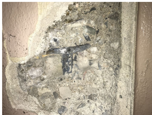
foto/25/ Detail zjištěné výztuže ve sloupu
