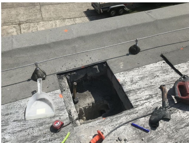
foto/10/ Pozice prováděné sondy
