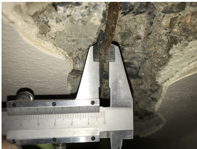
foto/9/ Zjištěný průměr třmínků (6 mm)
