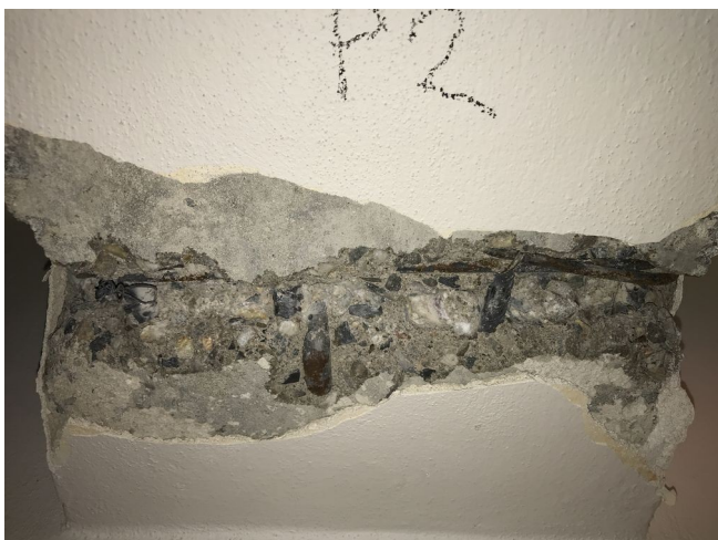
foto/6/ Zjištěná výztuž v průvlaku P2
