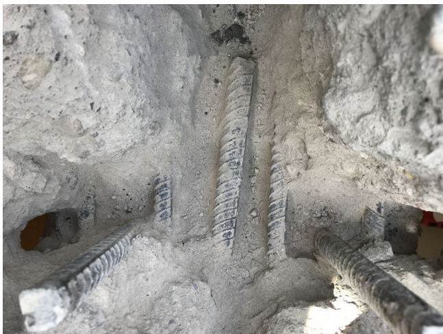
foto/18/ Zjištěná horní výztuž průvlaku
