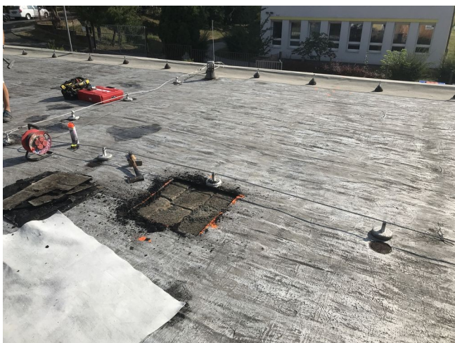
foto/16/ Pozice prováděné sondy
