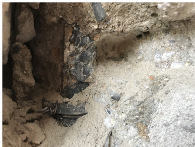
foto/23/ Detail zjištěné výztuže ve sloupu
