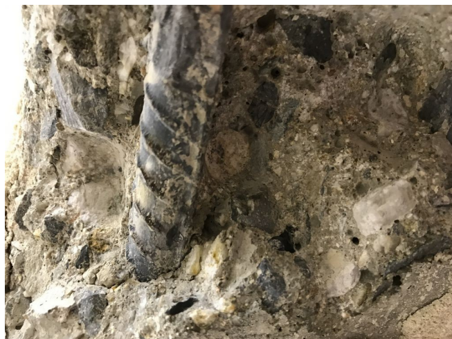
foto/5/ Zjištěná výztuž v průvlaku P1
