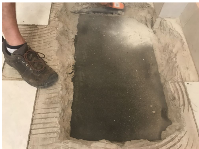
foto/34/ Zapravení hydroizolace z asfaltových pásů
