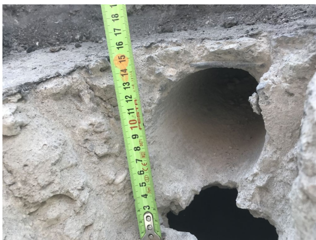
foto/12/ Zjištěná tloušťka dutinových stropních panelů
