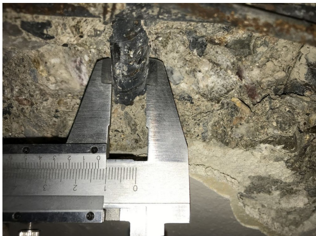
foto/8/ Zjištěný průměr hl. nosné výztuže (12 mm)
