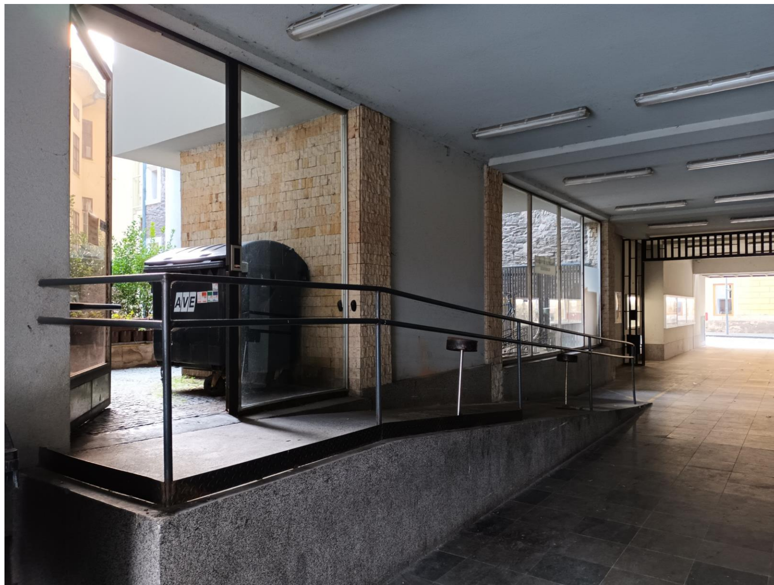
PRŮCHOD K ATRIU_STÁVAJÍCÍ STAV S RAMPOU A SOKLEM
