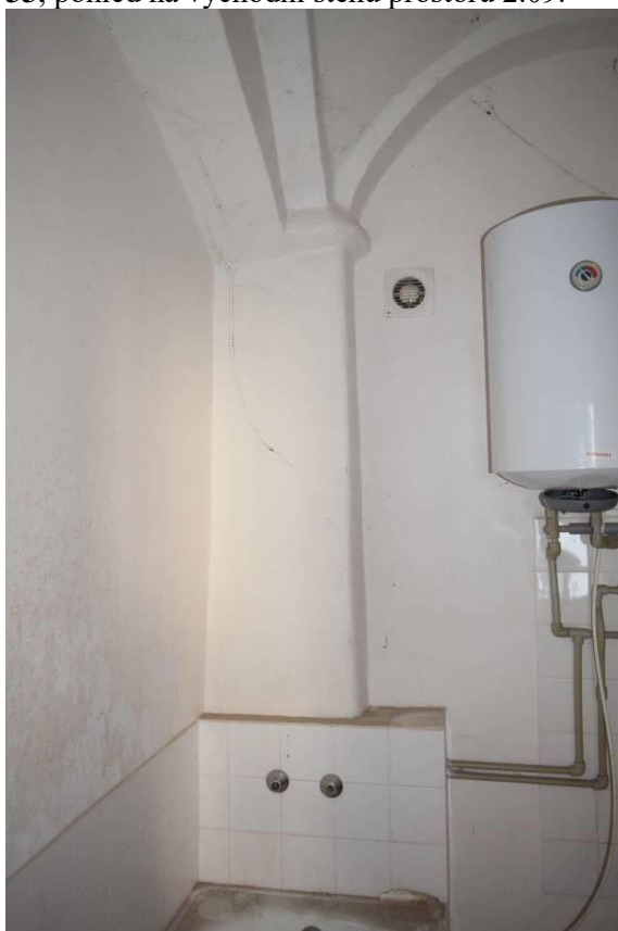
34, pohled na pilíř vynášející klenbu v prostoru 2.10.
