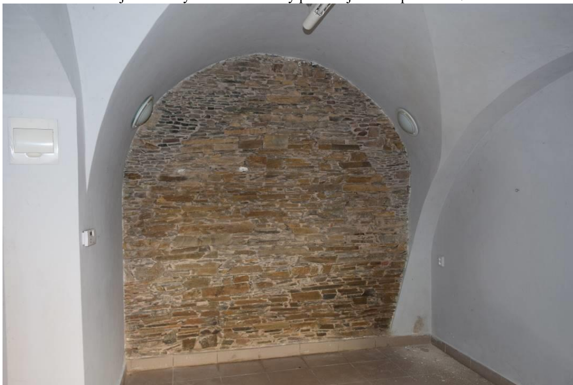
20 , pohled na západní stěnu prostoru 1.6. Na fotografii jsou vidět 2 fáze zazdivky.
