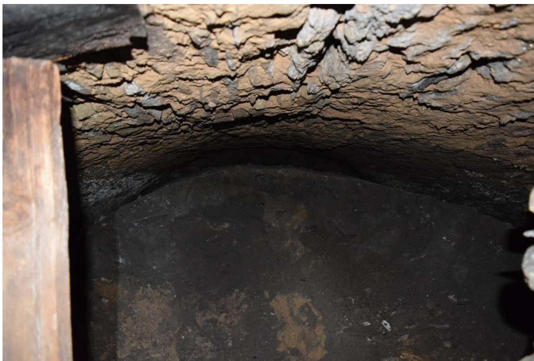
48 , pohled do hlavního prostoru sklepení směrem k východu. Zásyp tvoří z větší části popel.
