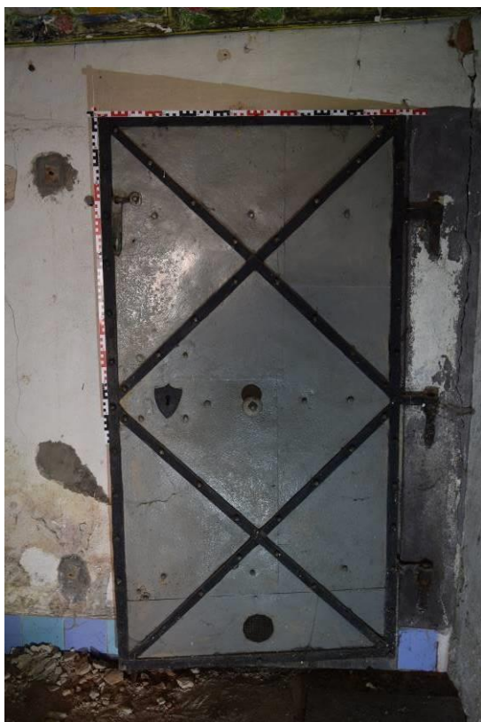
50 , detail vstupních železných dveří do prostoru 1.2. Dveře byly do prostoru doplněny po roce 1796.
