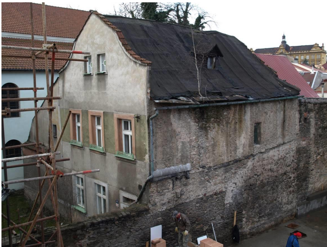
19 , pohled na dům č.p. 125 od severovýchodu. Vidíme, že severní obvodová stěna je postavena ve dvou fázích na parcelní zdi, která je zřejmě barokního či ještě staršího původu. Foto NPÚ, kolem roku 2013.
