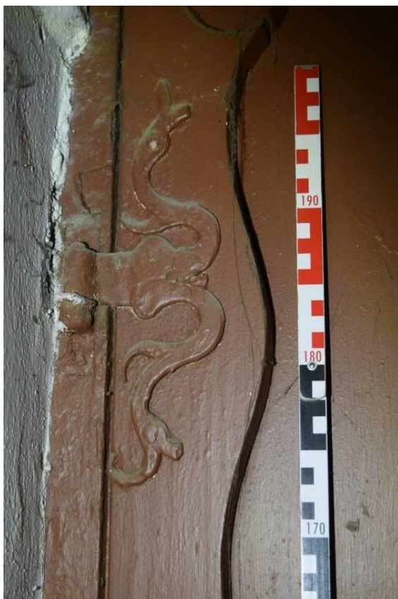
37, detail vnějšího kovaného závěsu dveří do podkroví.
