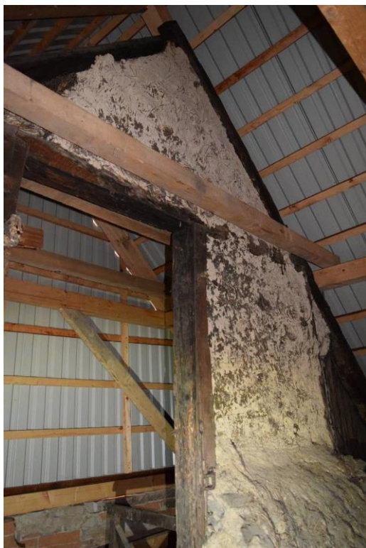
68 , detail hrázděné stěny ve východní části podkroví.
