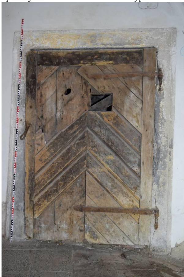
04 , detail vstupních dveří do sklepení. Dveře jsou dřevěné svlakové, na vnějších kovaných závěsech
