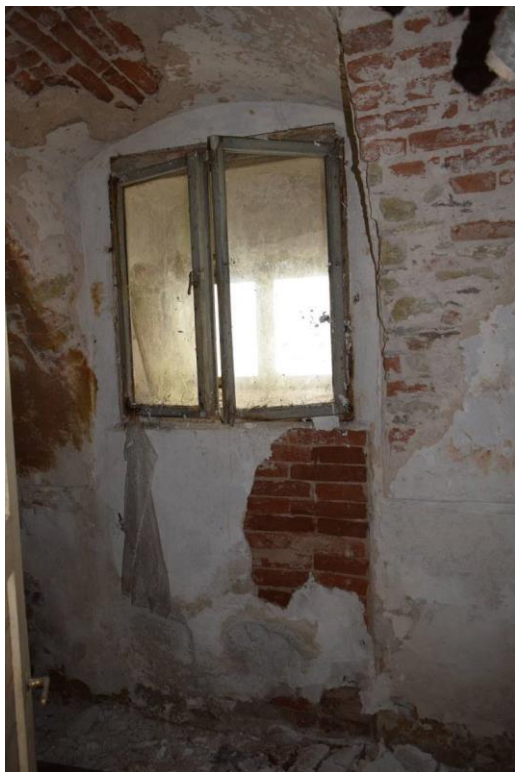
57 , detail druhotně zazděného vstupu, do kterého bylo v 1. pol. 20. stol. vestavěno okno
