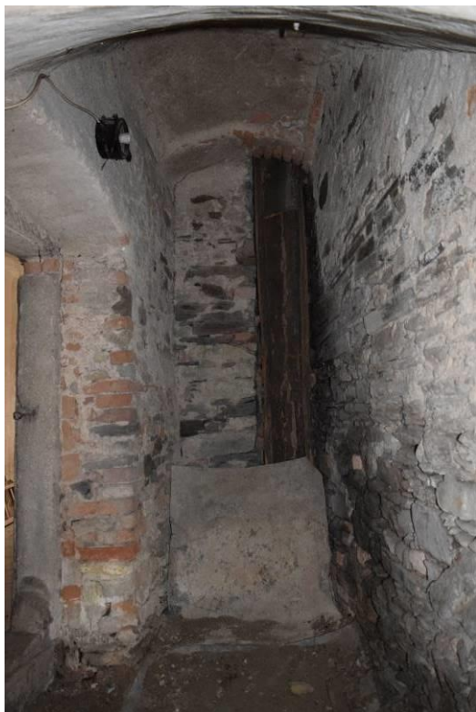
05 , pohled na západní stěnu za vstupem na schodiště do sklepení. Skrz klenbu prochází dřevěné koryto.
