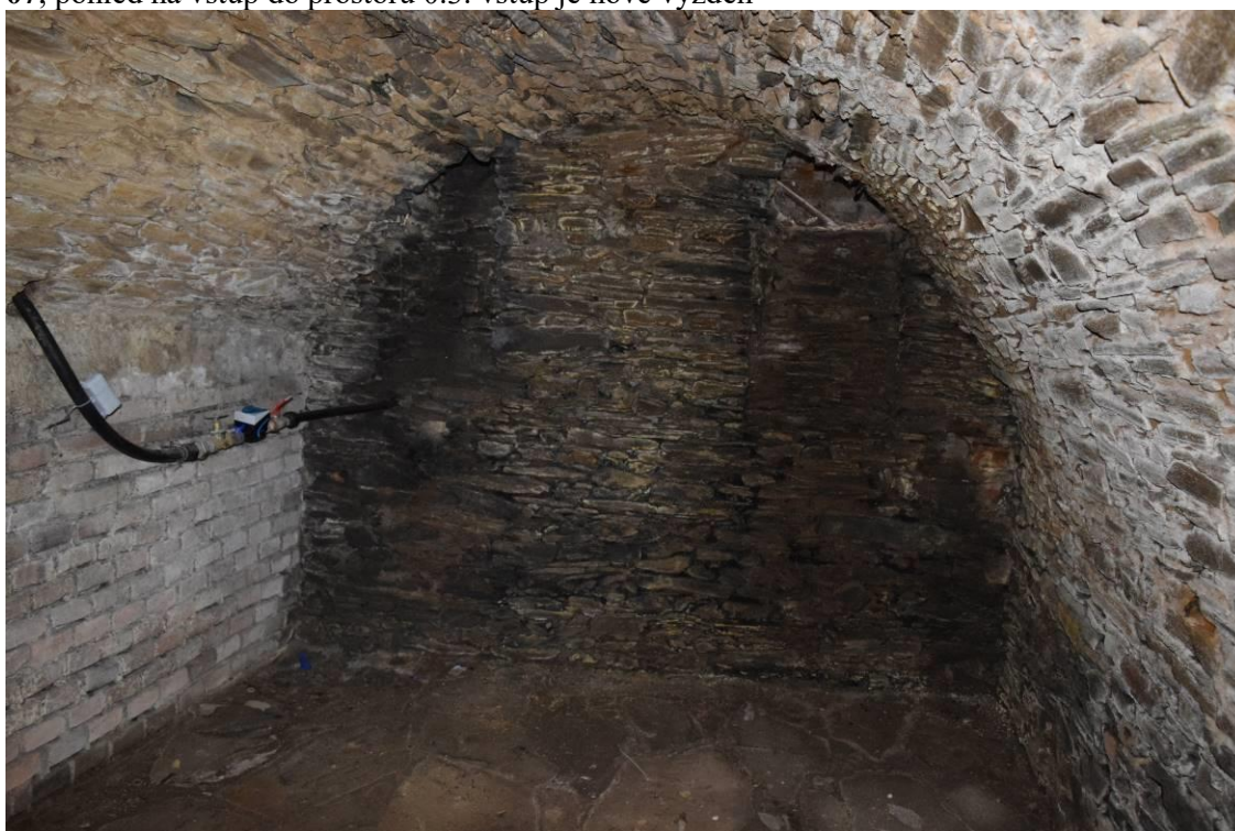
08 , pohled na východní stěnu prostoru 0.3. Po levé straně vidíme znovu vyzděnou stěnu z cihel.
