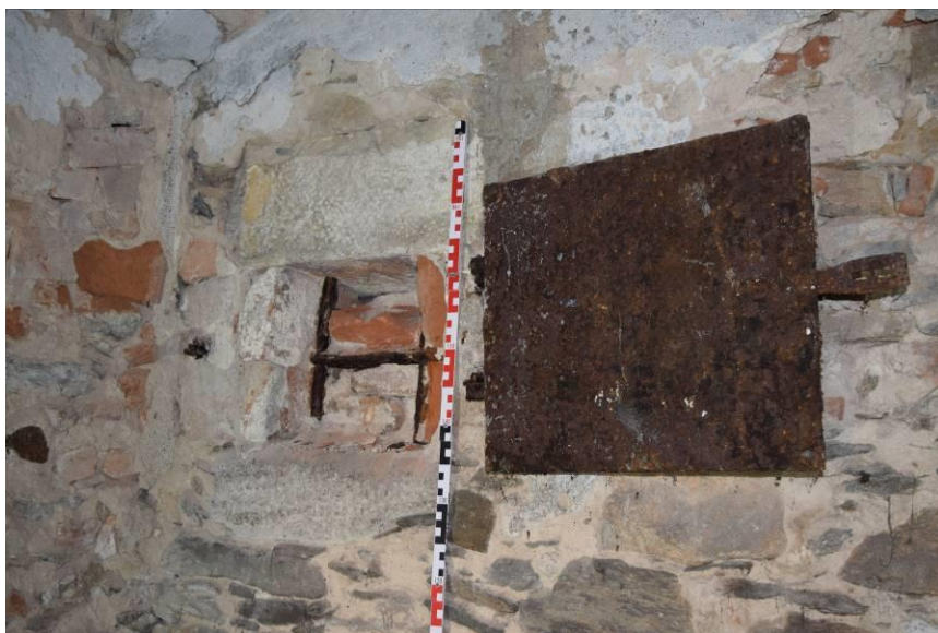
52 , detail druhotně zazděného okénka s železnou okenicí. Dveře spolu s řešením tohoto okna vede k domněnce, že prostor sloužil jako pokladna.
