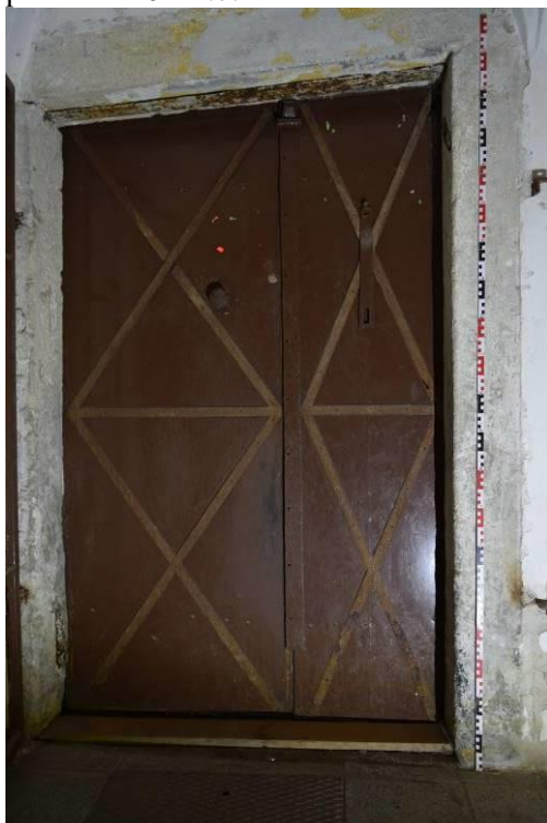
12 , pohled na vnější plochu dveří do prostoru 1.2. Dveře jsou opatřeny železnými pláty zpevněnými šikmými pásky. Dveře pocházejí nejspíše z doby po roce 1796.
