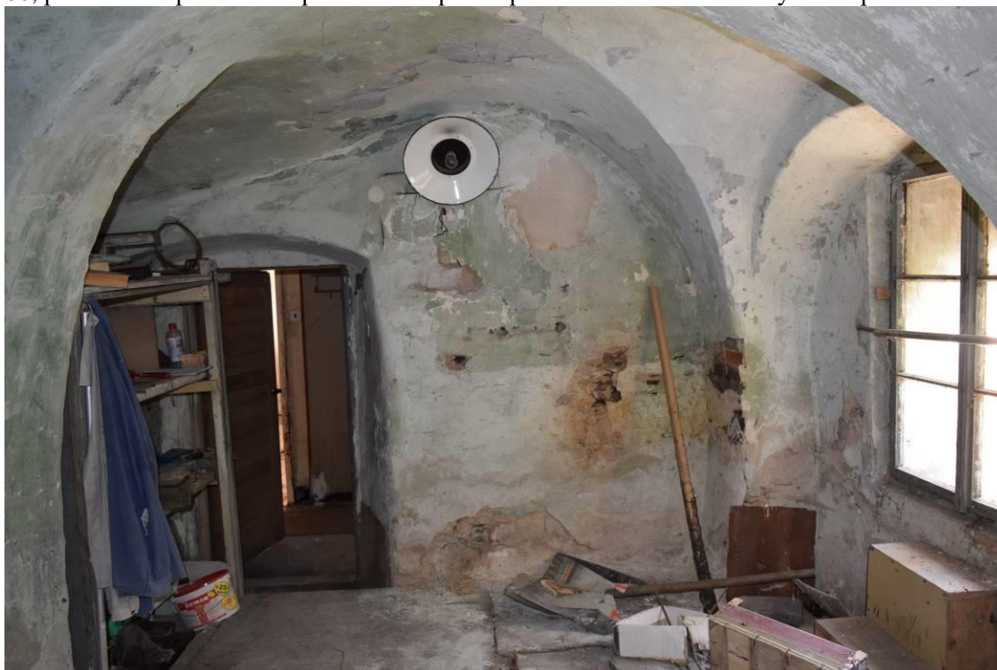
61 , pohled na východní stěnu prostoru 1.11 se vstupem, klenba v prostoru je pravděpodobně vložena druhotně.
