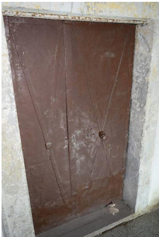
21 , pohled na železné plátové dveře do prostoru 1.6. Dveře pocházejí z doby po požáru Kolína v roce 1796.
