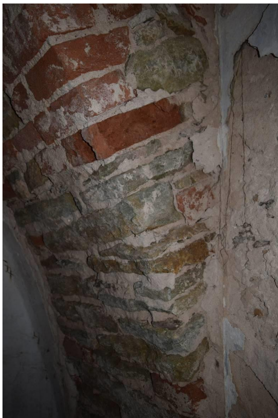
56 , detail výběhu valené klenby v prostoru 1.5. V klenbě je použito lomové zdivo s cihlami
