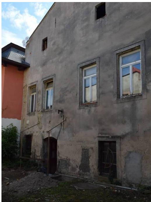
03 , dvorní fasáda. Ostění okenních otvorů jsou kamenná. Po straně okenního otvoru vpravo jsou vidět zazděná okénka. Výplně okenních otvorů pocházejí z 2.pol. 20. stol.
