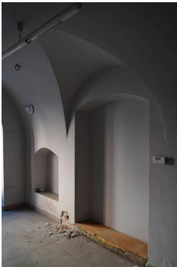
19 , pohled na východní část jižní stěny prostoru 1.6. Vidíme zaslepený vstup do chodby, odkládací niku a trojúhelnou výseč valené klenby pocházejí snad z počátku 17. stol.
