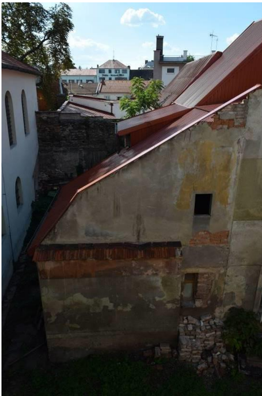
41, pohled na jižní část dvorní fasády. Poslední úprava fasády naznačuje, že tato část vznikla v jiné stavební etapě. Obvodové zdivo je ovšem v přízemí postaveno současně. Zesílený úsek zdiva je pravděpodobně pozůstatek dvorního stavení.
