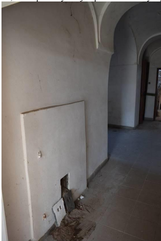
26, detail zazděného příkladacího otvoru v severní straně prostoru 2.1.
