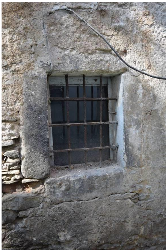
46 , detail kamenného ostění okna v jižní fasádě. Kamenné ostění může být renesančního původu.
