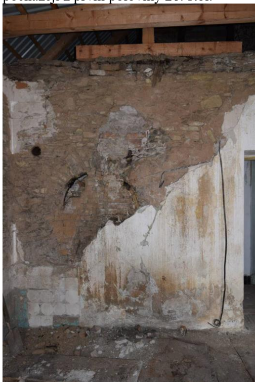
63 , detail západní stěny prostoru 2.3. Ve zdivu je vidět zaklenutí otvoru pro odvod kouře do komína.
