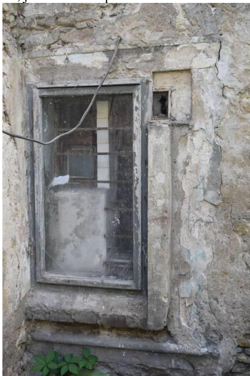
45 , v současné době okenní otvor v západní fasádě. Původně šlo o vstup, jak naznačuje spodní schodištní stupeň.
