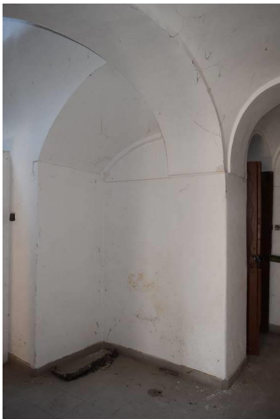
25, detail pilíře vynášející plackové klenby v prostoru 2.1
