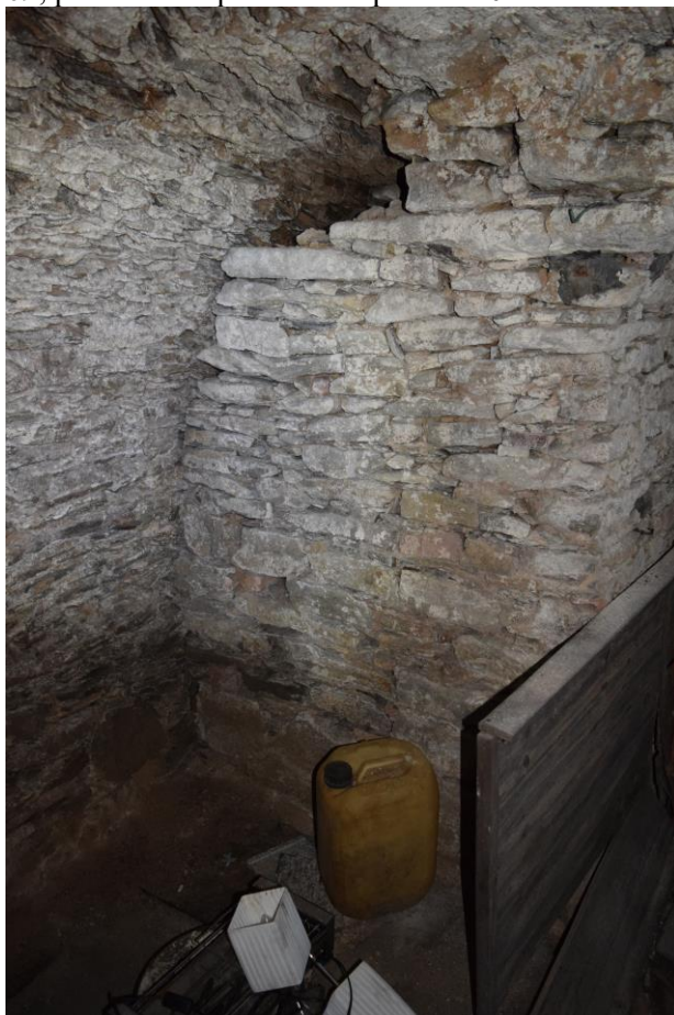
10 , pohled na severní dělicí stěnu se vstupem v prostoru 0.4. Stěna není provázána s klenbou.
