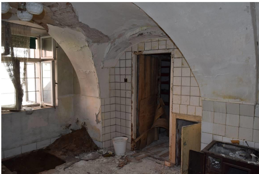
54, pohled na jihovýchodní kout prostoru 1.4. Do prostoru byla vložena valená klenba s protilehlými výsečemi.
