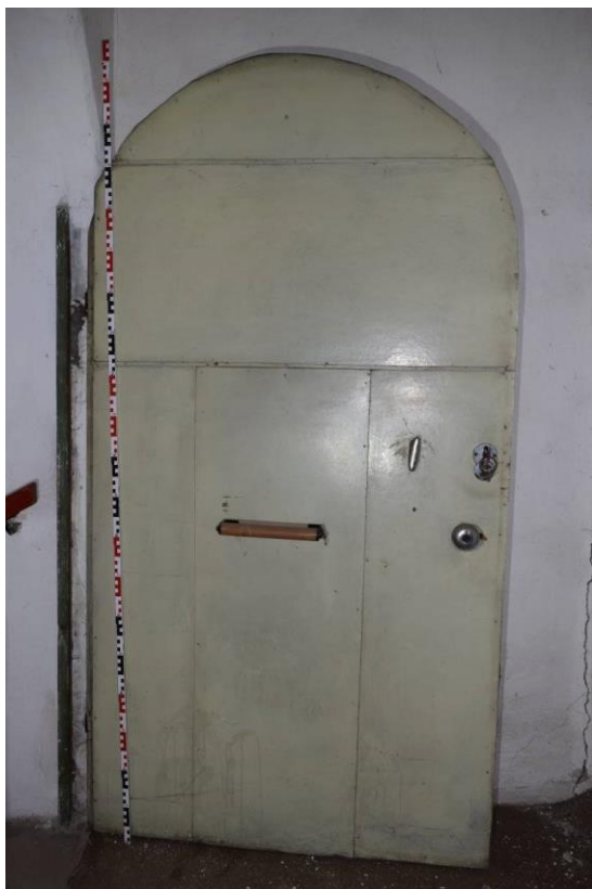
62 , detail dveří při vstupu do patra. Dveře jsou dřevěné opatřené plechovými pláty. Dveře pocházejí z první poloviny 20. stol.
