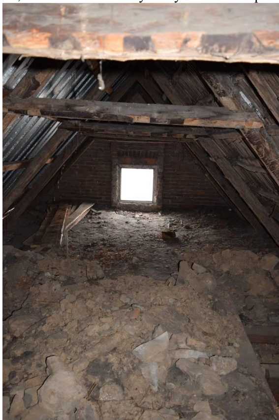
69 , pohled do prostoru krovu západní části. Střecha na pravé straně má dochovaný jako krytinu štípaný šindel.
