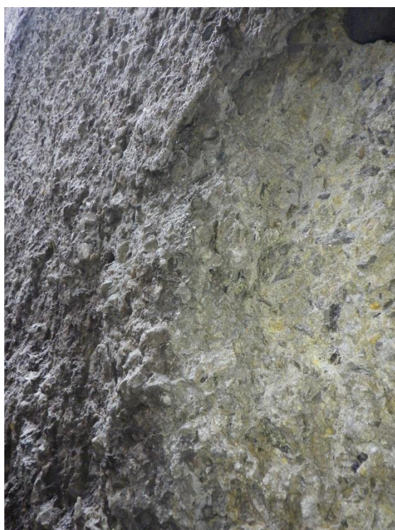
Obr. č. 5: detail stěny ve spodní části – povrch betonu se drolí, 20-30 mm lze lehce odstranit rukou, hlouběji nasoudrzném betonu je patrna poměrně jasně žlutá usazenina
