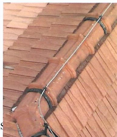
držák hřebenové latě. Do držáku bude následně instalována hřebenová lať 40/60. Na hřebenovou lať bude provedena instalace samolepícího pásu pro odvětrání hřebene a nároží. Pomocí přichytky hřebenáče pak budou instalovány jednotlivé hřebenáče TONDACH č. 2, šíře 21 cm. V hřebenové rovině jsou i
