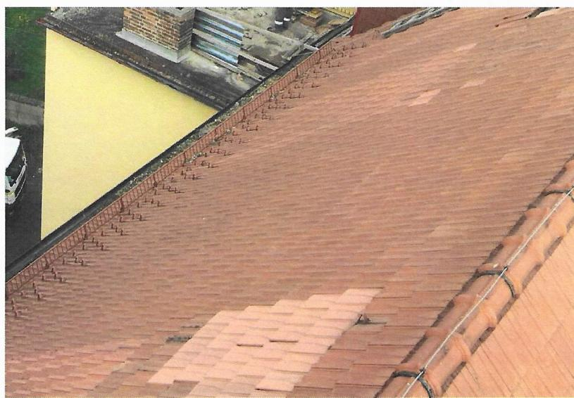
Jak již bylo zmíněno, překládání krytiny v ploše bude probíhat po etapách v jednotlivých pruzích o max. šířce 4m. Rozebrané jednotlivé tašky budou přesunuty na zem a uskladněny narovnáním na palety. Jednotlivé latě budou vyřezány, demontovány a
