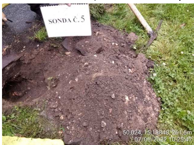
Sonda S5 – materiál v podloží betonové desky
