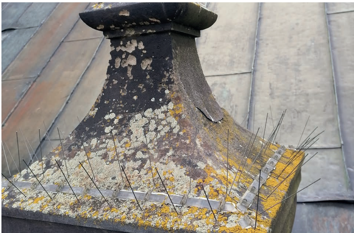
Detail biologického napadení lišejníky na vrchní části kamenné vázy
