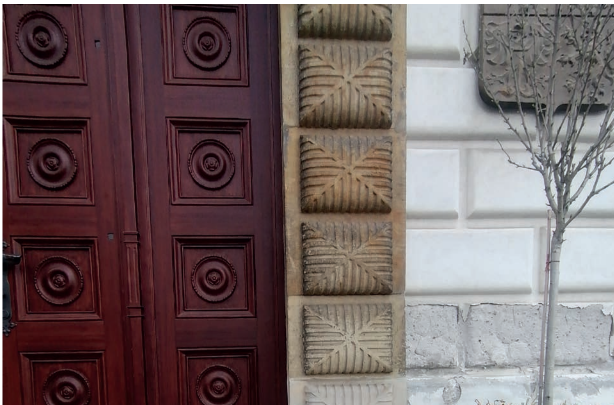
Černá oxidace bosovaných kvádrů vstupního portálu na jejich vrchní části způsobená exhaláty a kyselými dešti
