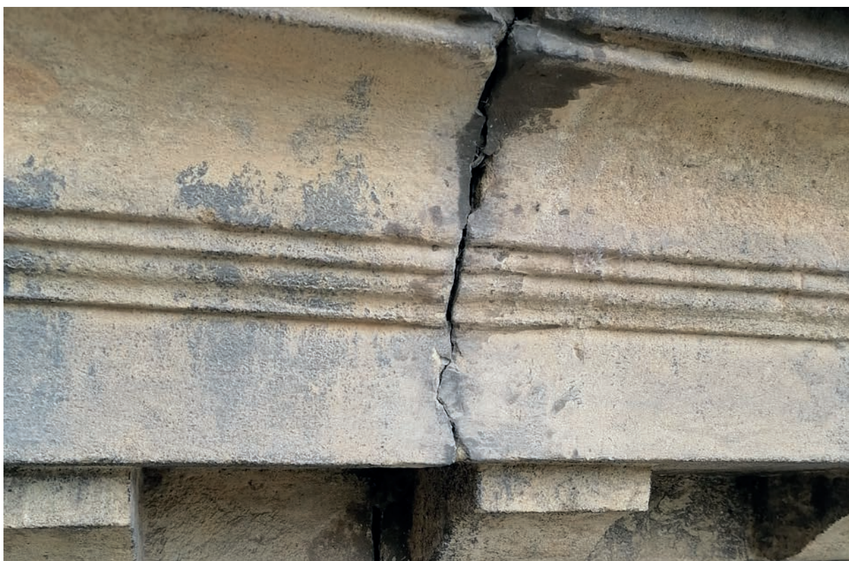
Chybějící spárování segmentů vrchní profilované římsy vstupního portálu
