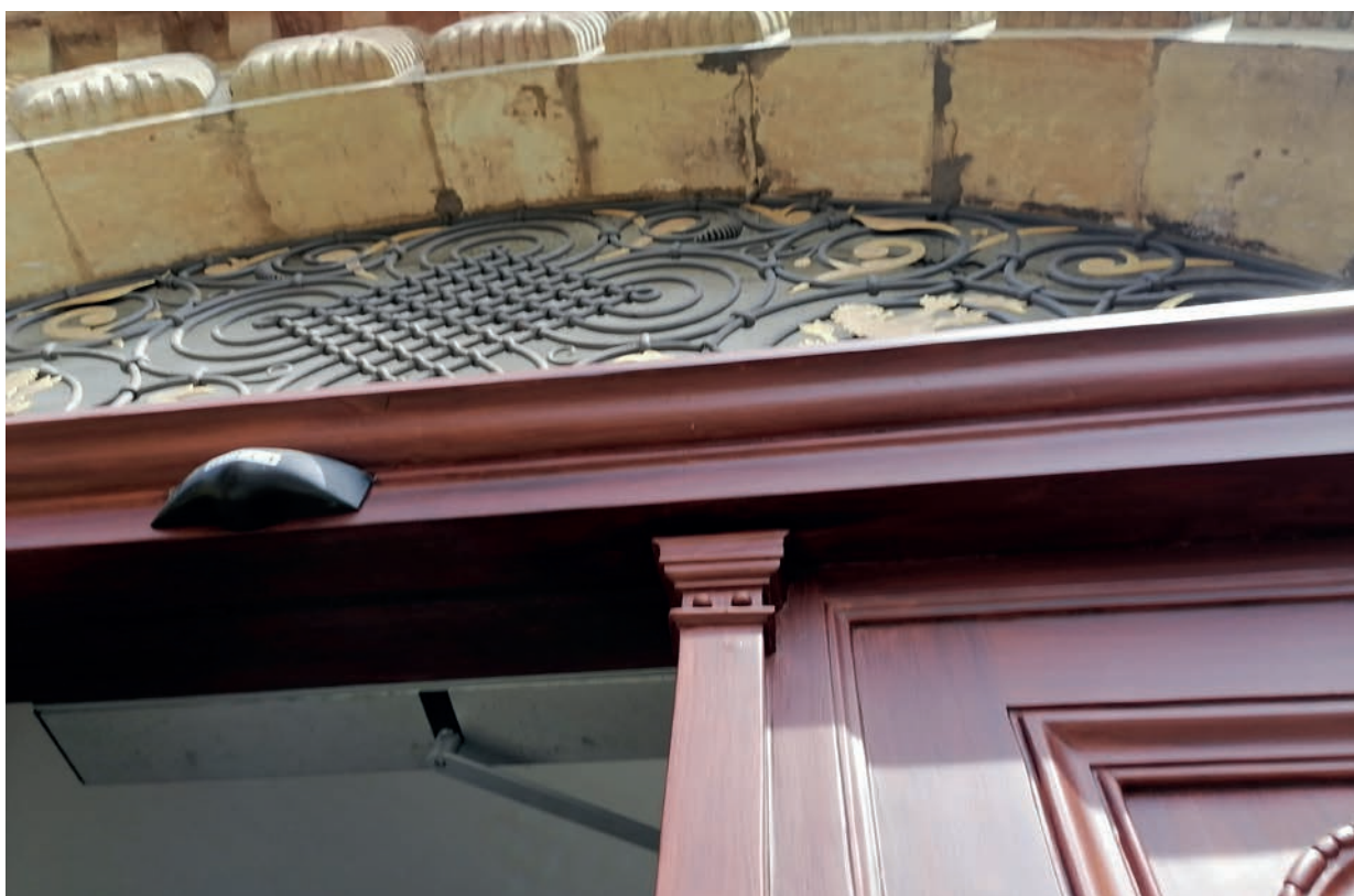
Pohled na spodní část oblouku vstupního portálu se stopami po zatékající srážkové vodě z profilované římsy
