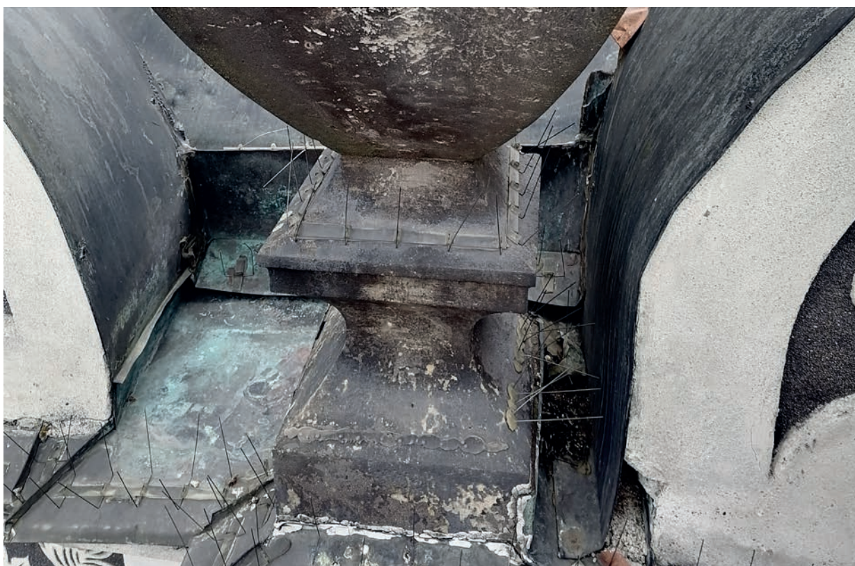
Detail biologického napadení cementových doplňků u kamenné vázy
