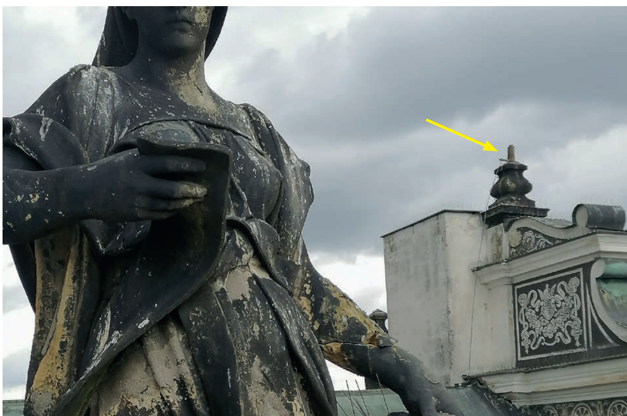
Chybějící trn s makovicí na kamenné noze
