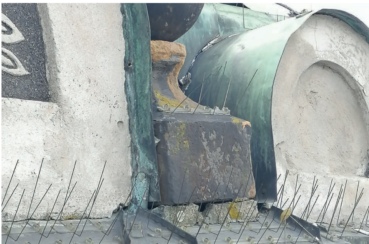
Poškození soklové části u kamenné čučky
