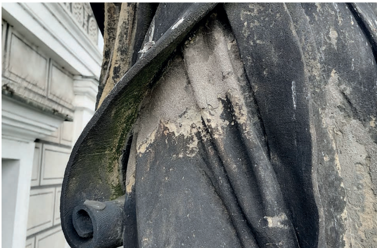
Detail poškození drapérie sochy Moudrost
