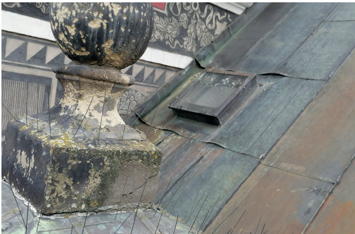
Čučka s biologickým napadením a degradací kamene
