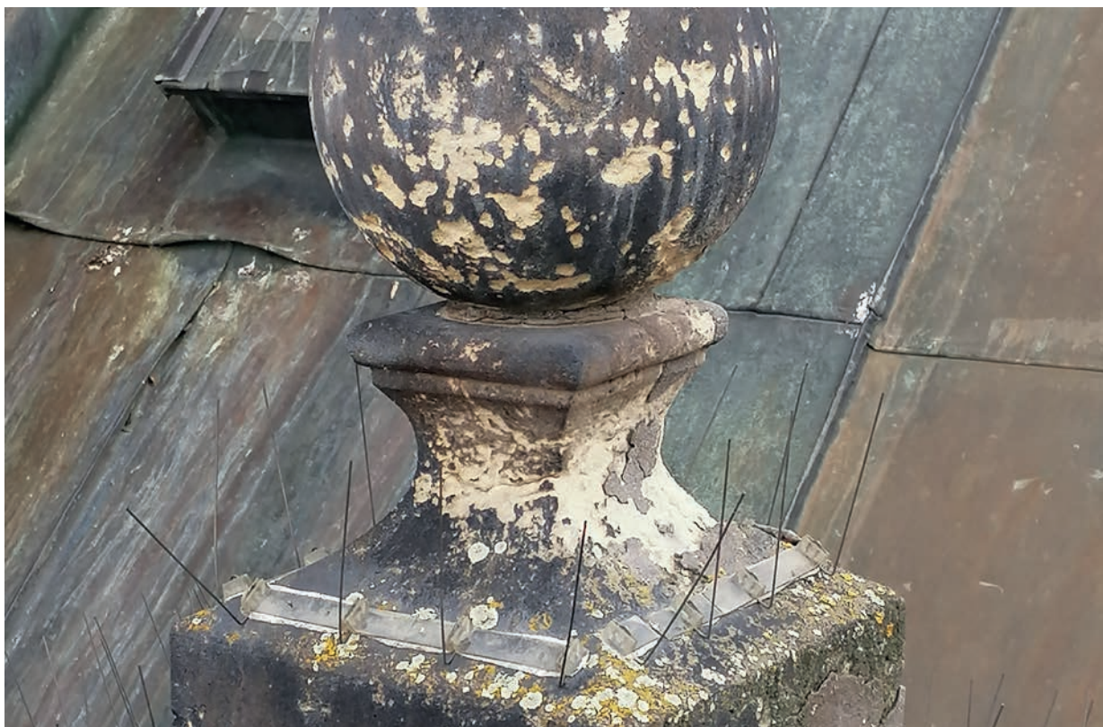
Detail poškození kamenné čučky vlivem biologického napadení
