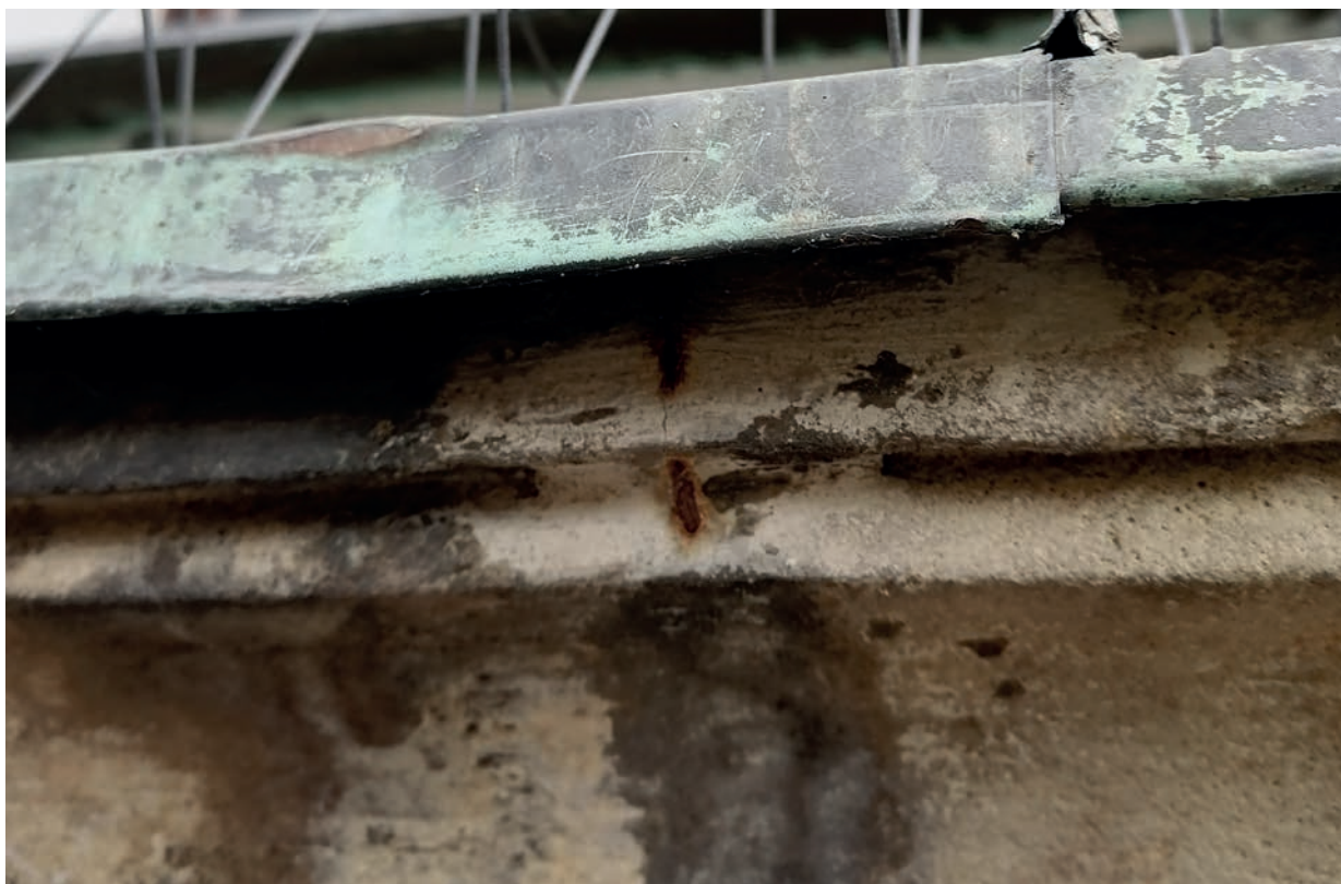
Detail římsy vstupního portálu z měděného plechu propouštějící srážkovou vodu
