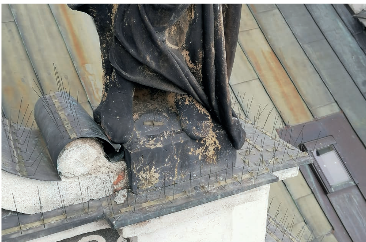
Detail poškození nohy a soklové části sochy Moudrost
