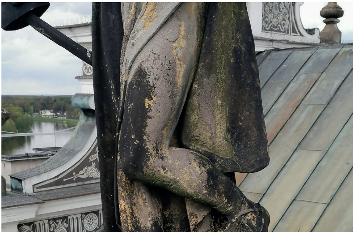
Pohled na levou nohu a část drapérie sochy Síla, kde je původní modelace nahrazena cementovým tmelem
