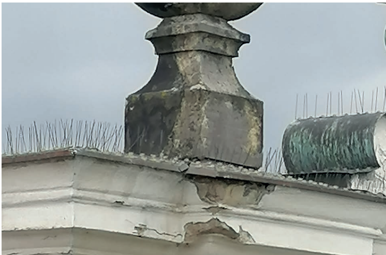
Pohled na poškozenou nohu kamenné vazy
