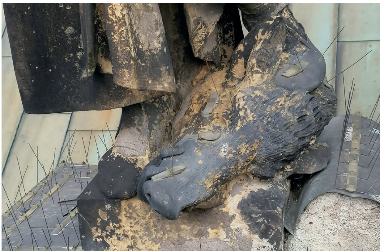
Detail poškození soklu a skoleného kance stékající srážkovou vodou u sochy Síla
