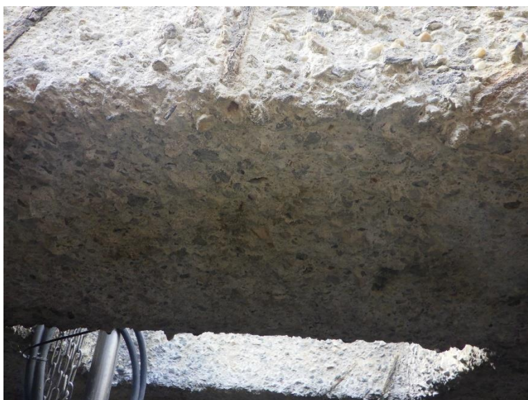
Obr. č. 4: strop mezi odvětrávacími otvory
