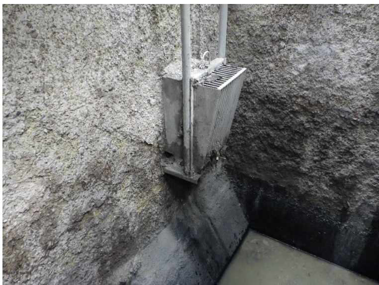
Obr. č. 3: východní a severní stěna ve spodní části nádrže
