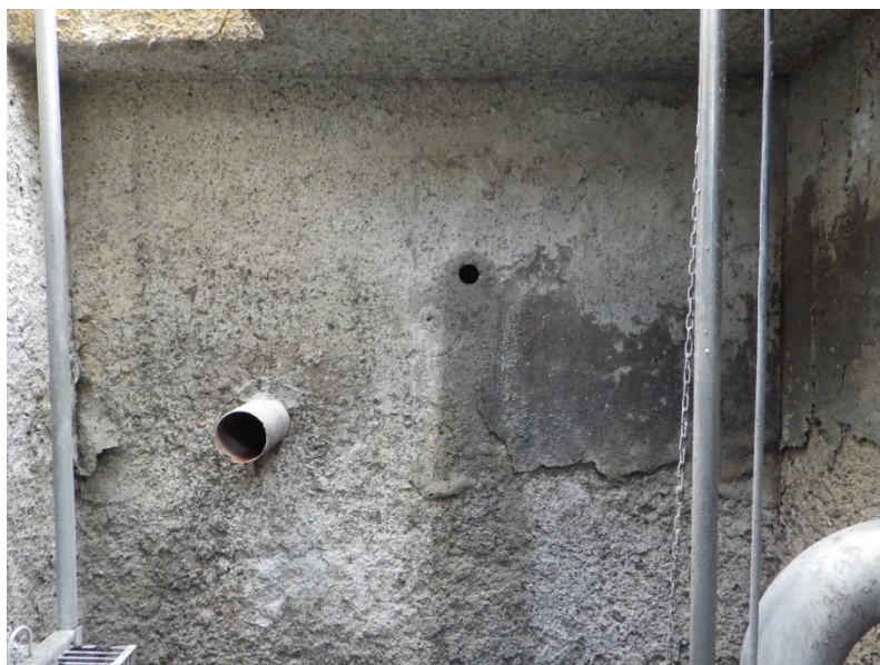
Obr. č. 2: východní stěna v horní části se zbytky původního líce
