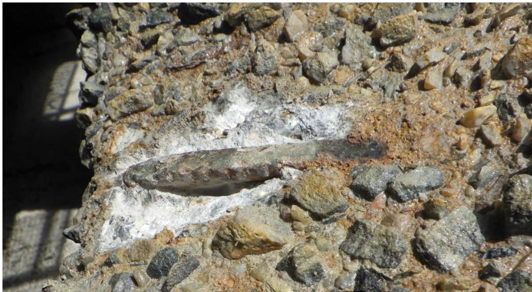
Obr. č. 25: prut výztuže na boku prostupu stropu.
